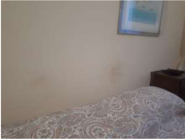
F.to 9: Macchie di umido camera letto e vista bagno
