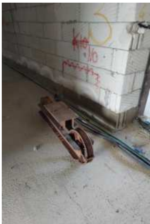
Figg.35-36 – Vista di dettaglio dei binari e delle pulegge del vano ascensore in stato di abbandono (piano rialzato).
