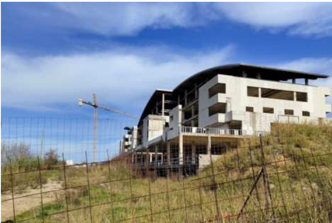
Fig.2 – Vista su immobile e terreni al Fg 36 P.lle 4415-4418 da via D.G. Rossetti verso via Histonienne
