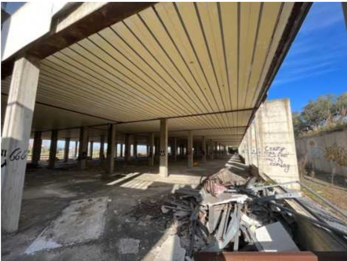
Fig.4 – Vista su immobile e terreni al Fg 36 P.lle 4415-4418 (primo piano interrato).
