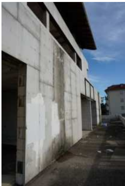
Figg.47-48 – Vista del balcone di testata posto a sud con dettaglio dello stato di degrado di facciate e solai (piano rialzato).
