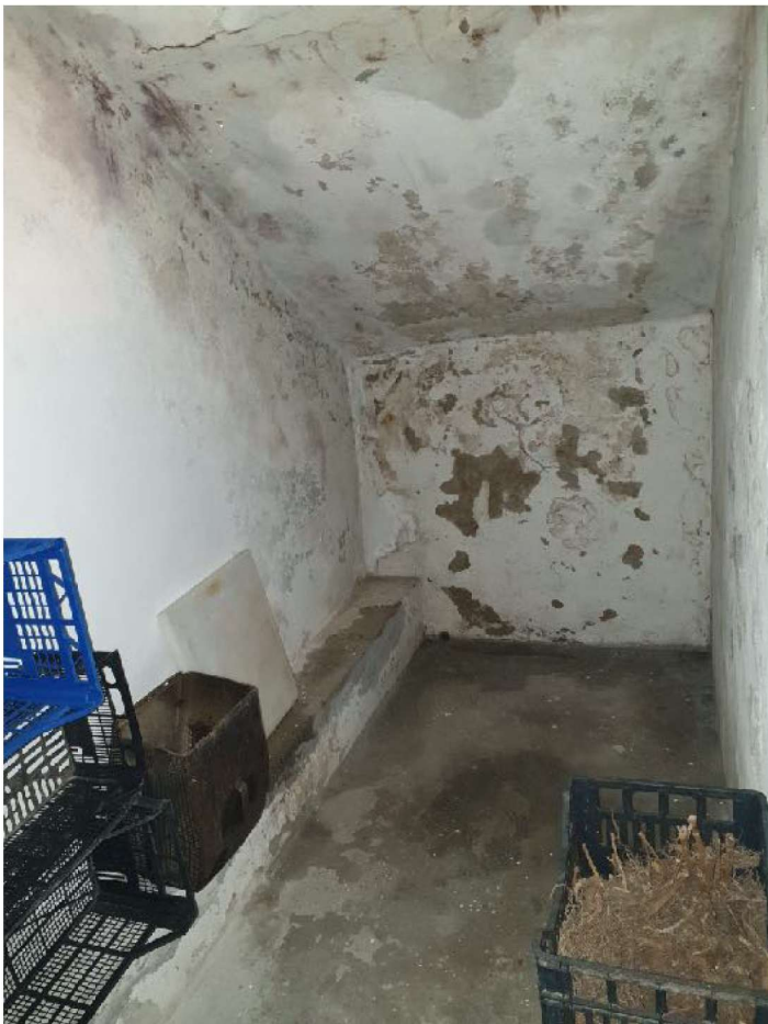
FOTO 41. Ripostiglio sottoscala a piano terra
