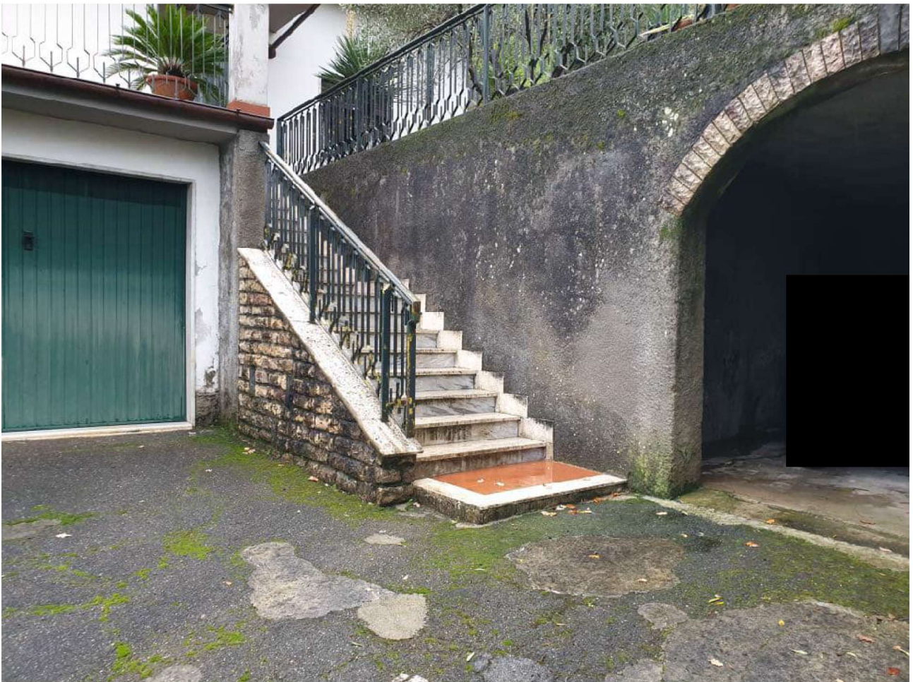
FOTO 68 e 69. Scala esterna di accesso a piano primo
