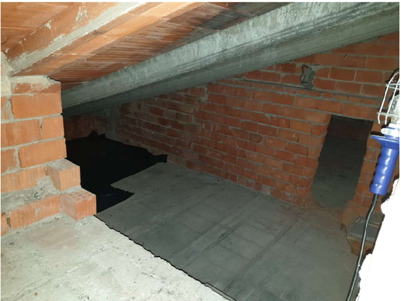
FOTO 51. Sottotetto posto in corrispondenza della cucina e della zona pranzo
