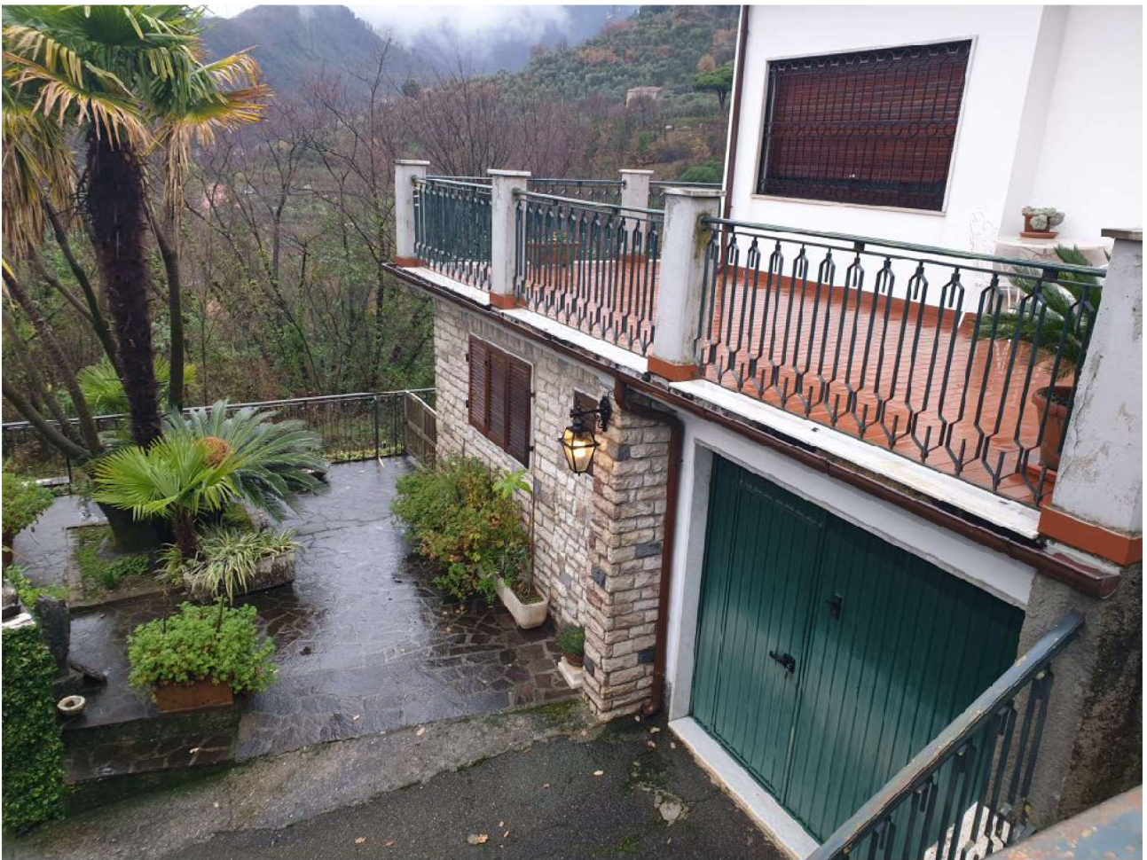
FOTO 66. Pertinenza esterna del fabbricato e prospetto sud-ovest
