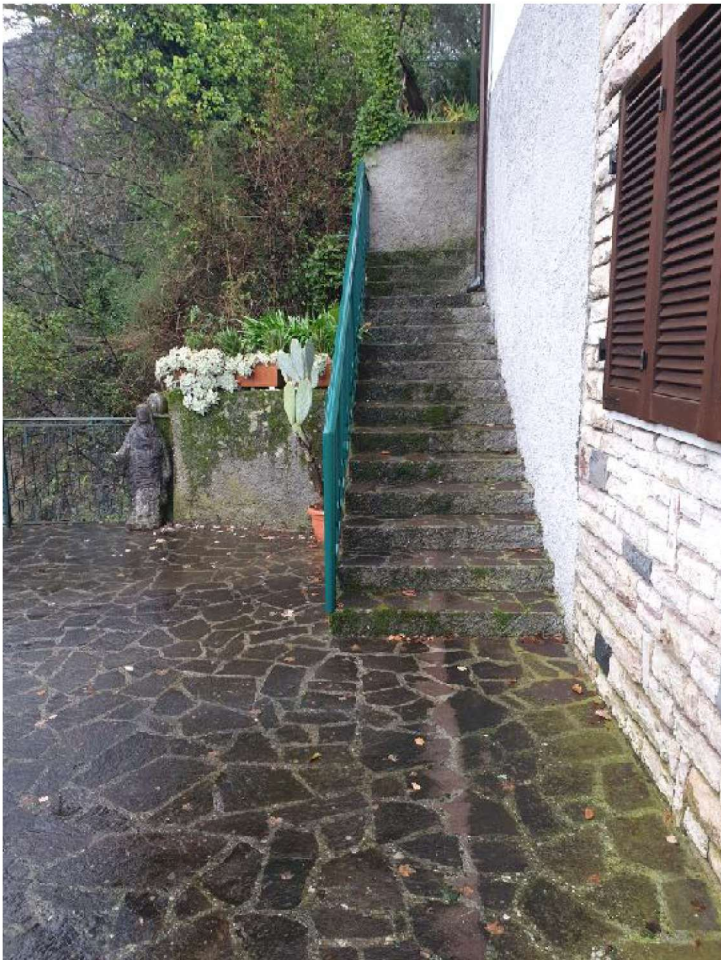
FOTO 58. Area di pertinenza a nord-ovest e scala che conduce a pertinenza sul retro del fabbricato
