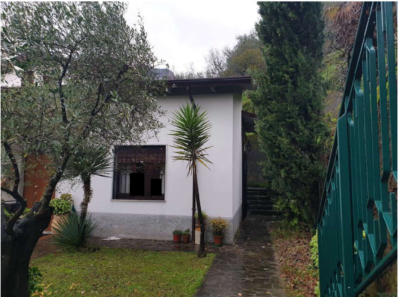
FOTO 65. Pertinenza esterna del fabbricato e prospetto sud-ovest
