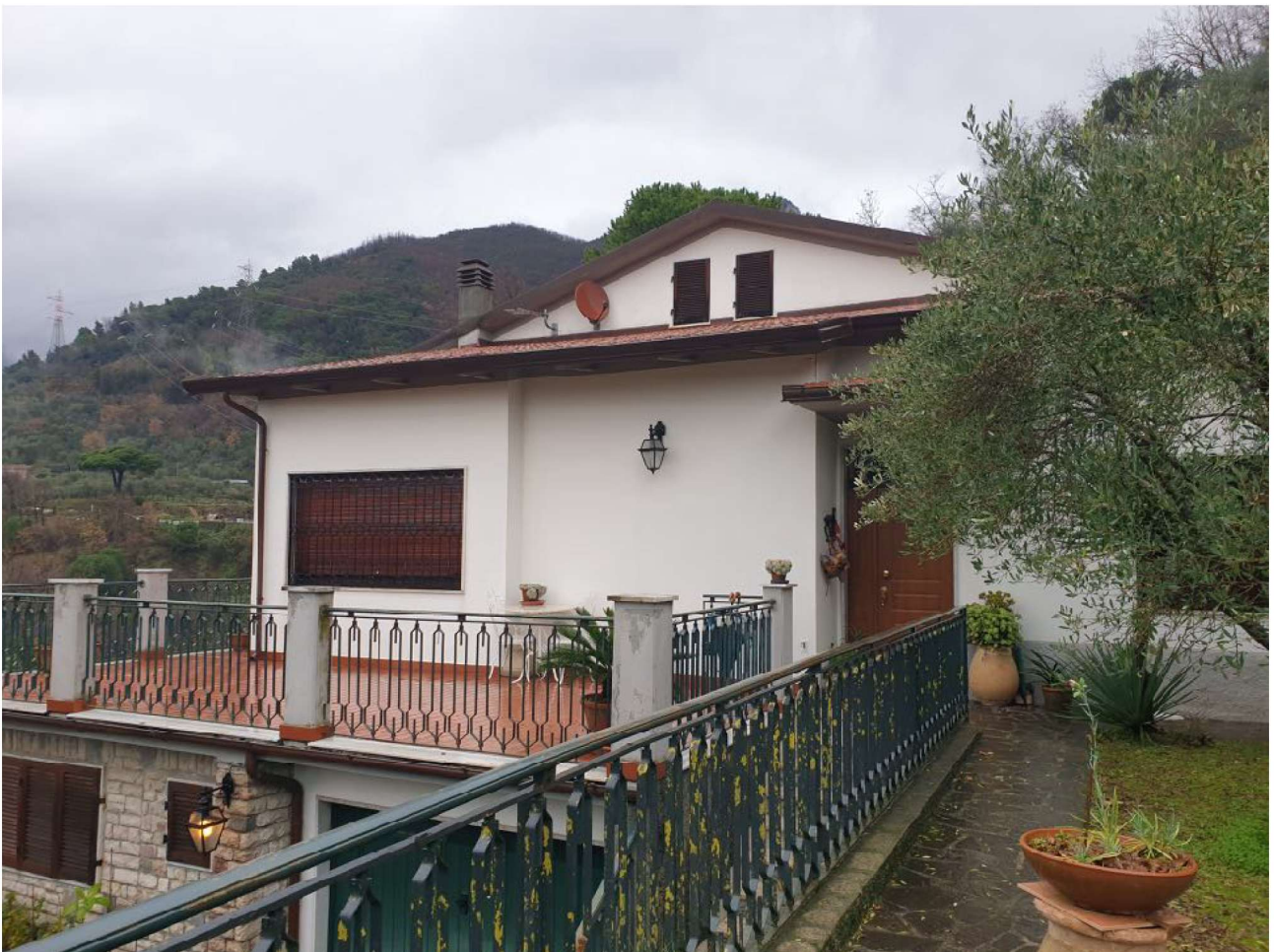
FOTO 61. Prospetto a sud-ovest (piano primo)
