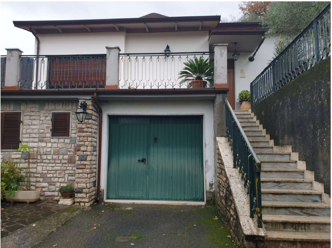
FOTO 53 e 54. Prospetto sud-ovest
