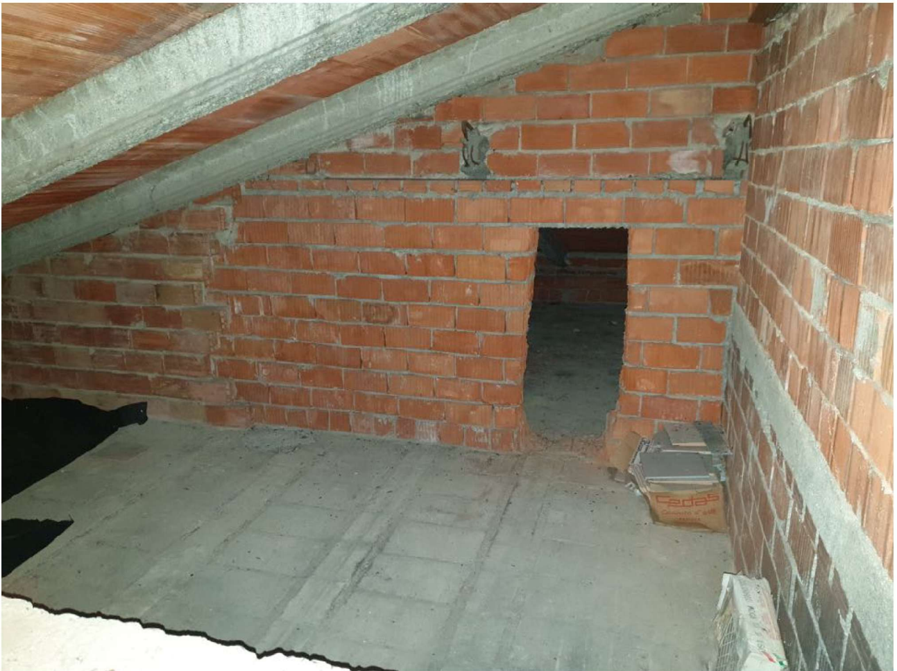
FOTO 53. Sottotetto posto in corrispondenza della cucina e della zona pranzo
