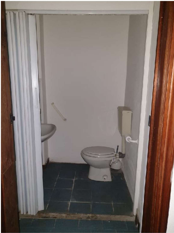
FOTO 89. Bagno dello studio sanitario via Don G. Minzoni
