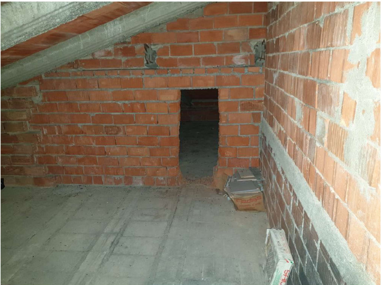
FOTO 52. Sottotetto posto in corrispondenza della cucina e della zona pranzo
