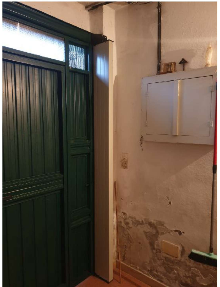
FOTO 42. Particolare ingresso a Garage
