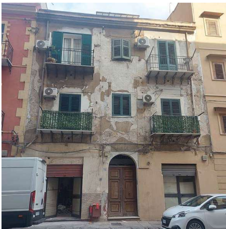
FOTO 1 – Prospetto via Archimede n. 77 – Palermo
