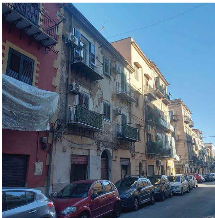
FOTO 2 – Prospetto via Archimede n. 77 - Palermo
