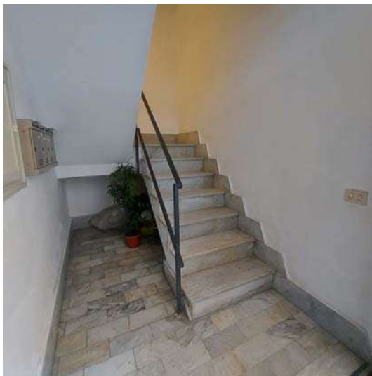
FOTO 3 – scala di accesso condominiale
