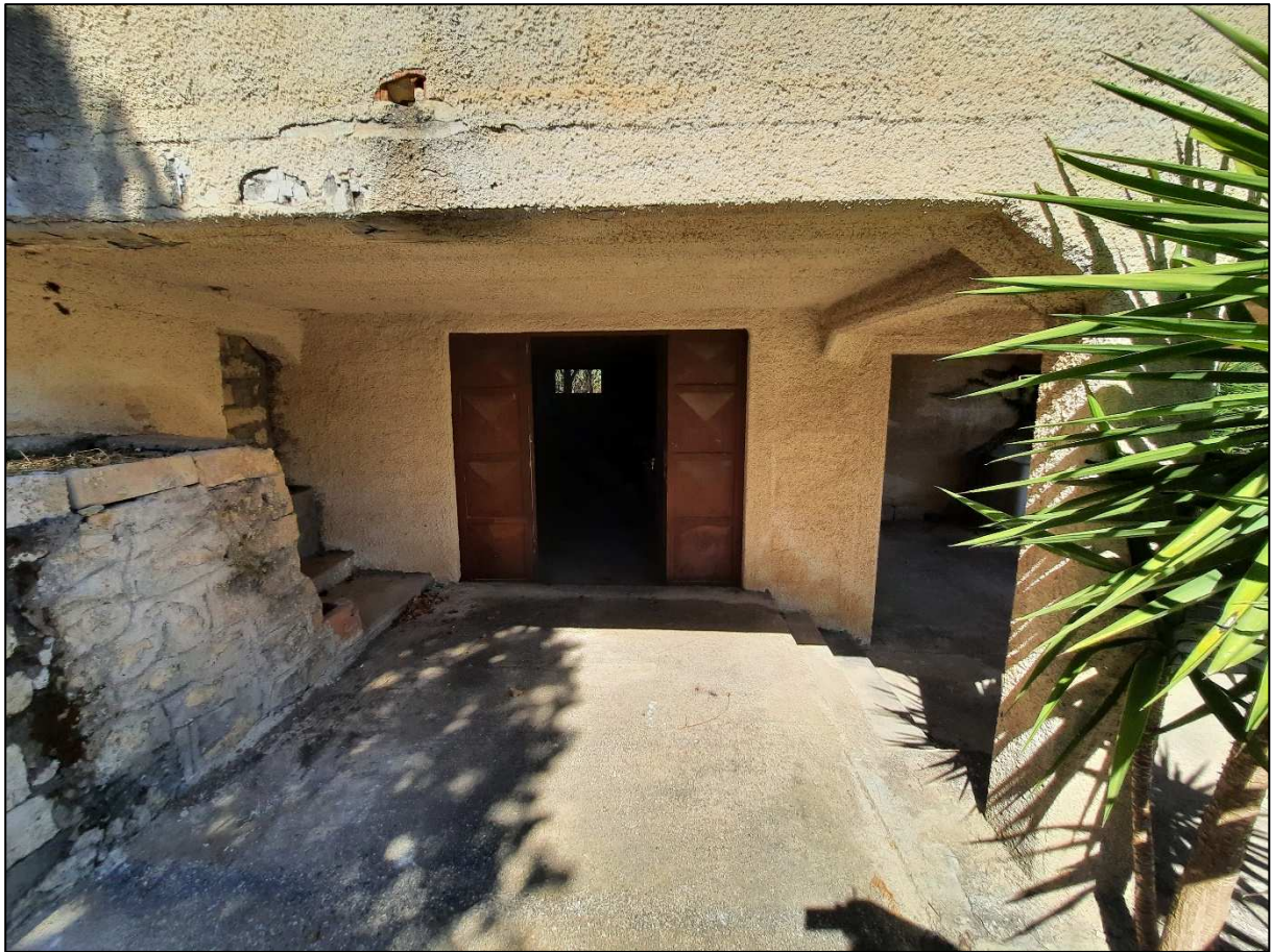
Accesso Box p.lla 362 sub 2
