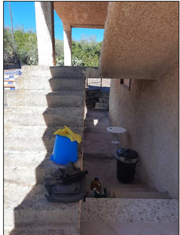
Scale accesso 1 piano p.lla 362 sub 3 11
