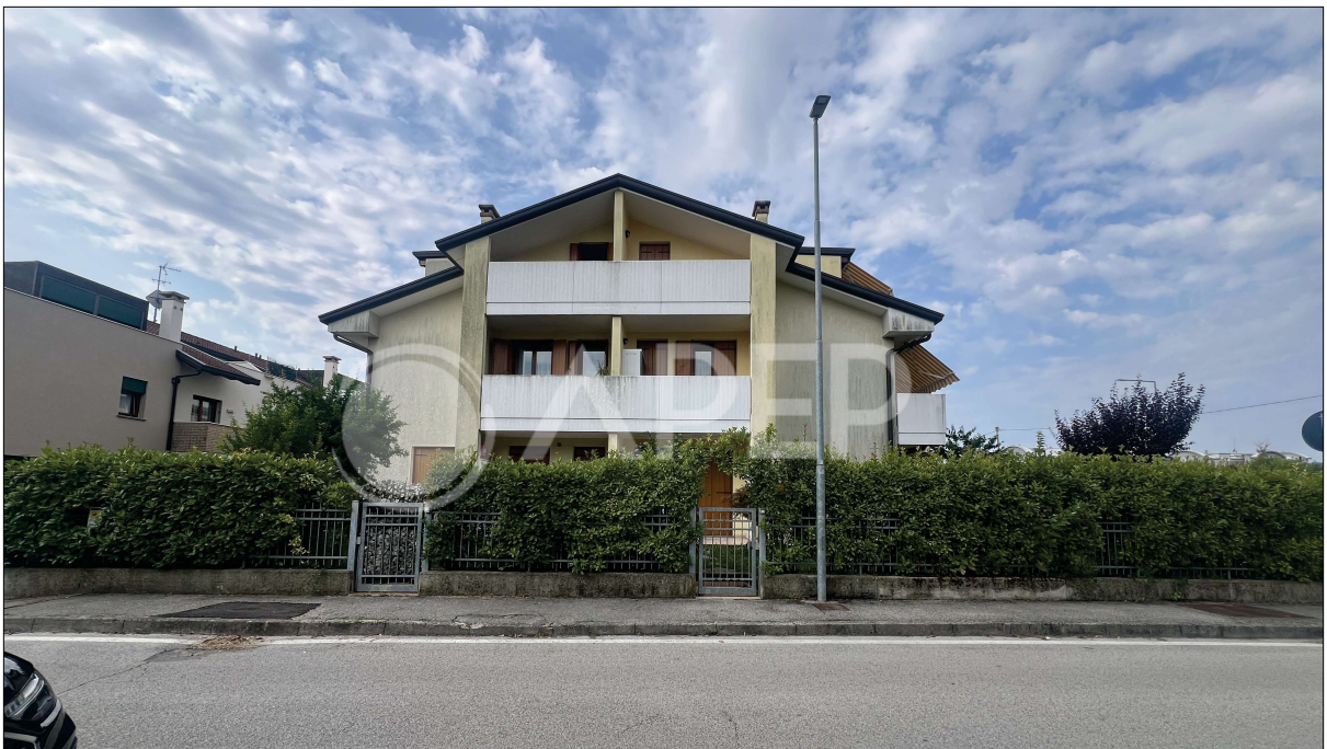
Vista del fabbricato da Nord-Est, via Tazzoli
