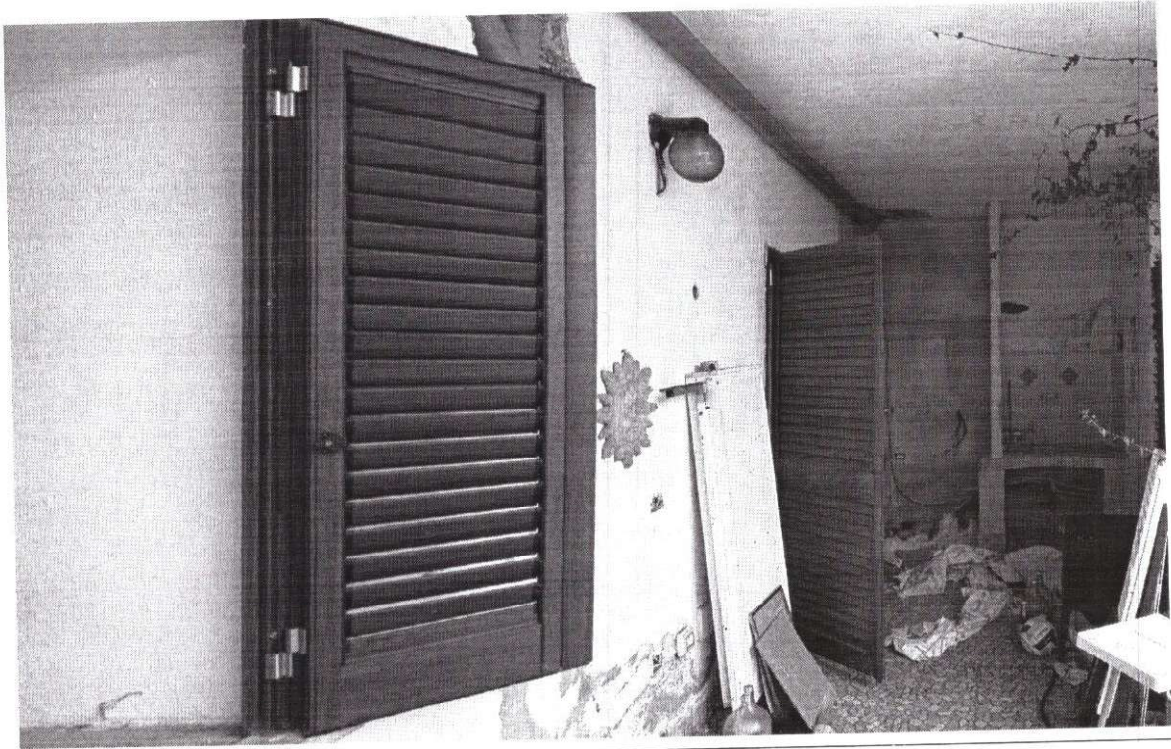
— Foto 13, piano terra – vista esterna veranda sul retro
