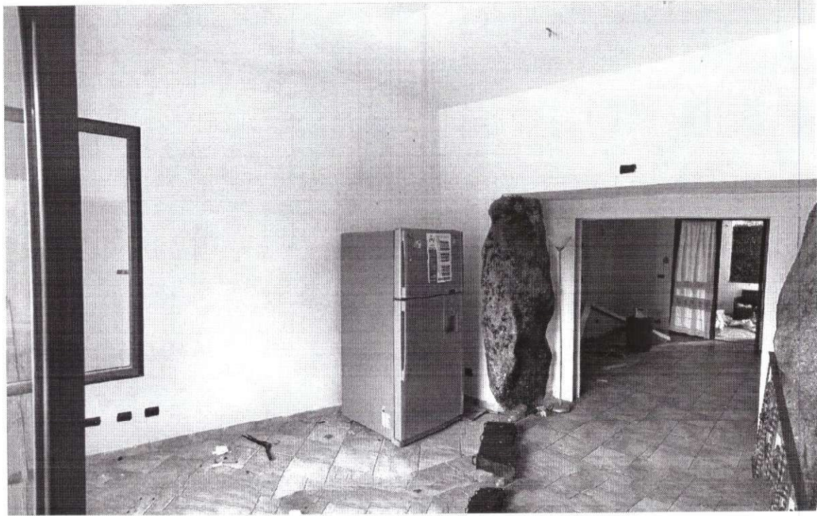
→ Foto 7, piano terra – vista interna vano pranzo/soggiorno
