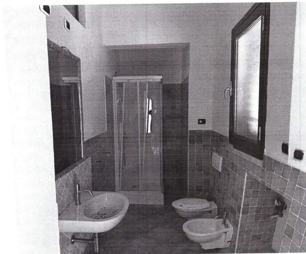
→ Foto 15, piano primo – vista bagno
