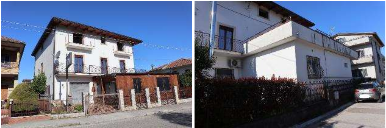
Viste esterne del fabbricato oggetto di trattazione
