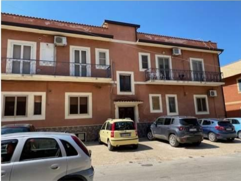
Foto 1: Vista esterna dell'immobile di Via Mazzini n°209 (Ex 137).
