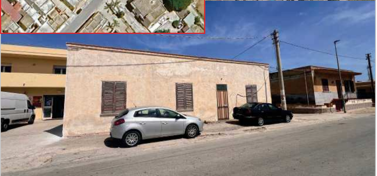
VISTA ESTERNA - PROSPETTO SULLA SP 24
