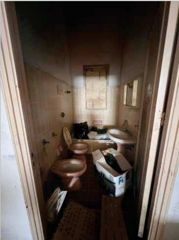
VISTE INTERNE - SERVIZIO IGIENICO E DISIMPEGNO
