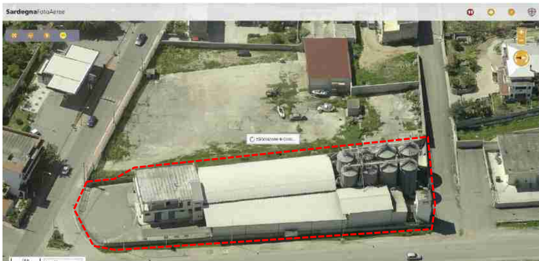
Figura 5_Immagine satellitare dalla Strada Provinciale Irgoli Capo Comino, antecedente installazione dell’impianto fotovoltaico
