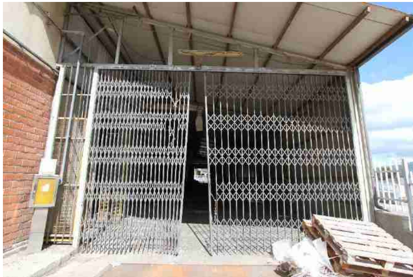
Figura 54_Accesso alla tettoia laterale zona carico scarico
