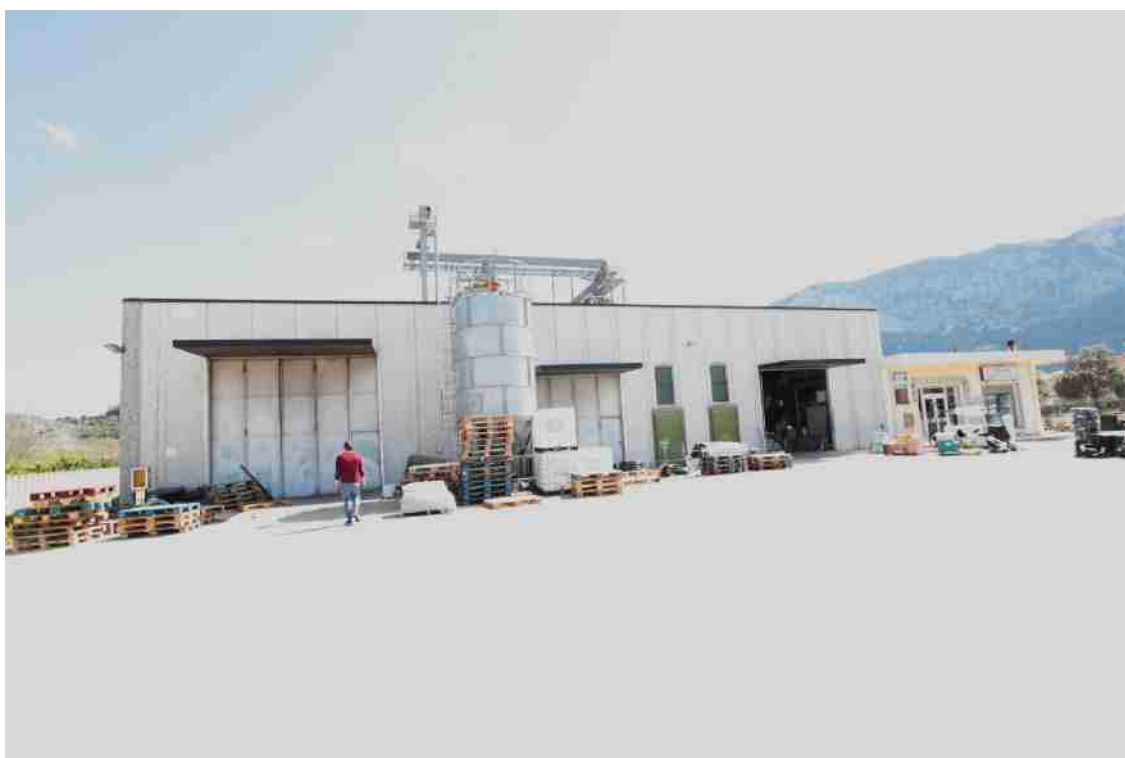
Figura 9_Ingresso dell'opificio e del magazzino vista dall'area indicata con il sub.4 di proprietà esclusiva del sig. "Omissis"
