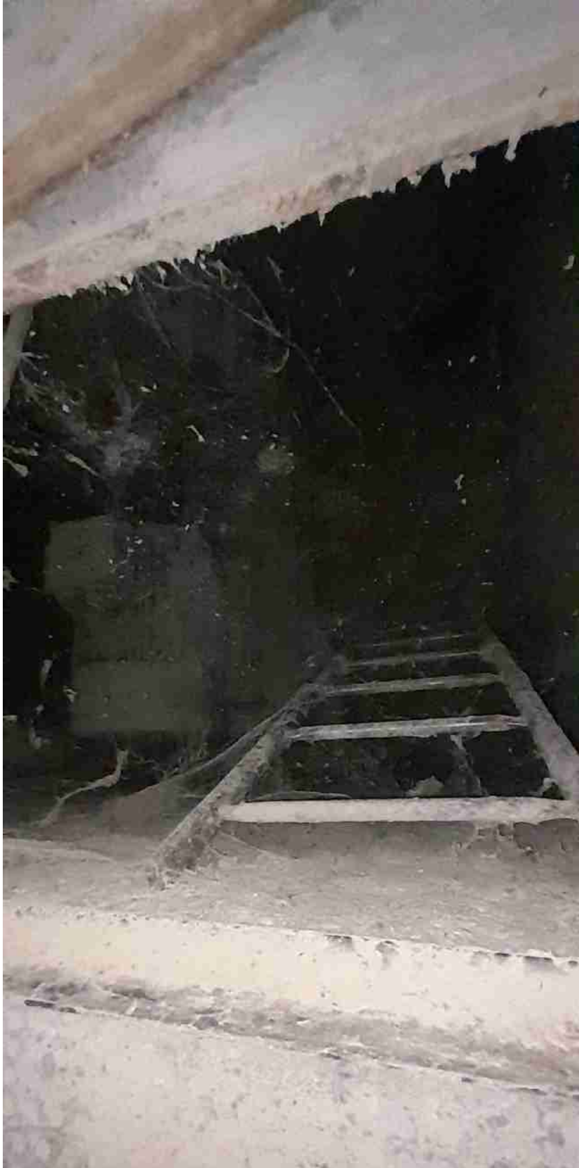
Figura 110_Ingresso fossa interrata con il Mulino a Martelli
