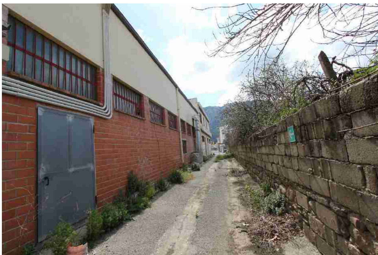
Figura 82_Area scoperta laterale ai locali produttivi e deposito
