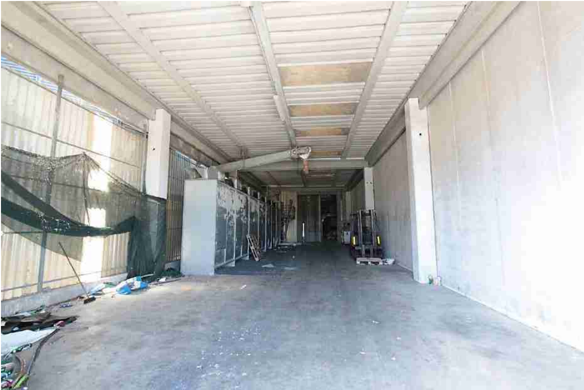
Figura 40_Area scarico cereali
