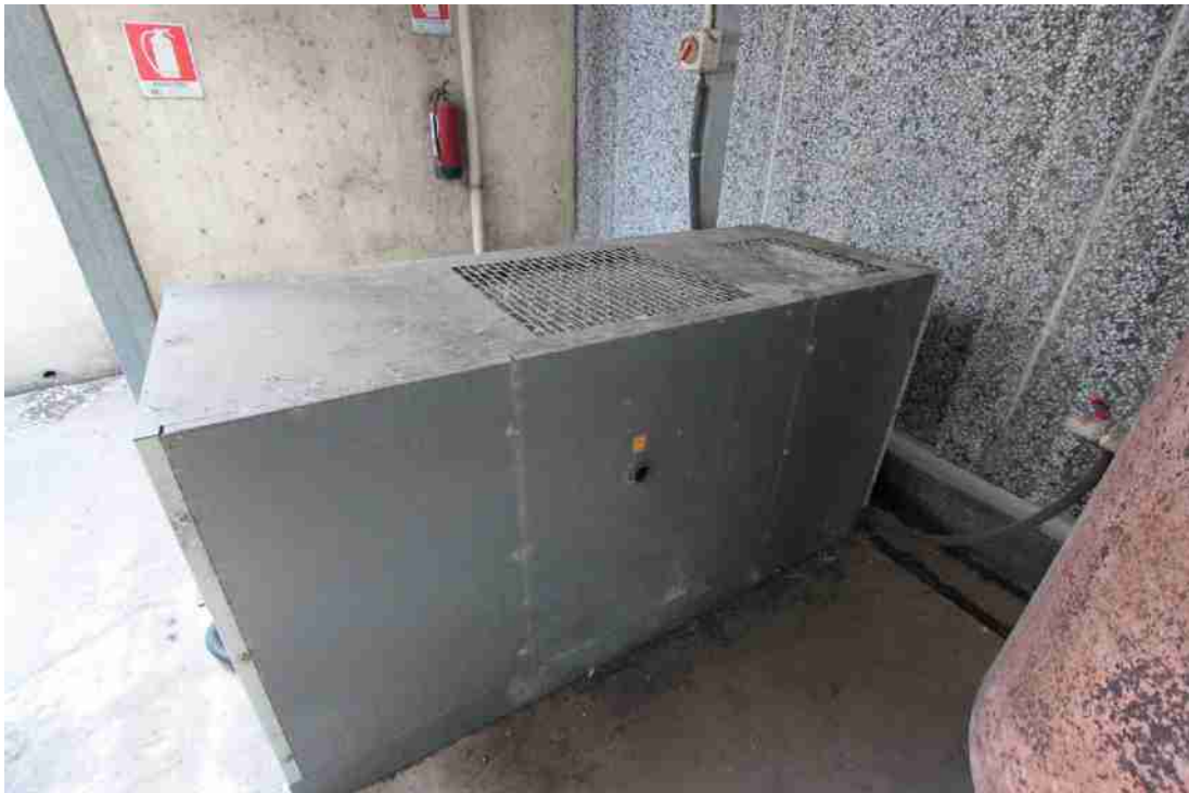
Figura 53_Compressore Atlas Ga18ff
