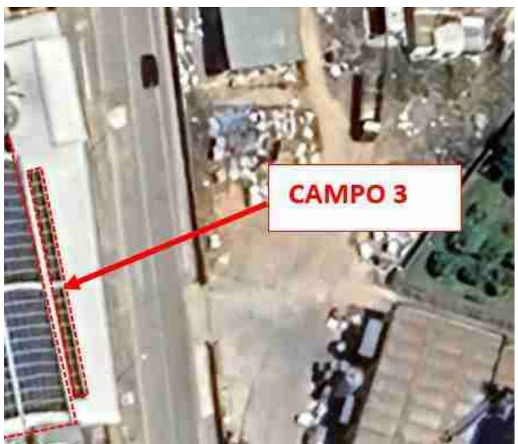
Figura 11_Estratto satellitare d'inquadramento del campo fotovoltaico n.3
