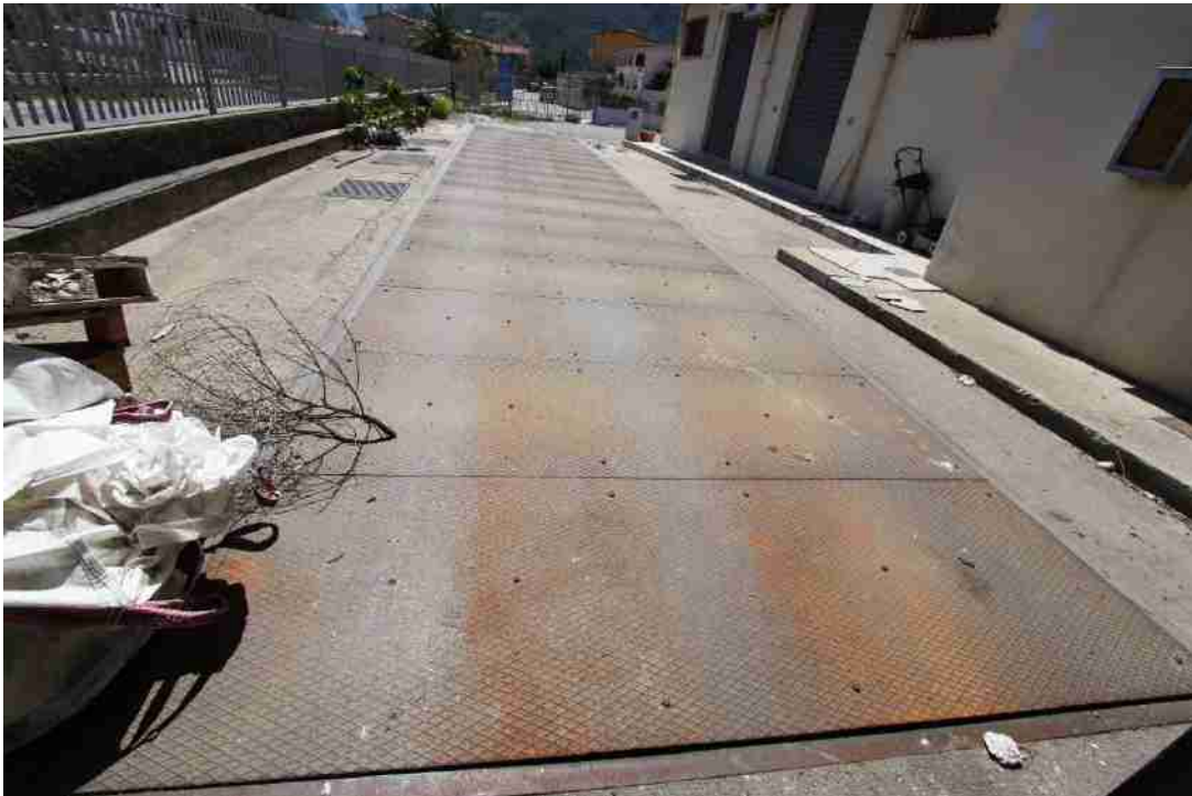
Figura 36_Pesa per camion nel piazzale laterale
