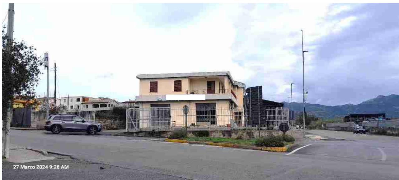
Figura 8_Ingresso all'area produttiva dalla Via Carmine Soro
