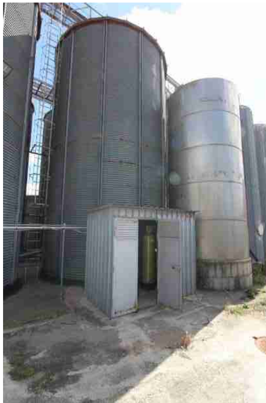
Figura 70_Area Silos e addolcitore per le acque di produzione
