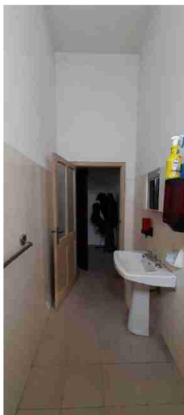
Figura 16_Bagno uffici piano terra
