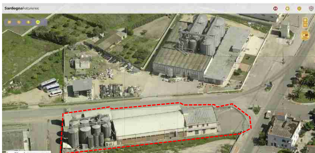
Figura 7_Immagine satellitare dalle proprietà confinanti, antecedente installazione dell’impianto fotovoltaico
