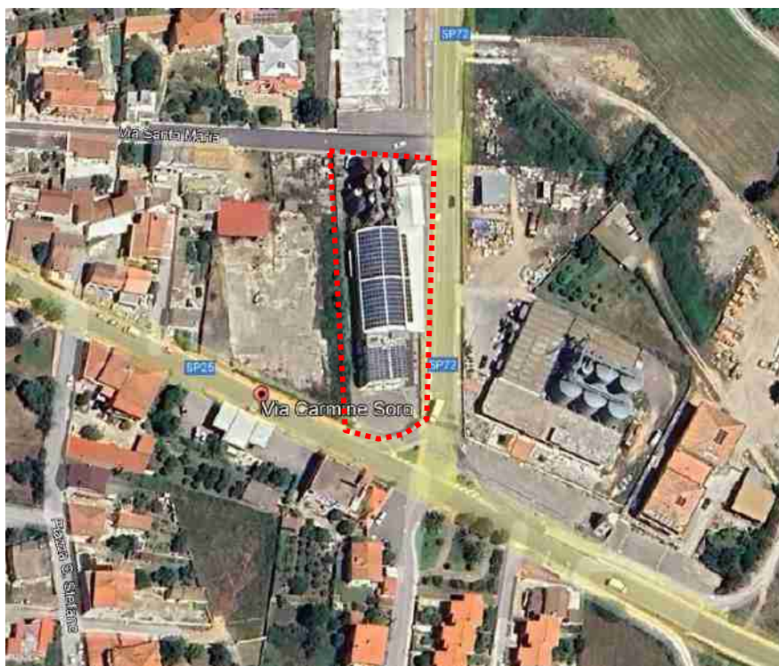
Figura 2_Vista satellitare del complesso produttivo n.1_perimetro in rosso
