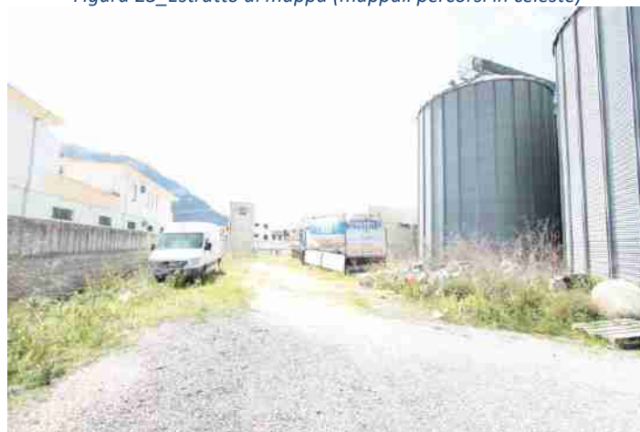
Figura 24_Vista delle aree non intestate alla società in liquidazione, ma da questa occupate nel tempo.
