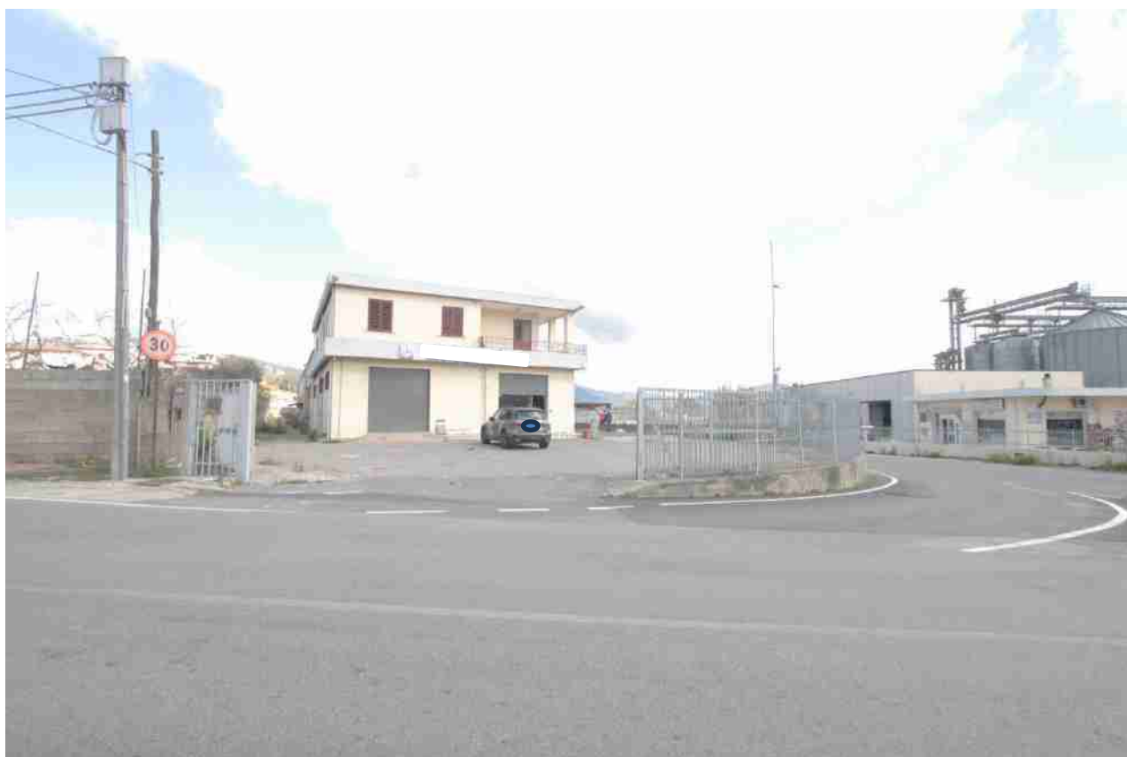
Figura 9_Ingresso all'area produttiva dalla Via Carmine Soro
