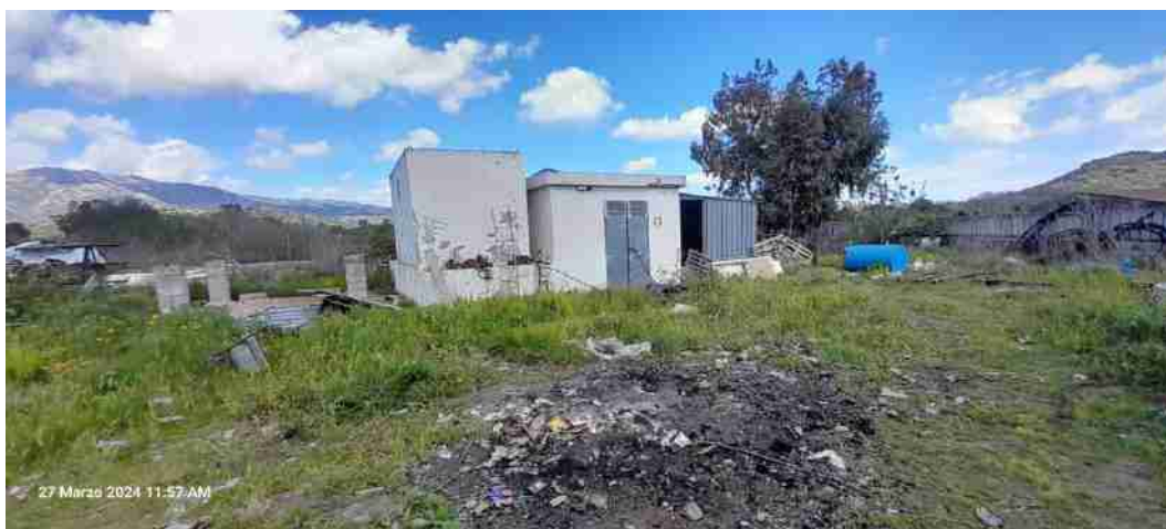
Figura 13_Locale pompe e cisterne antincendio sub.1
