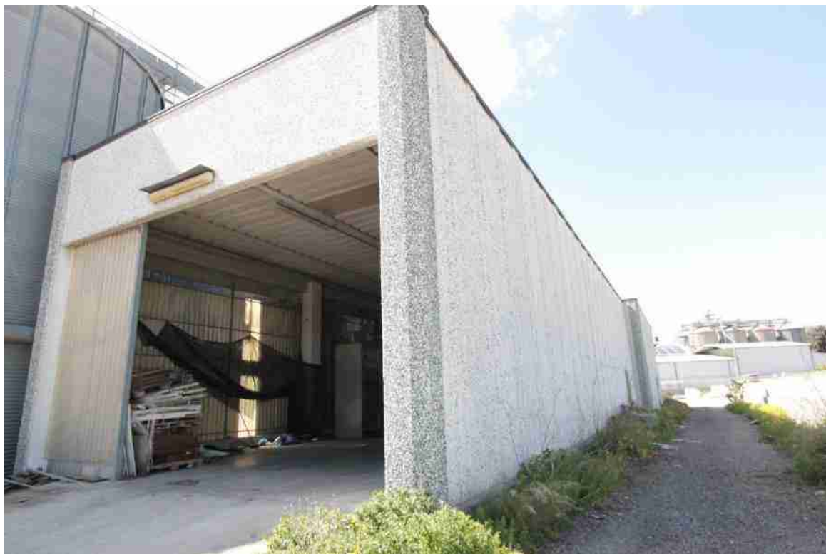
Figura 66_Esterno dell'opificio e area laterale di pertinenza
