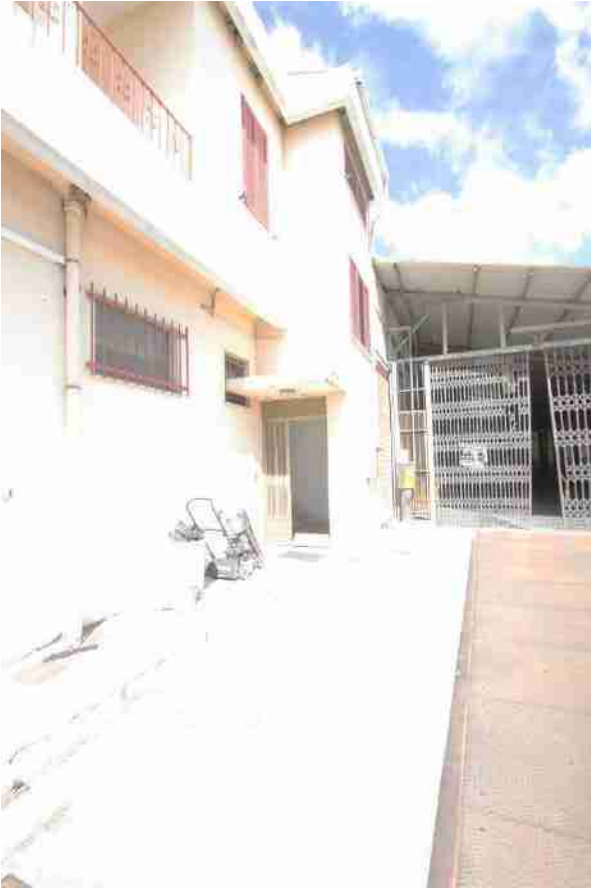
Figura 37_Ing. corpo scala di accesso alla casa del custode
