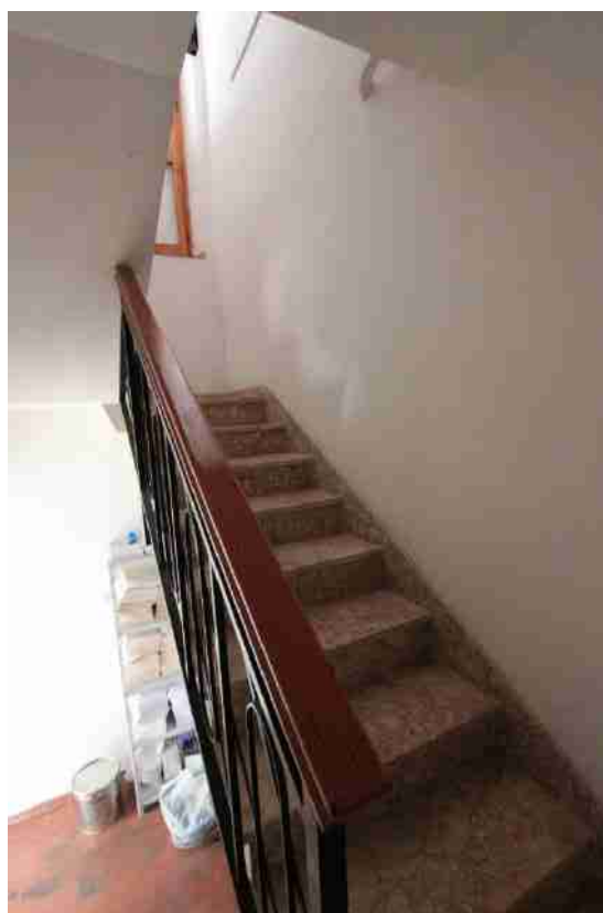
Figura 18_Corpo scala per l'accesso agli uffici del 1 Piano
