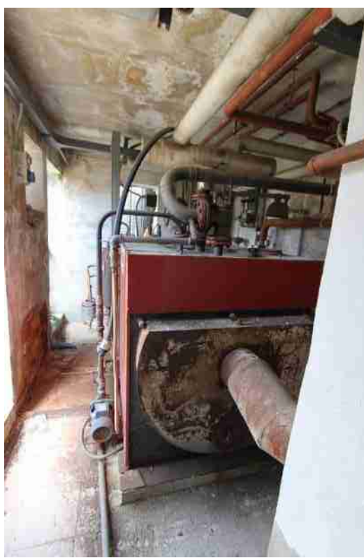
Figura 76_Caldaia Biasi
