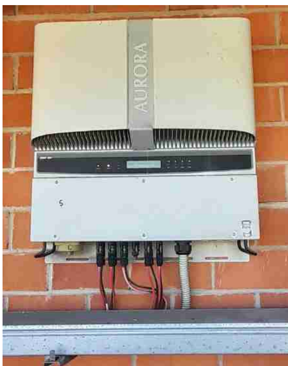
Figura 18_Dettaglio di un inverter Power-One
