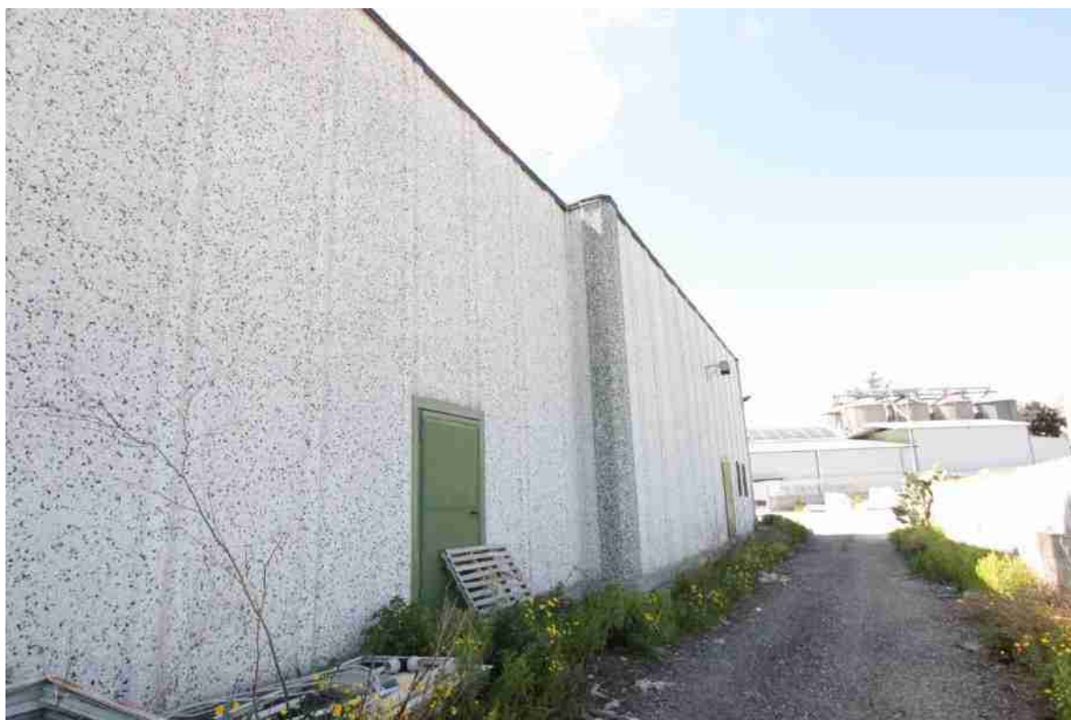
Figura 67_Esterno dell'opificio e area laterale di pertinenza
