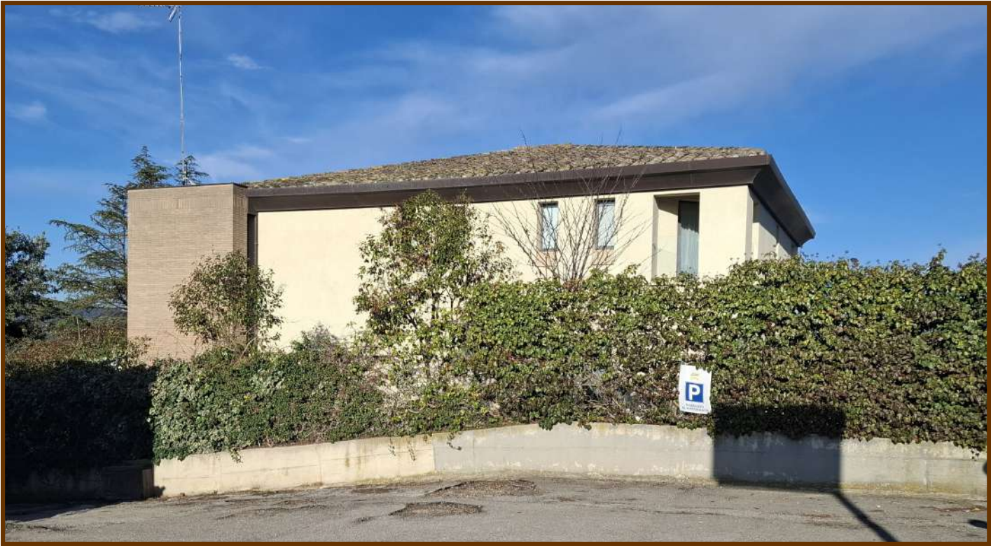
VISTA PROSPETTO SUD
