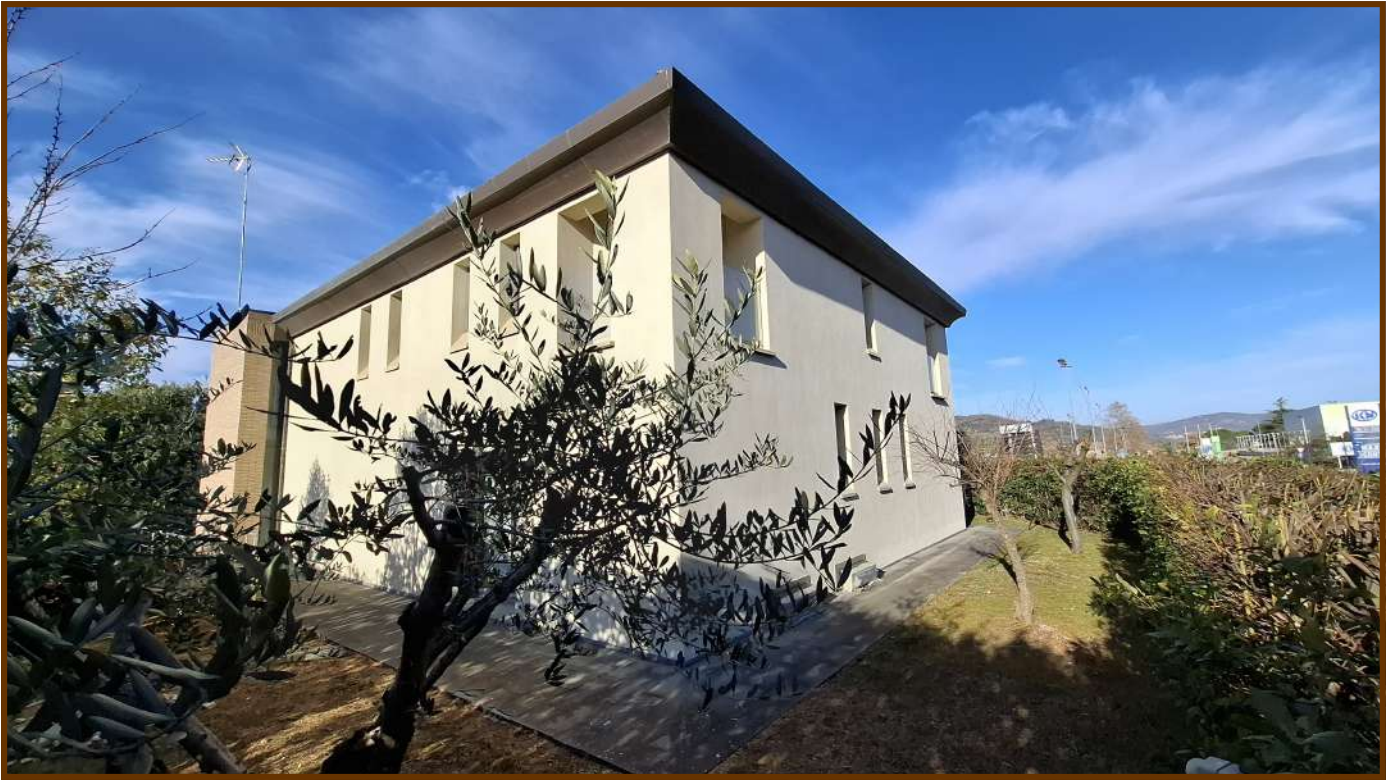
VISTA PROSPETTO SUD-EST
