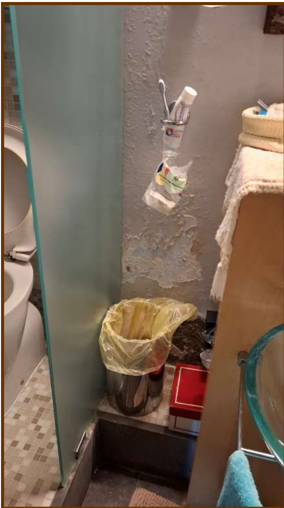
BAGNO P. SOTTOSTRADA
