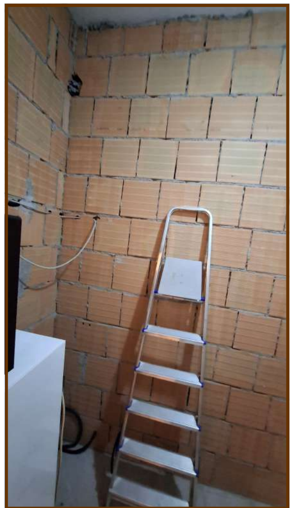
RIPOSTIGLIO PIANO TERRA
