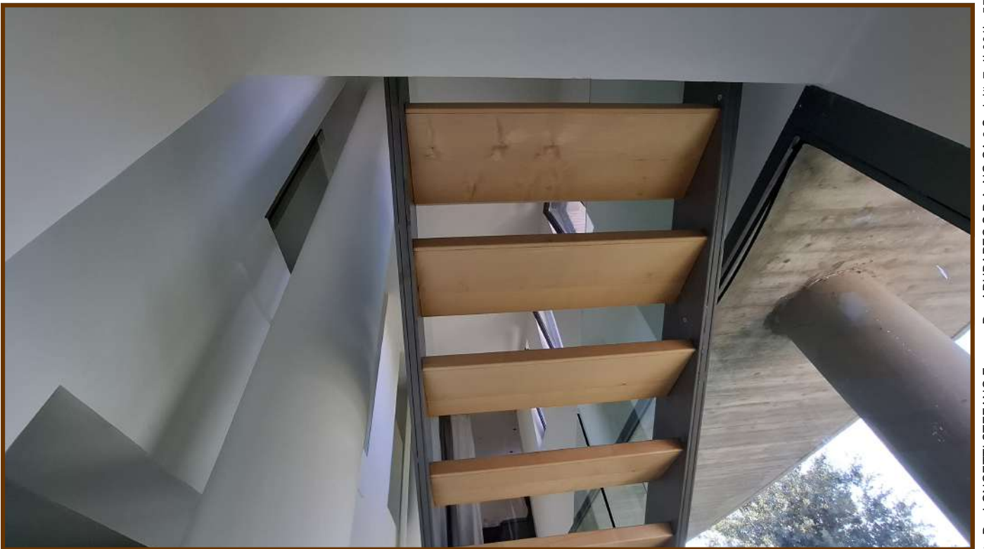
VISTA PARTICOLARE DELLA SCALA CHE SALE AL PIANO PRIMO
