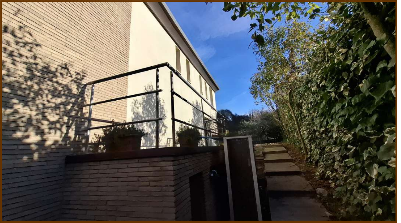
VISTA PROSPETTO SUD
