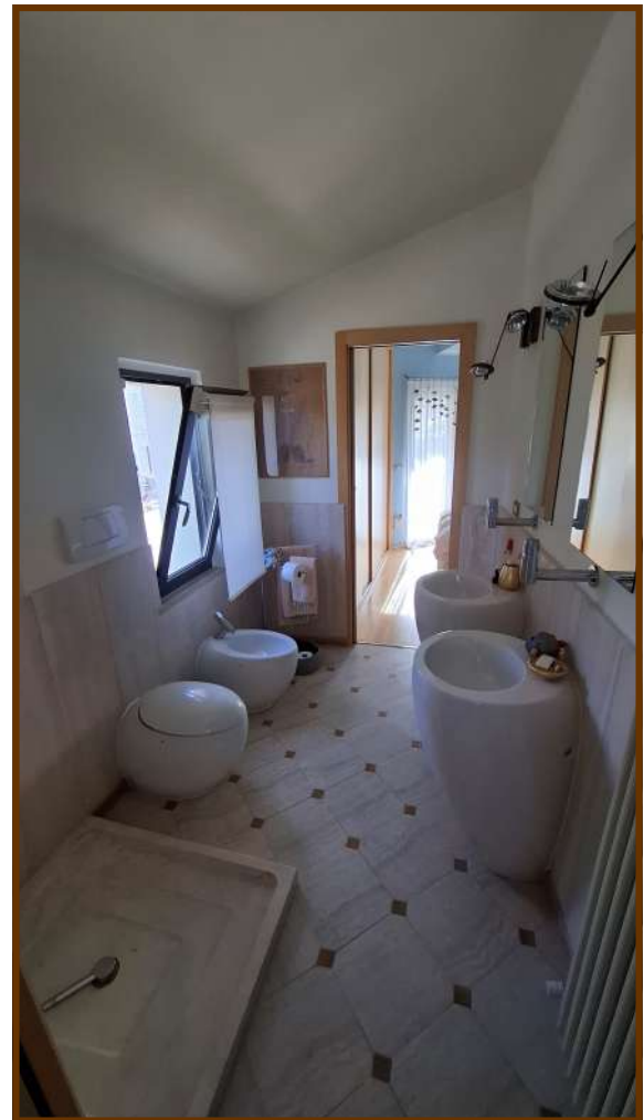
BAGNO PIANO PRIMO
