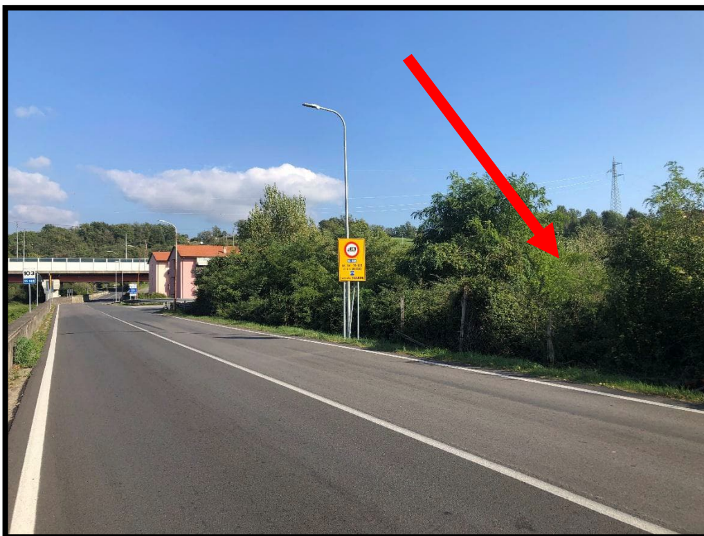
Foto 13 – Strada Statale per il Lagastrello
