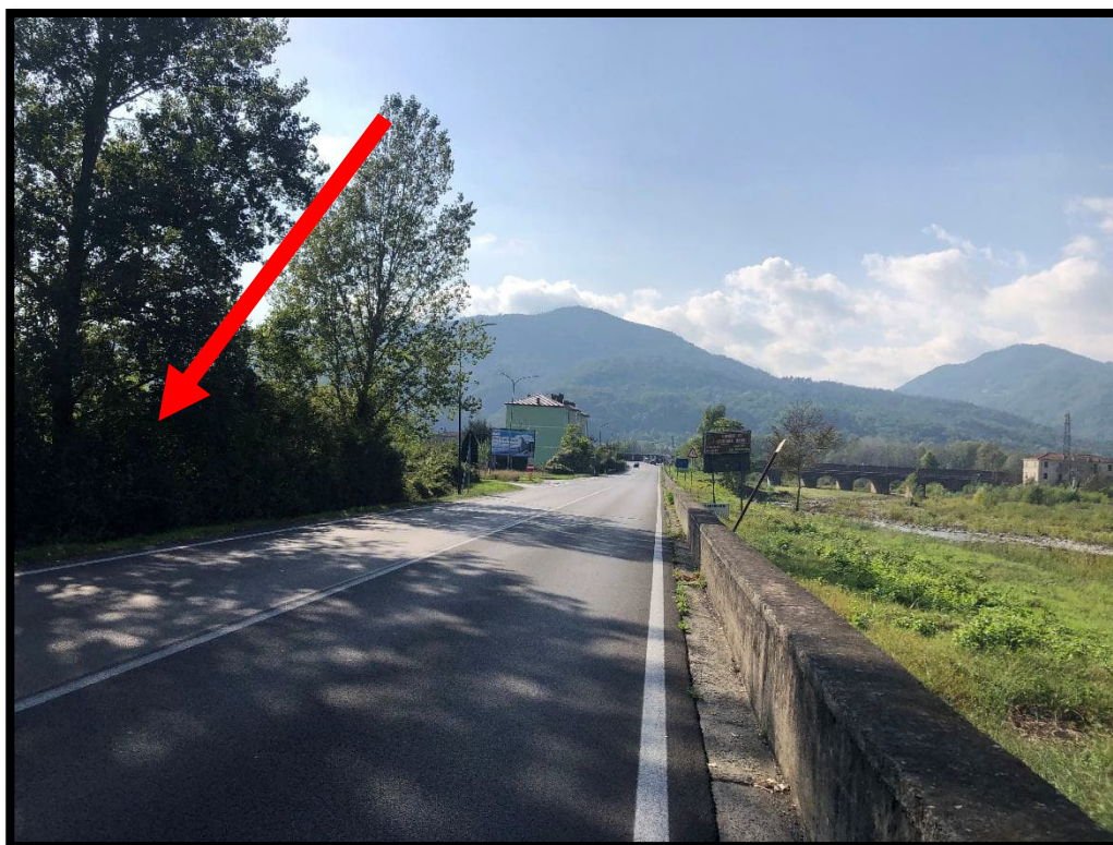
Foto 12 – Strada Statale per il Lagastrello
