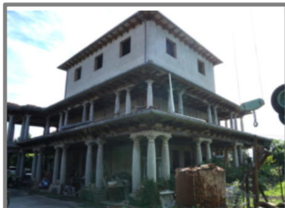
FOTO 3 – LATO NORD – OVEST
