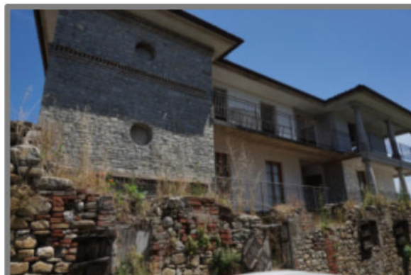
FOTO 5 – LATO SUD - OVEST
