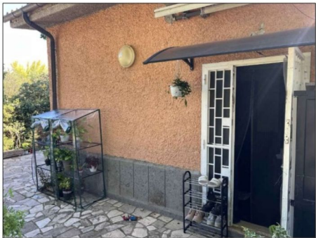
FOTO 5 - ingresso abitazione interno 1
