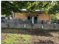
FOTO 4 - Abitazione bifamiliare int. 1 (sub 501) e int. 2 (sub 502)
