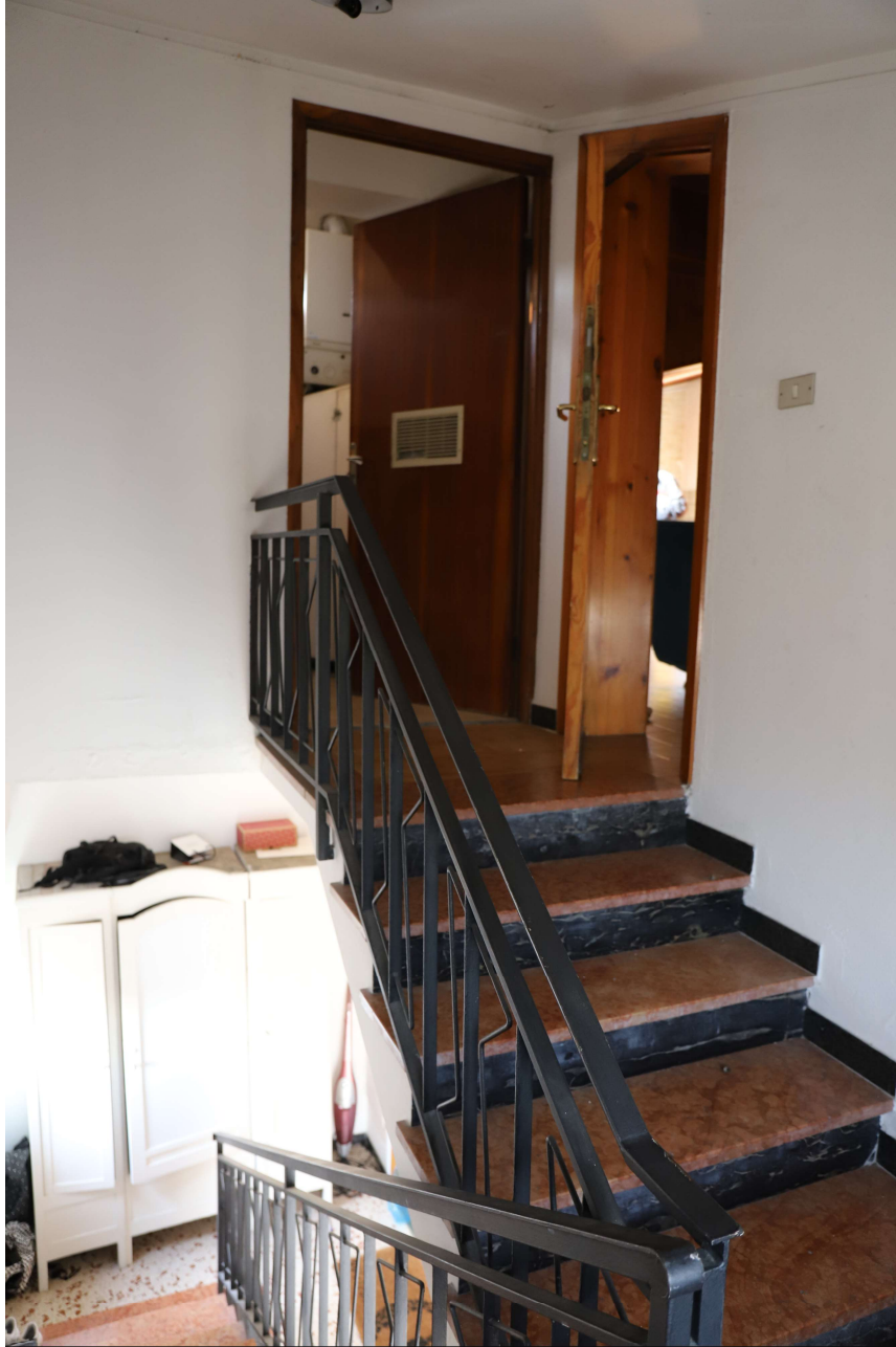
FOTO 18 – VISTA INTERNA VANO SCALA CON ACCESSO AL P. 3° E AL RIP.
