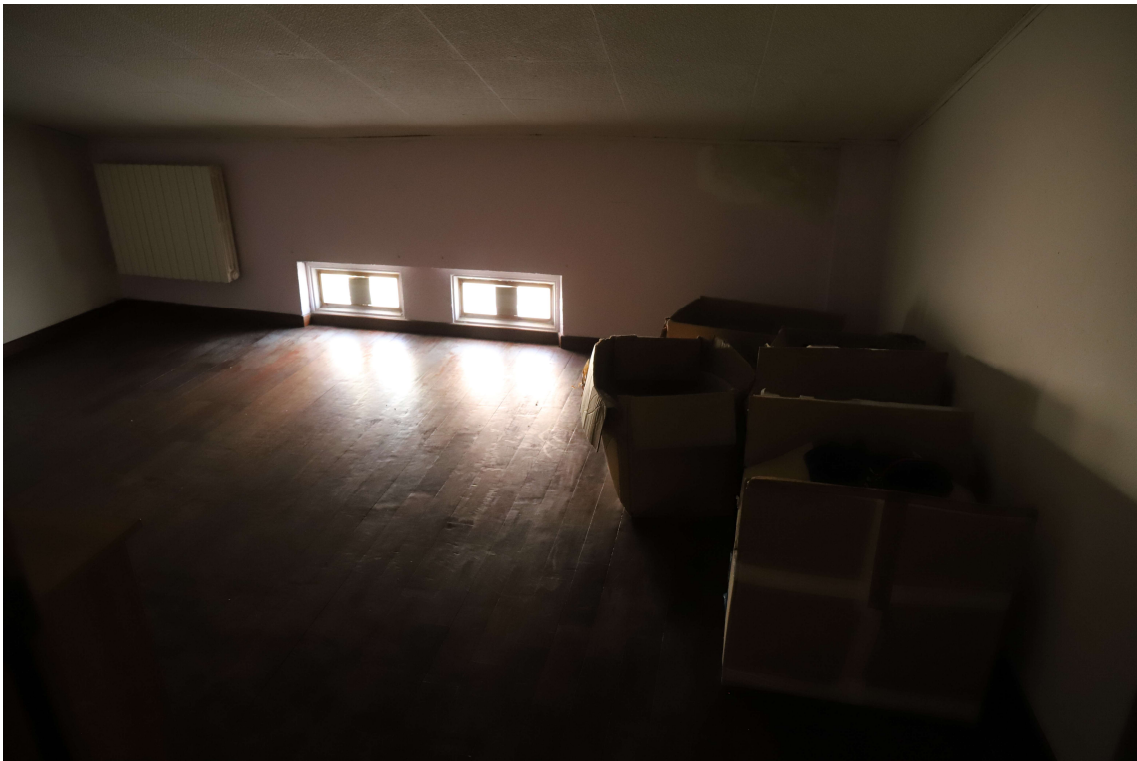
FOTO 16 – VISTA INTERNA P. 3° ZONA SOFFITTA CON AFFACCIO LATO EST
