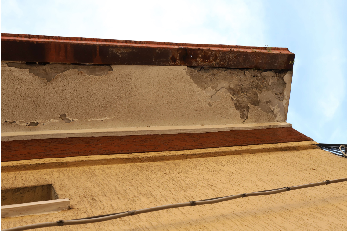
FOTO 11 – VISTA ESTERNA SU CORNICIONE EDIFICIO FRONTE STRADA
