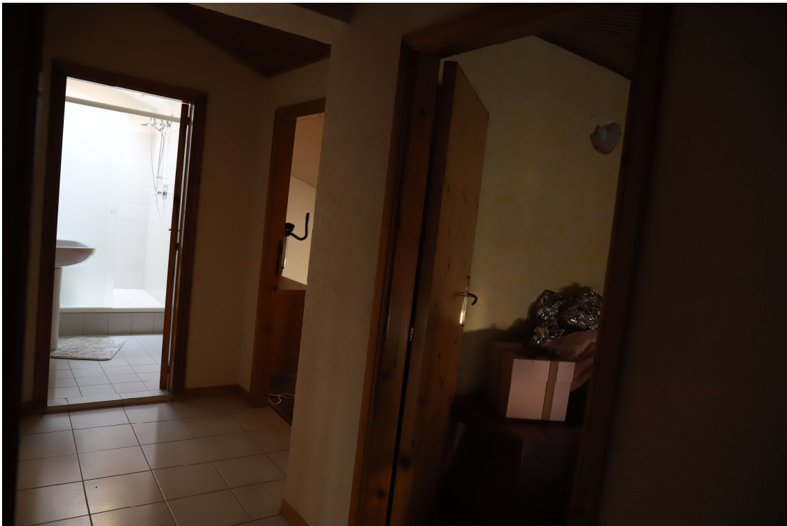
FOTO 14 – VISTA INTERNA P. 3° ZONA BAGNO E SOFFITTE
