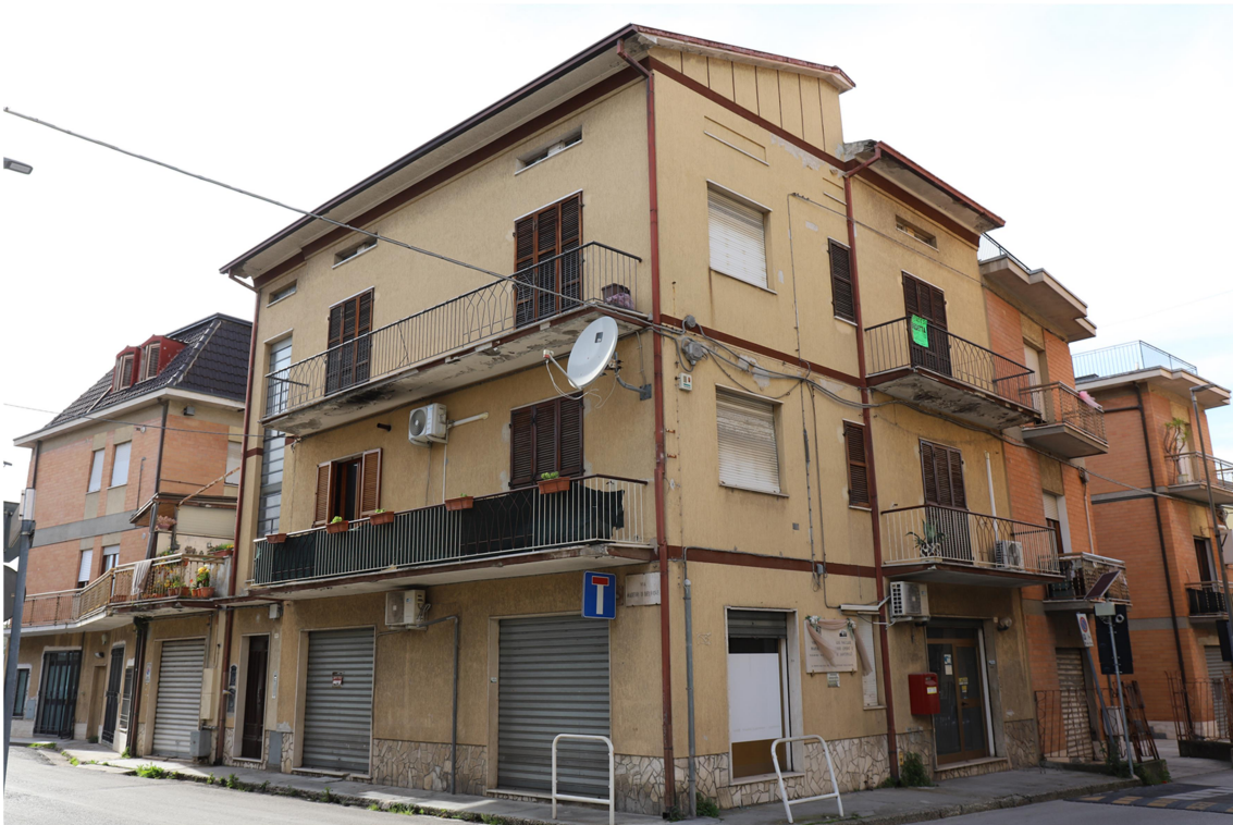
FOTO 2 – VISTA INTERO FABBRICATO DA SUD – ES
