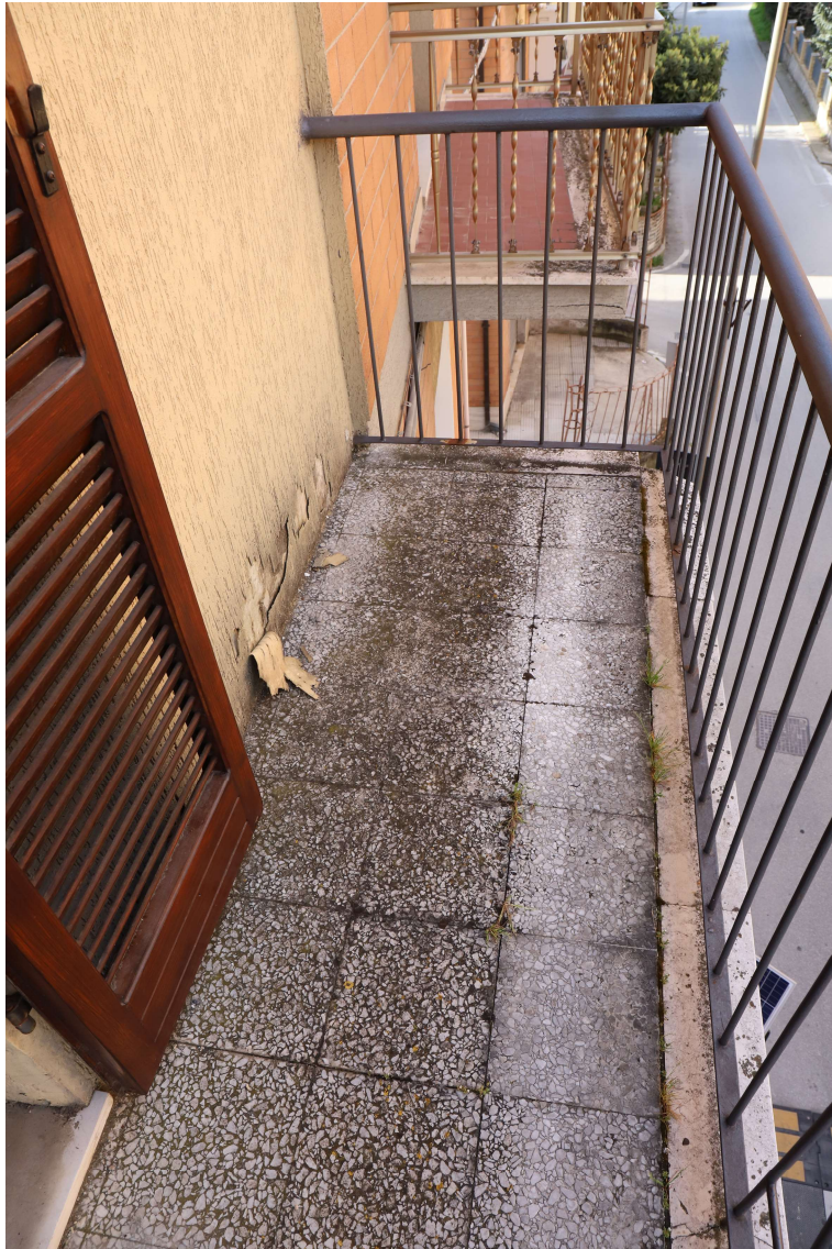
FOTO 10 – VISTA ESTERNA BALCONE AL P. 2° LATO EST
