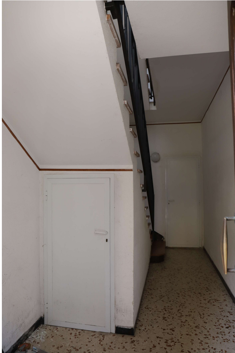
FOTO 3 – VISTA INTERNA INGRESSO FABBRICATO
