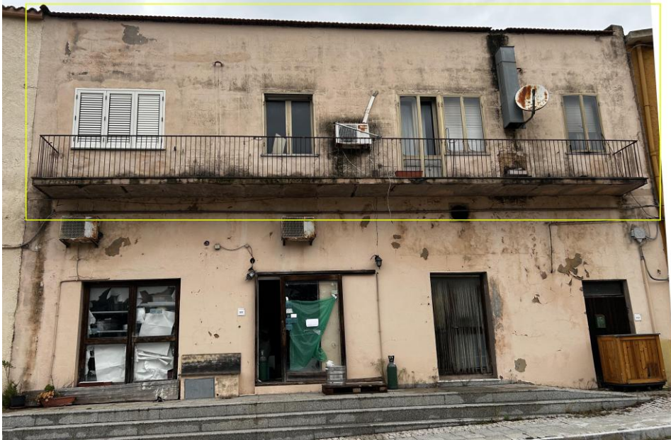
Facciata principale del fabbricato (nel riquadro giallo indicato il Sub 3)
