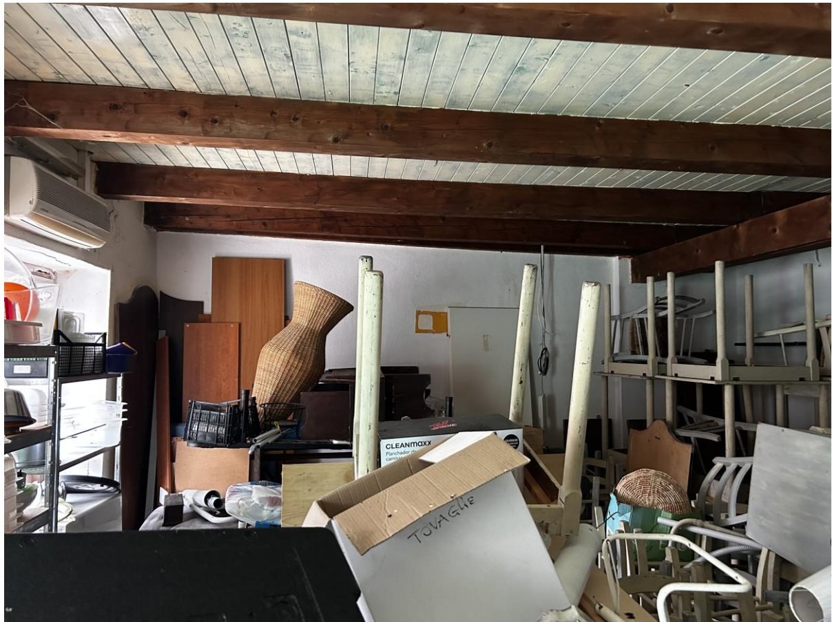
Particolare delle travi in legno e del tavolato
