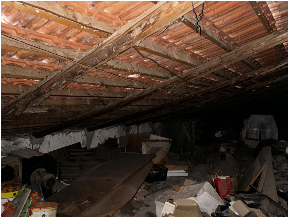
Vista del locale soffitta
