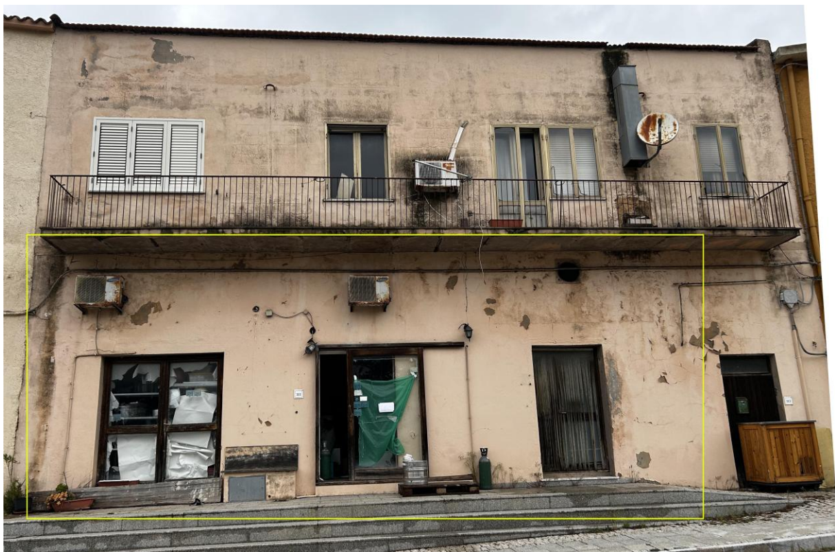
Facciata principale del fabbricato (nel riquadro giallo indicato il Sub 2)
