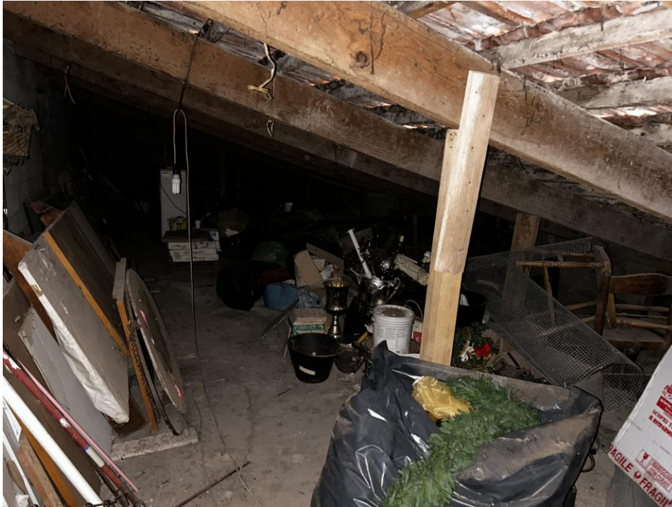
Vista del locale soffitta
