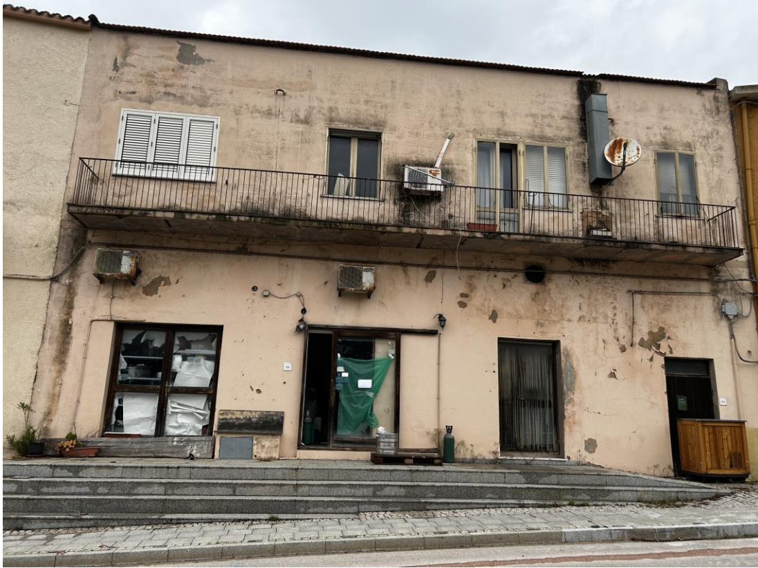
Foto della facciata esterna dell'immobile
