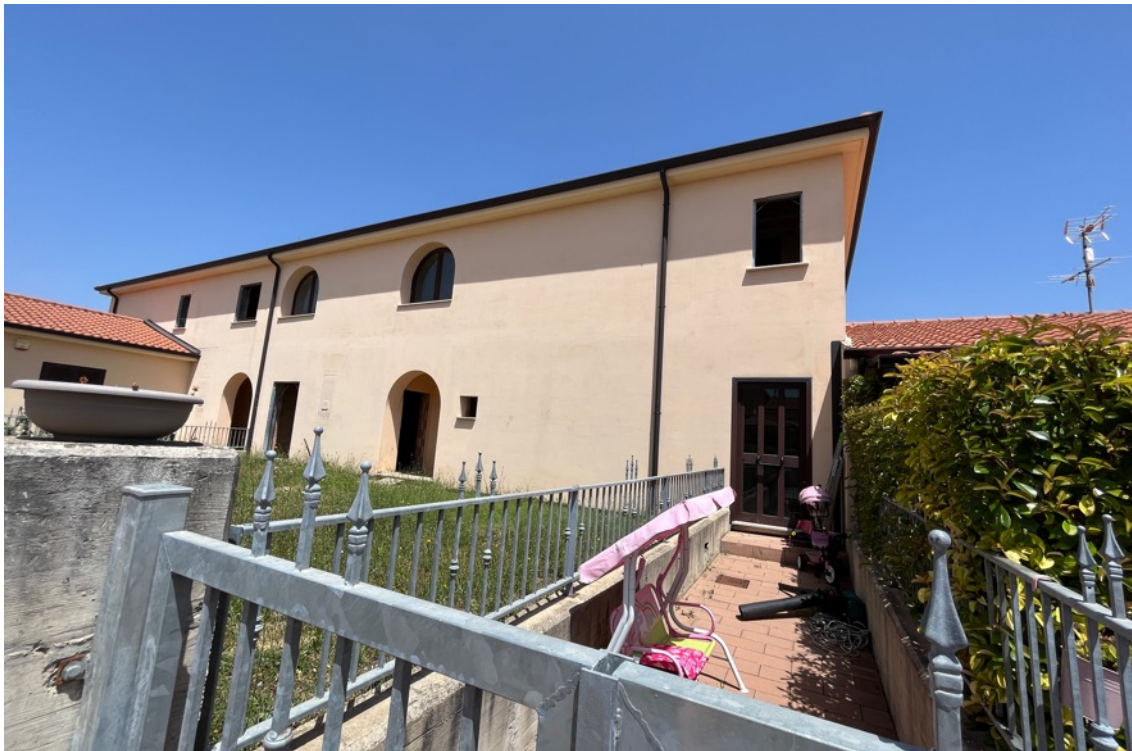
Fig.2 – Vista da sud degli accessi e dell’intero immobile
