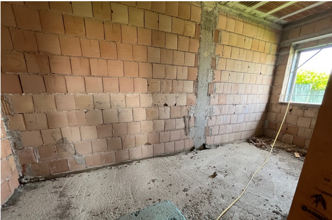
Fig.-17 – Vista di un vano interno a rustico
