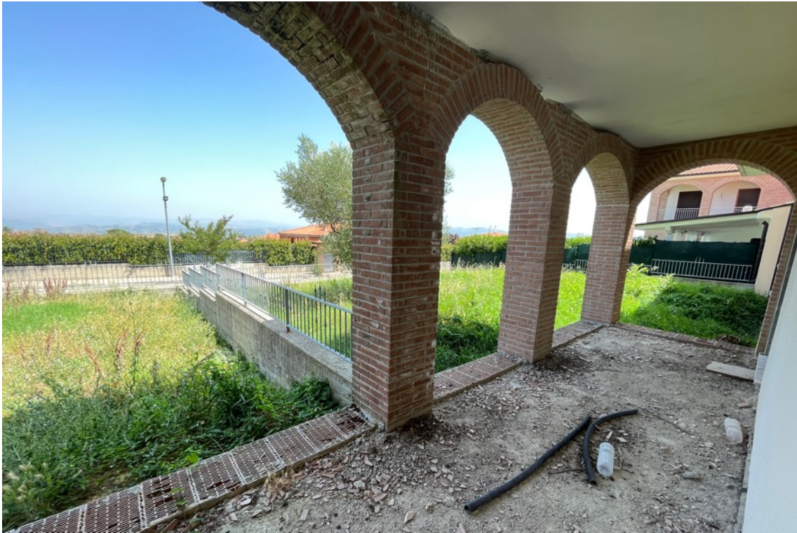
Fig.12 – Vista dei giardini pertinenziali dal porticato (da est verso ovest)
