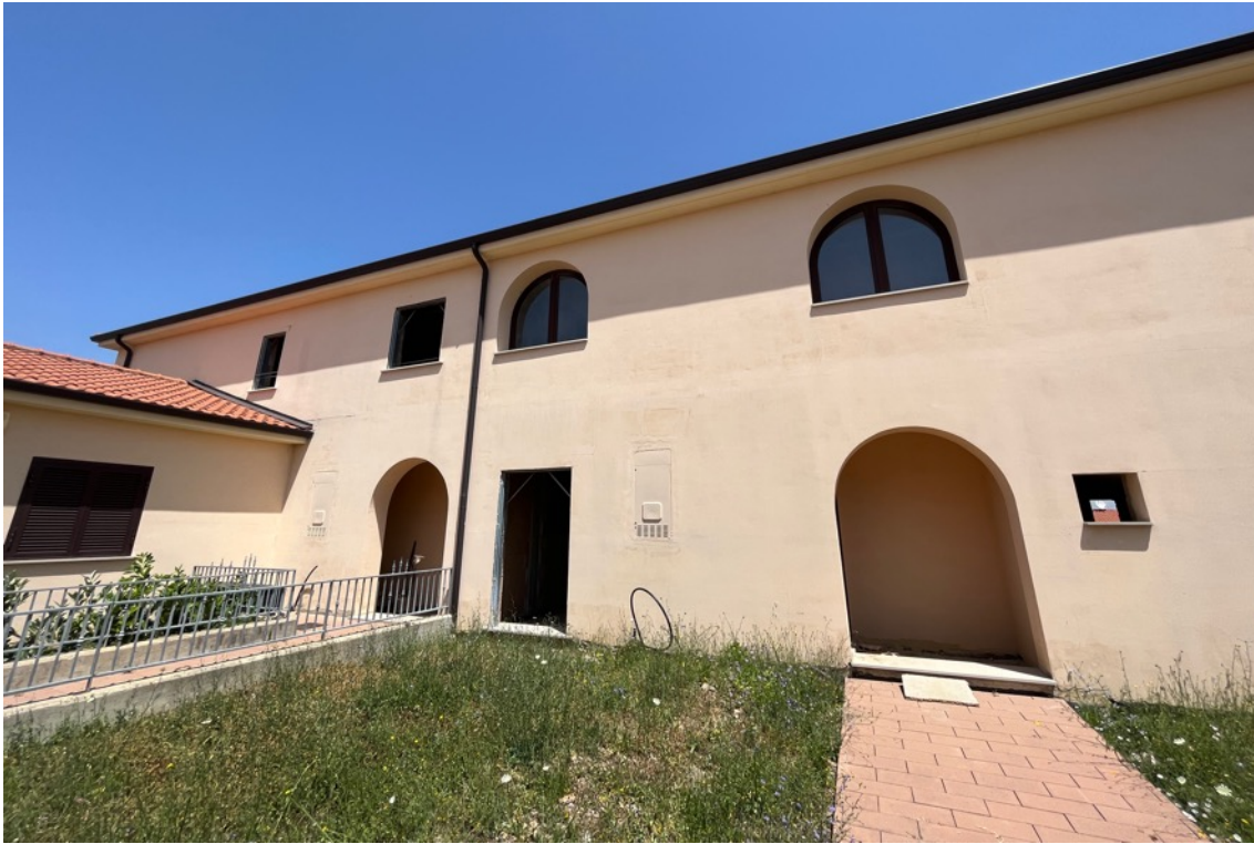
Fig.8 – Vista della facciata (fronte sud)
