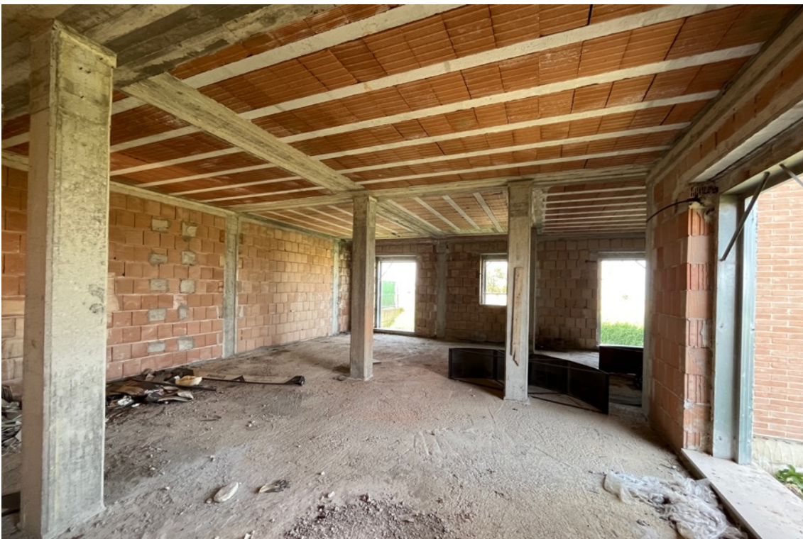
Fig.15 – Vista dei vani interni a rustico
