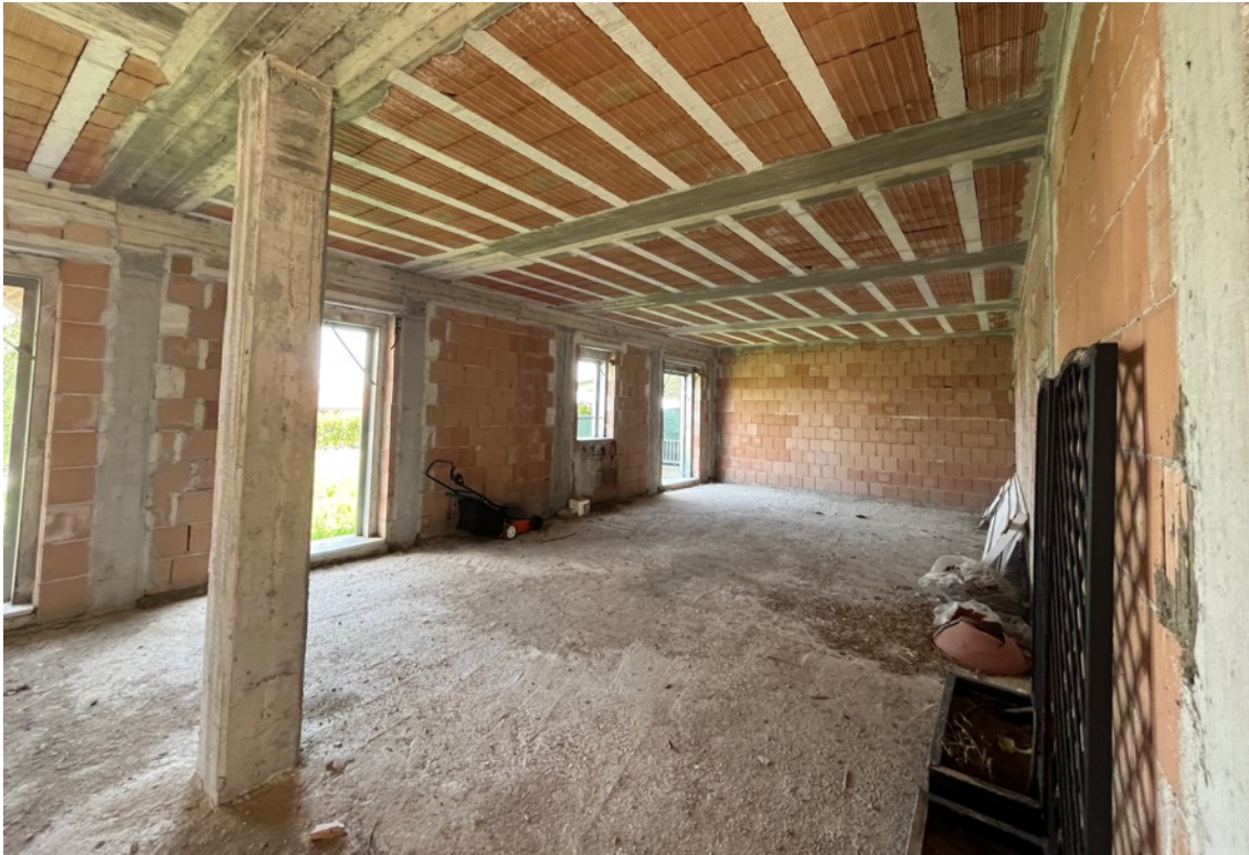
Fig.14 – Vista dei vani interni a rustico
