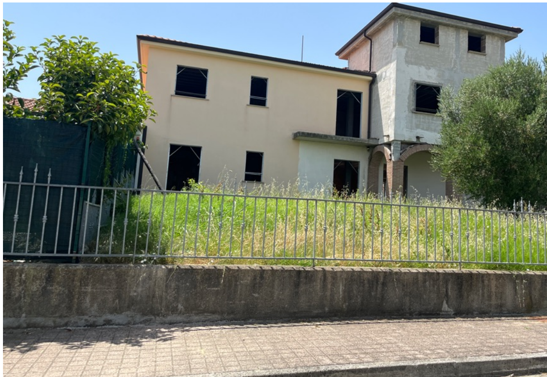
Fig.4 – Vista della facciata dell’immobile e del giardino (fronte nord)
