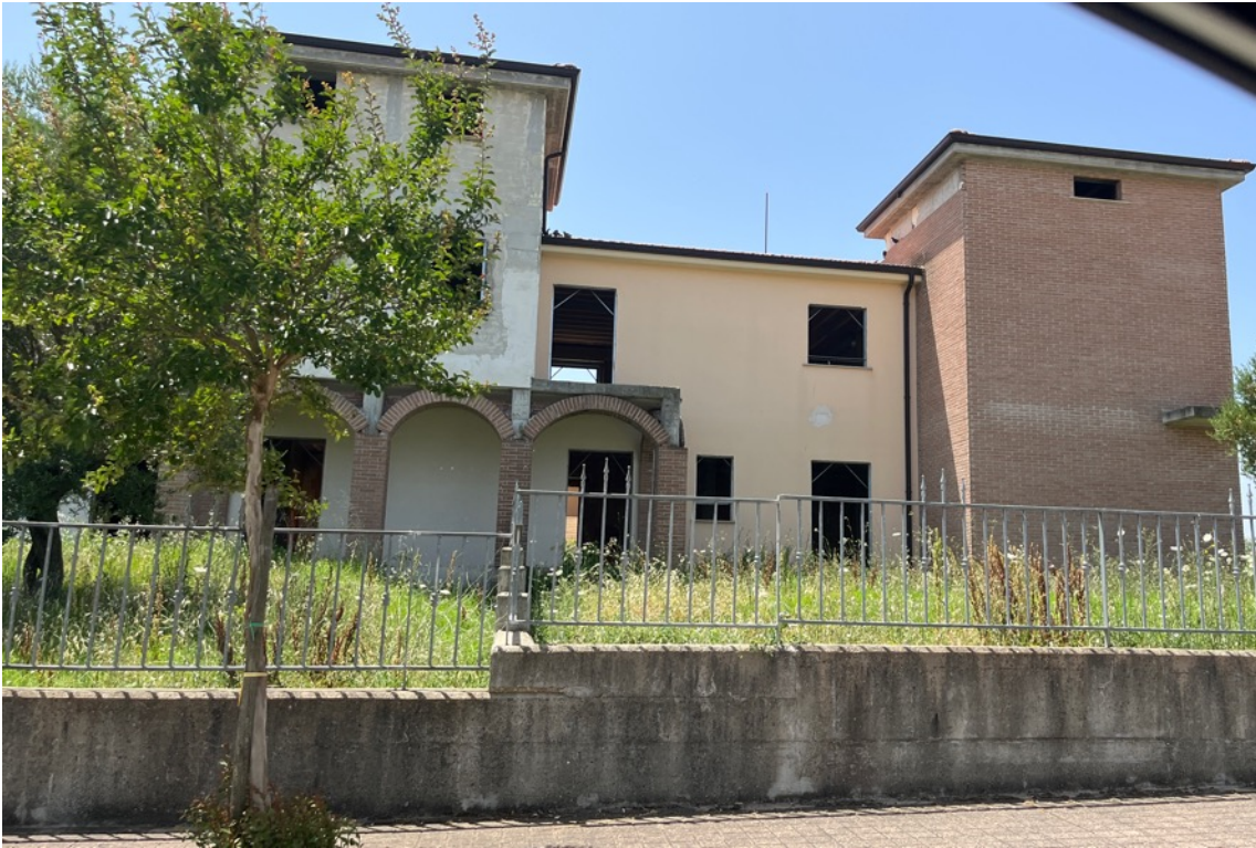
Fig.5 – Vista della facciata e del giardino antistante (fronte nord)
