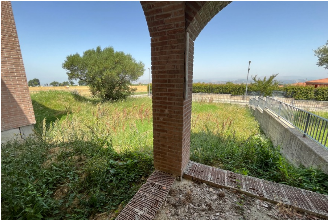
Fig.11 – Vista dei giardini pertinenziali dal porticato (da sud verso nord)
