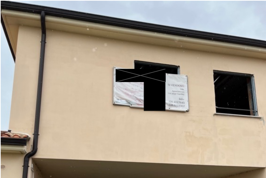
Fig.1 – Vista di accesso al complesso in via Bosco Lupino
