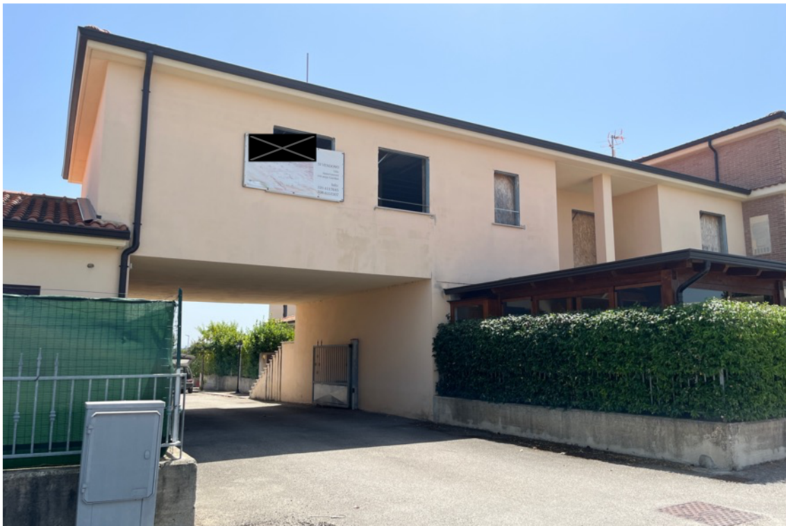
Fig.2 – Vista di accesso al complesso in via Bosco Lupino
