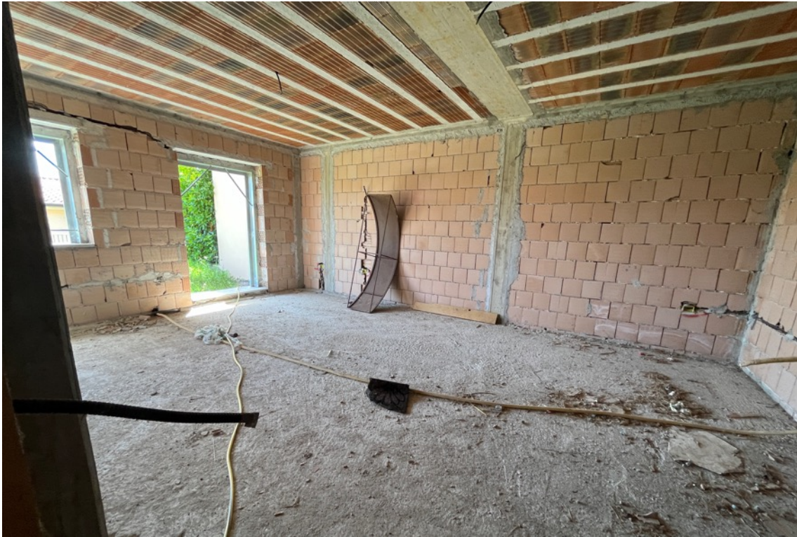
Fig.16 – Vista di un vano interno a rustico
