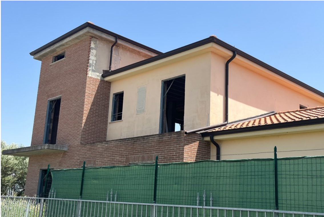
Fig.3 – Vista della facciata dell’Immobile (fronte nord-ovest)
