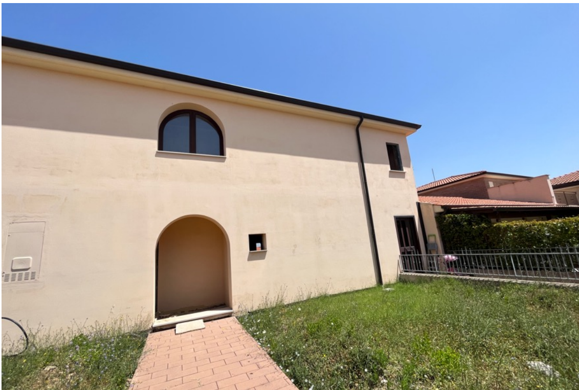
Fig.9 – Vista della facciata (fronte sud-est)
