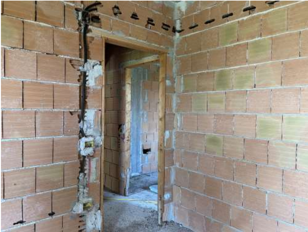
Fig.7 – Vista interni piano terra
