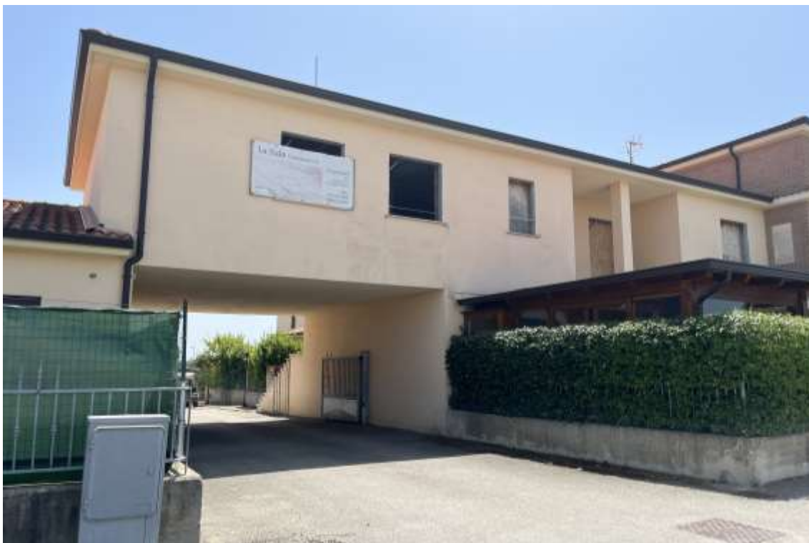
Fig.2 – Vista accesso al complesso in via Bosco Lupino
