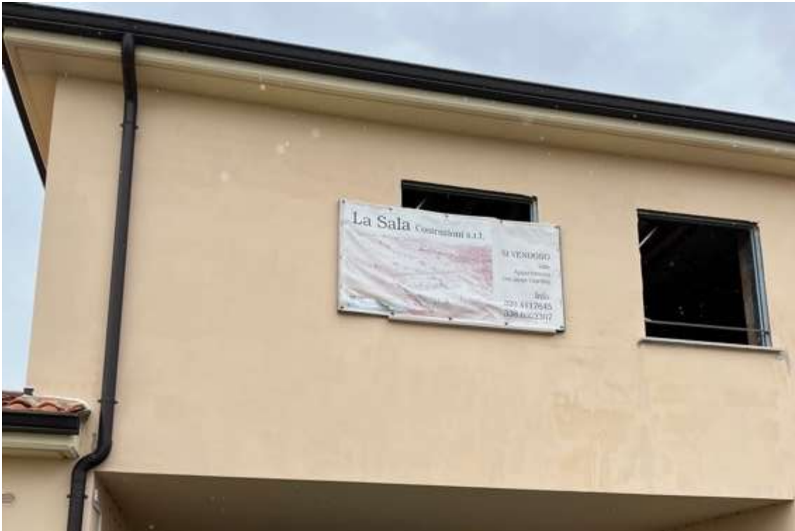
Fig.1 – Vista accesso al complesso in via Bosco Lupino
