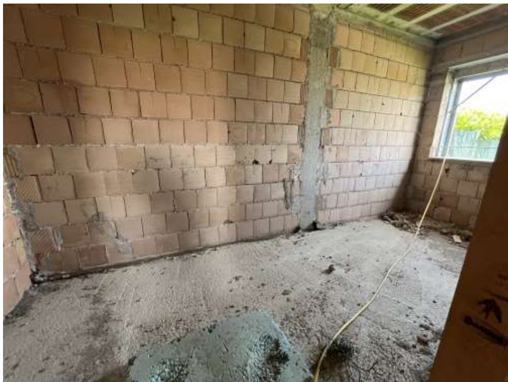
Fig.6 – Vista interni piano terra
