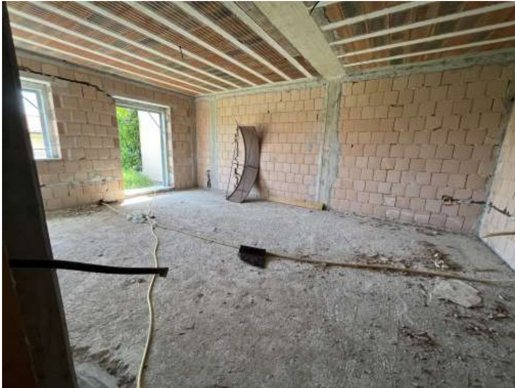
Fig.5 – Vista interni piano terra
