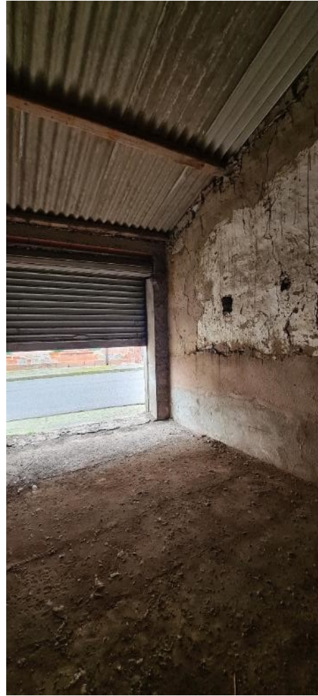
Locale garage lato destro – via N. Sauro n.32
