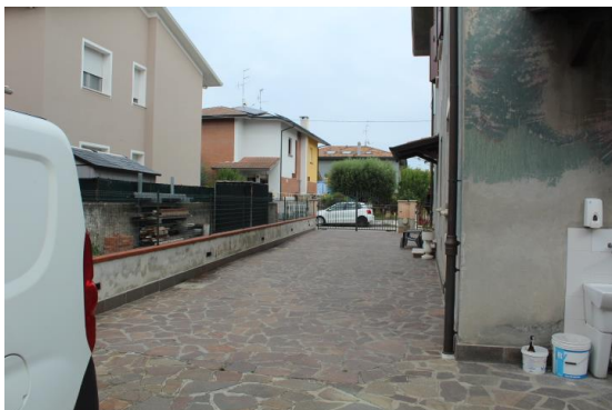
CORTE COMUNE LATO NORD, CON PARTICOLARE PORTONE DI ACCESSO CARRABILE
