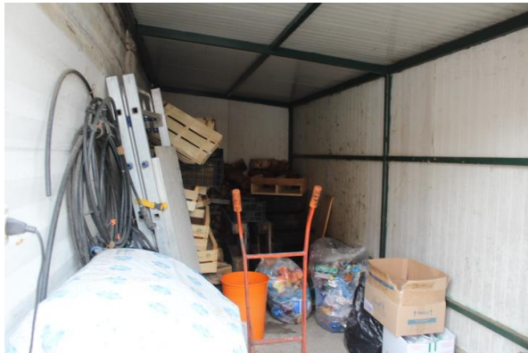
MANUFATTO ABUSIVO DA DEMOLIRE POSTO AL PIANO TERRA, DI LATO ALL'AUTORIMESSA PIGNORATA SUB. 5
