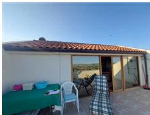
Particolare terrazza piano quarto
