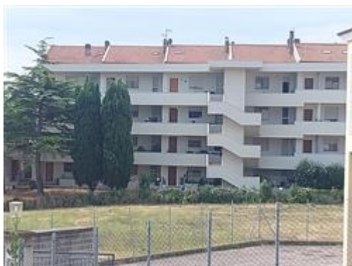
Vista generale condominio- facciata principale
