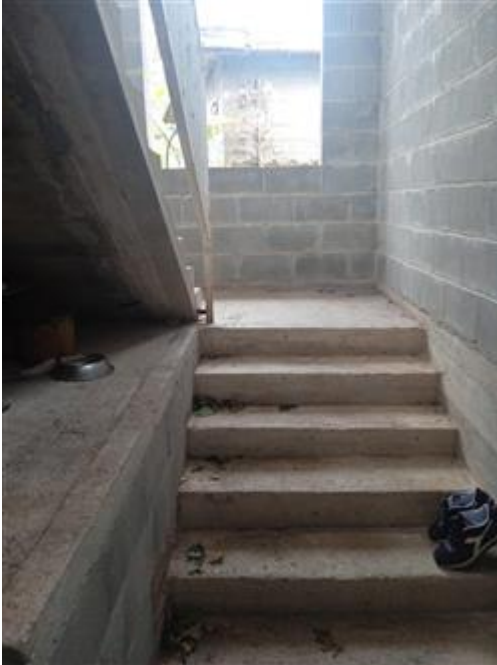
Foto n. 14 scala di collegamento tra il piano terra e primo piano
