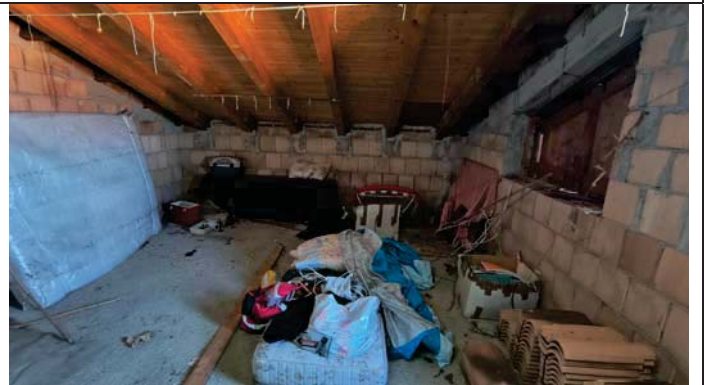
Realizzazione di piano sottotetto e di differente copertura
