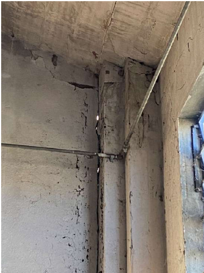
Viste delle lesioni strutturali presenti, in particolare nella parete nord/ovest del fabbricato destinato a laboratorio
