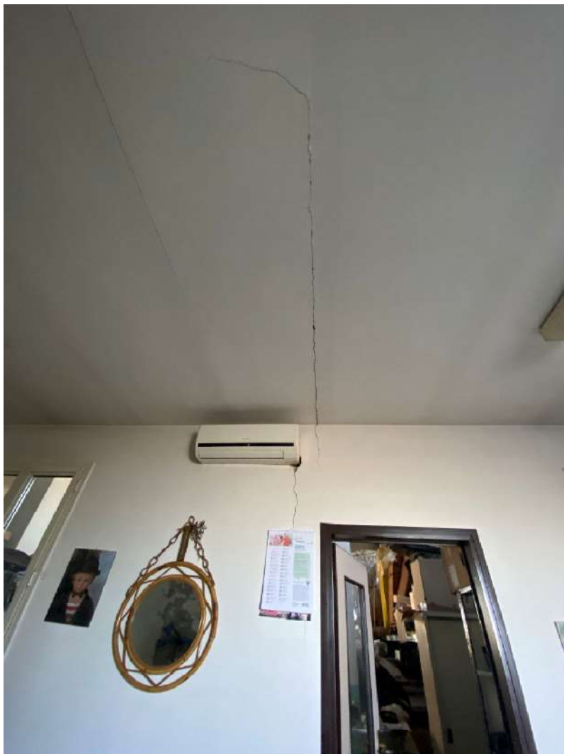
Viste delle lesioni strutturali presenti in parete e nel solaio di copertura dell'ambiente destinato ad ufficio
