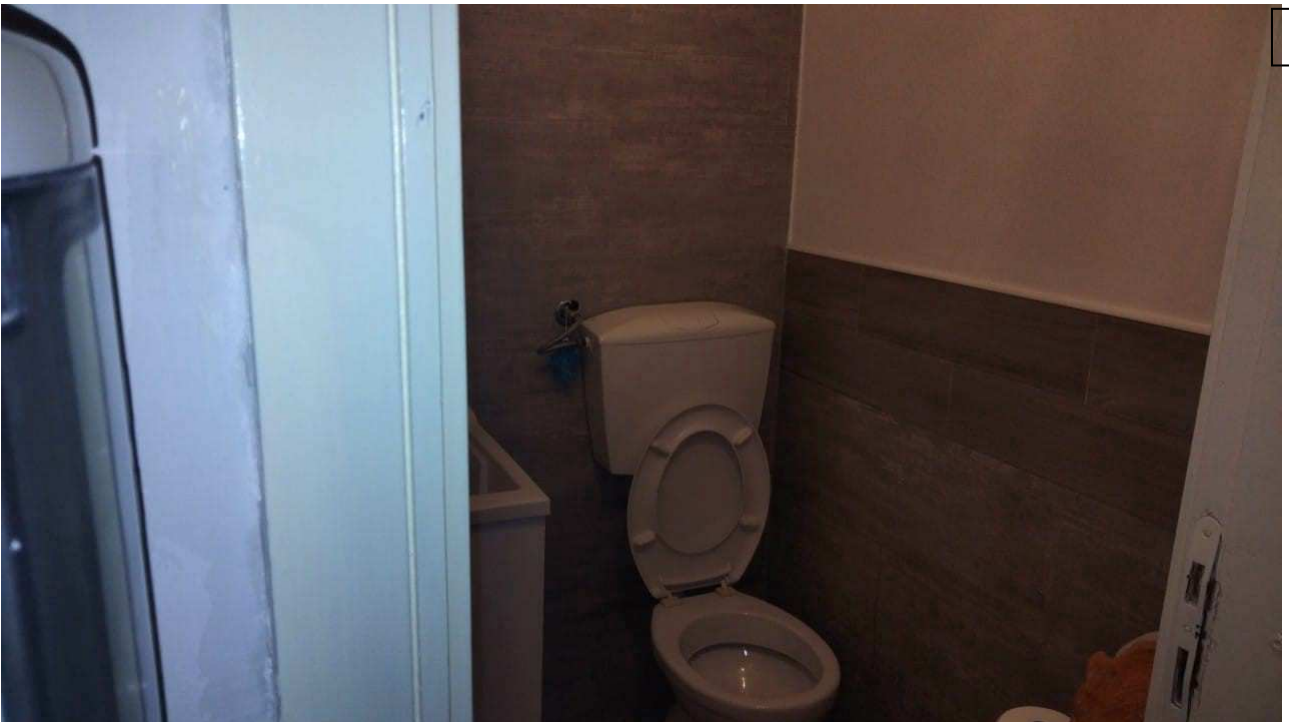
Locale commerciale al piano terra dettaglio w.c.
