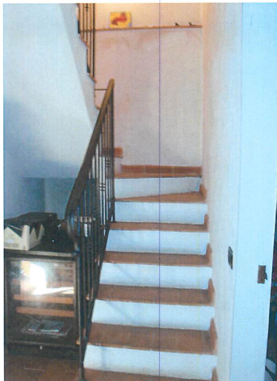
Foto 3. Piano terra - scala interna
