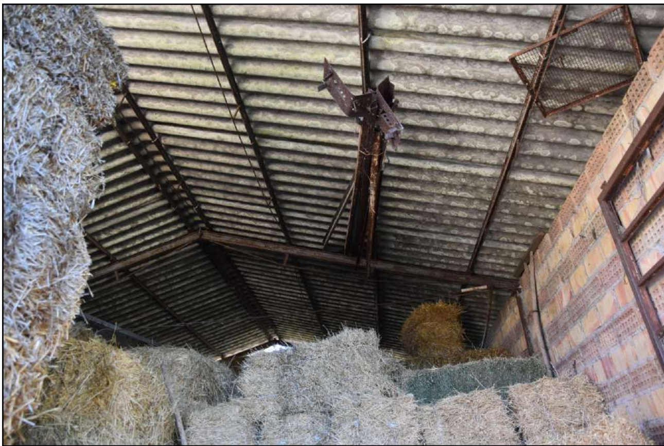
Foto n. 13: Interno piano primo deposito – Fienile (P.lla 159, Sub. 4)
