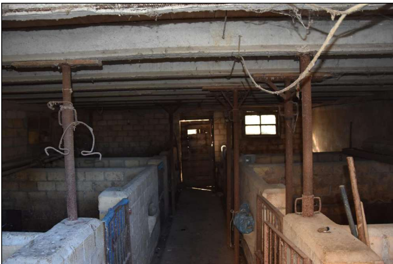
Foto n. 12: Interno piano terra deposito – Porcilaia (P.lla 159, Sub. 4)
