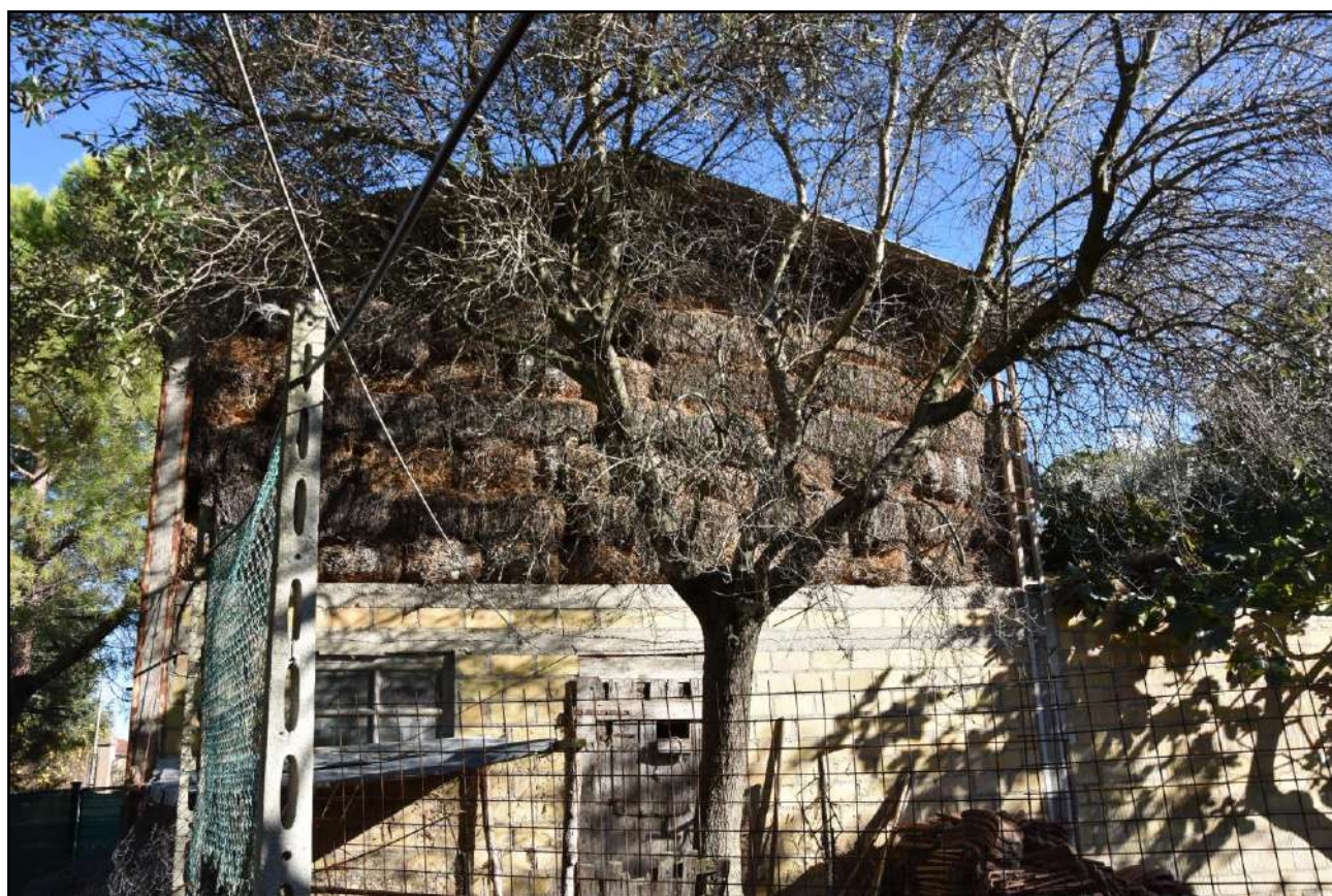
Foto n. 10: Prospetto Ovest deposito – Fienile/Porcilaia (P.Illa 159, Sub. 4)
