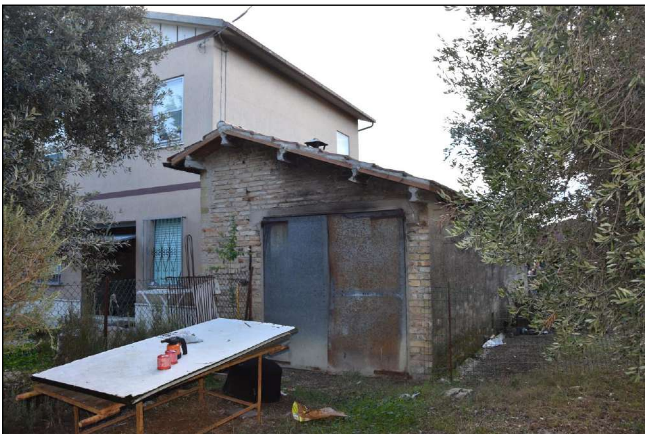
Foto n. 04: Prospetto Est deposito (P.lla 159, Sub. 2)
