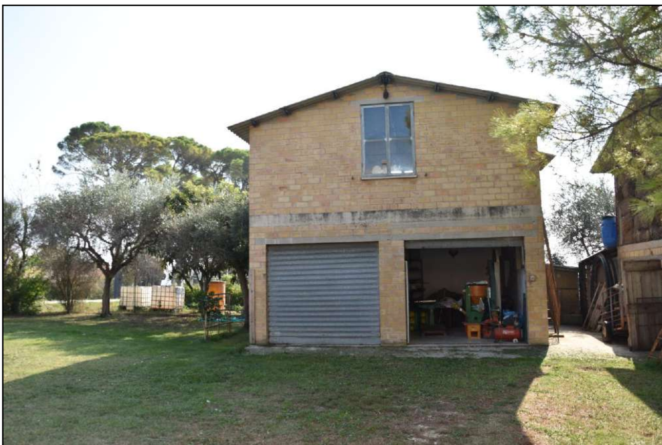
Foto n. 14: Prospetto Nord deposito (P.lla 159, Sub. 4)
