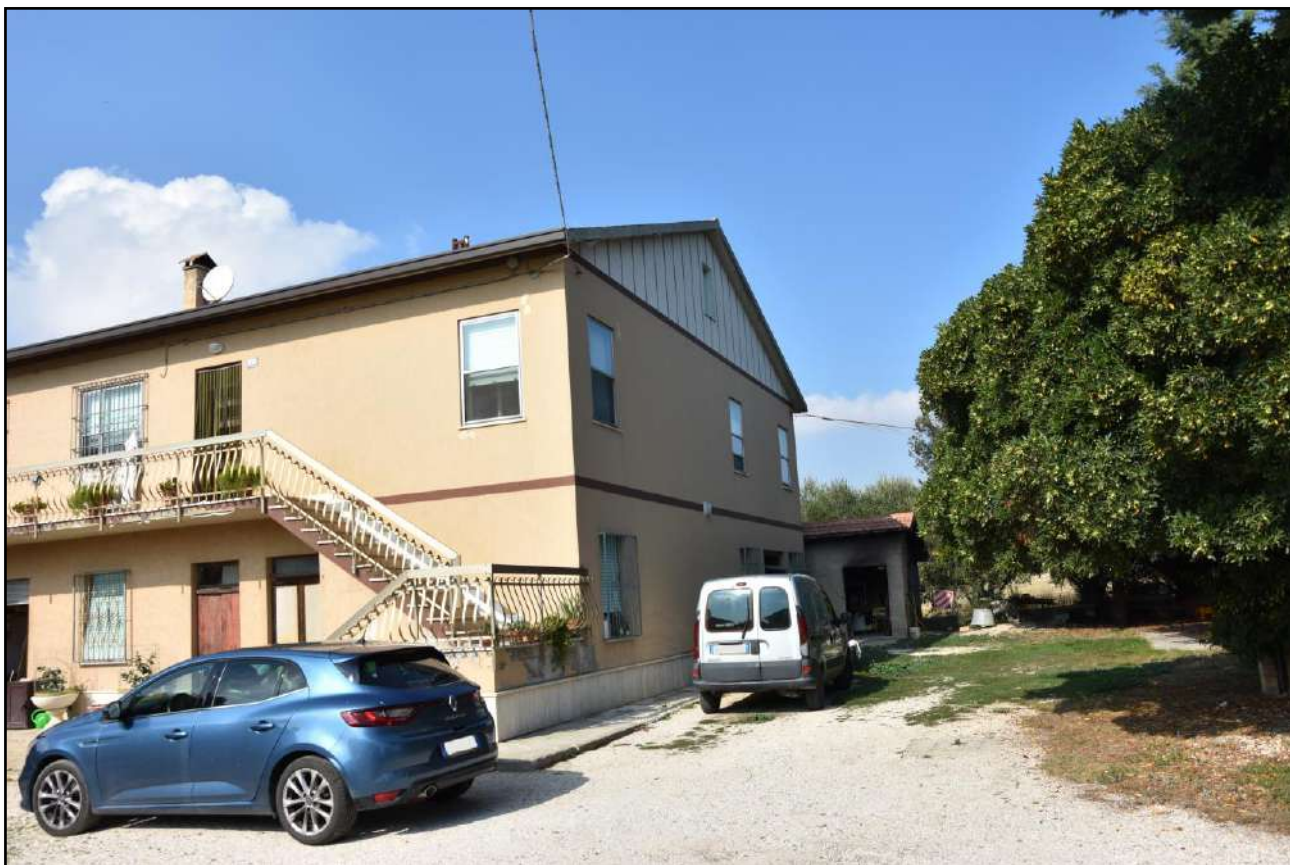
Foto n. 02: Prospetto Sud ed Est edificio principale (P.lla 159, Sub. 2 e 3)
