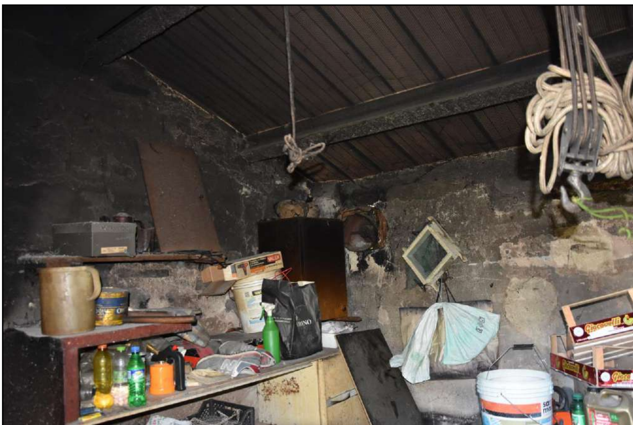
Foto n. 06: Interno del deposito (P.lla 159, Sub. 2)
