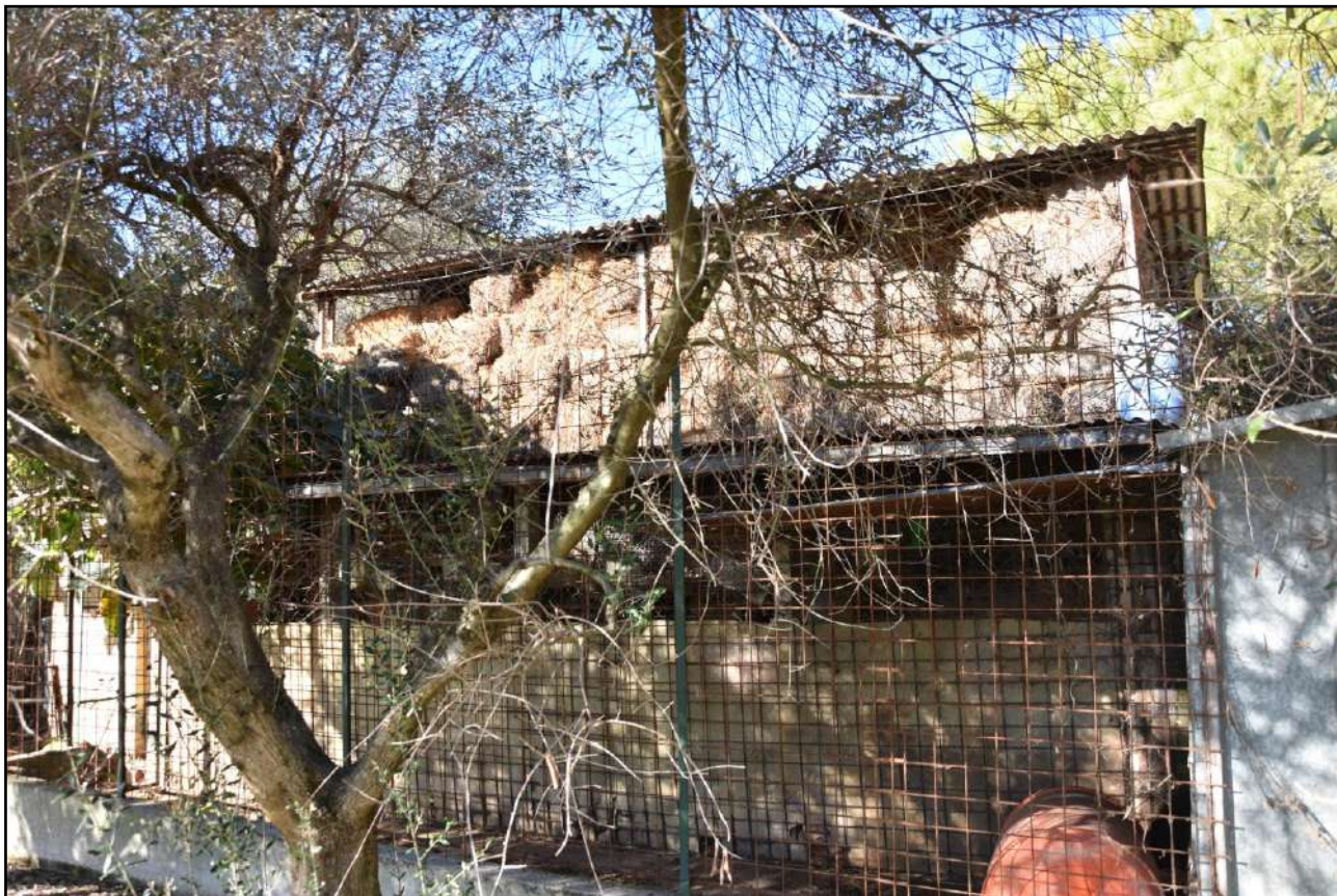
Foto n. 11: Prospetto Sud deposito – Fienile/Porcilaia (P.lla 159, Sub. 4)
