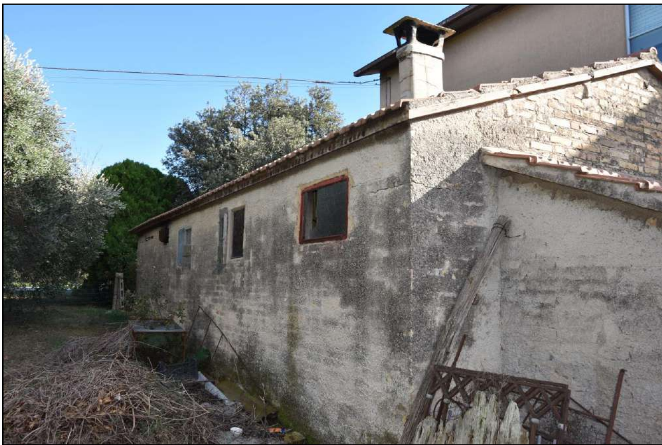
Foto n. 05: Prospetto Nord deposito (P.lla 159, Sub. 2)
