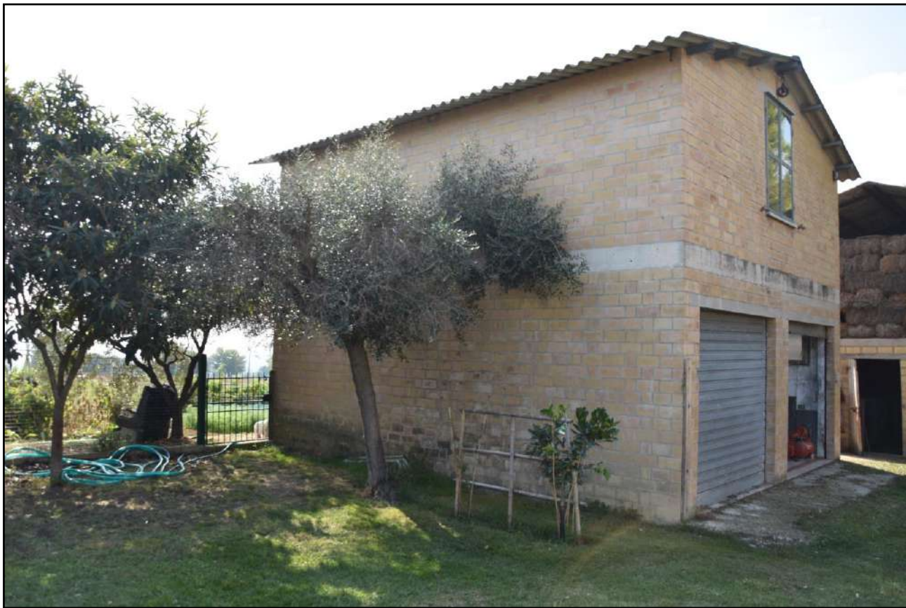
Foto n. 15: Prospetto Nord ed Est deposito (P.lla 159, Sub. 4)
