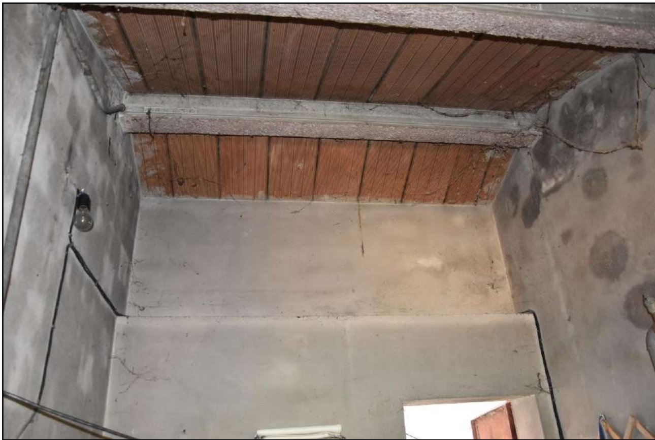
Foto n. 07: Interno del deposito (P.lla 159, Sub. 2)
