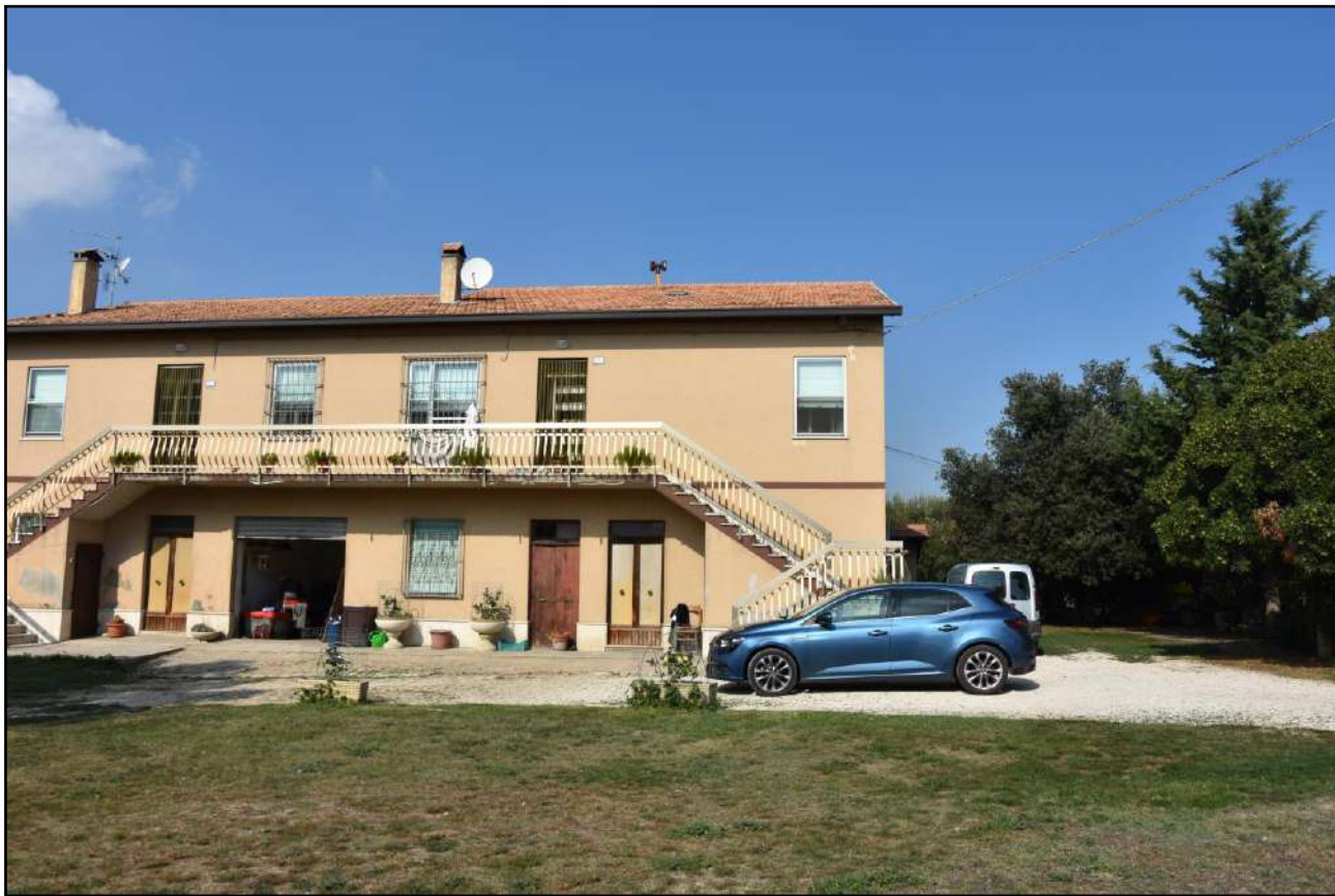
Foto n. 01: Prospetto Sud edificio principale (P.lla 159, Sub. 2 e 3)
