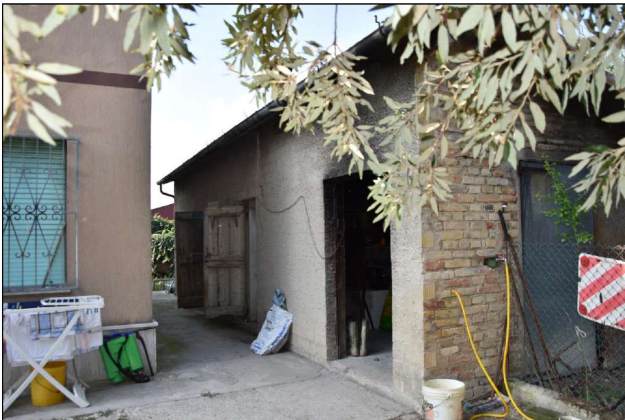
Foto n. 03: Prospetto Sud ed Est deposito (P.lla 159, Sub. 2)
