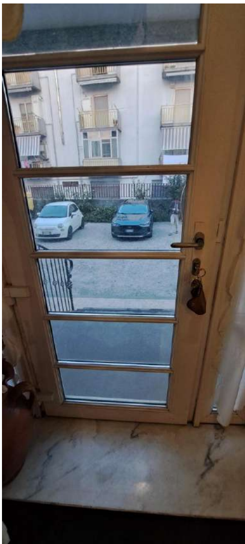
Figura 20 - Ingresso dal ballatoio - piano ammezz.
