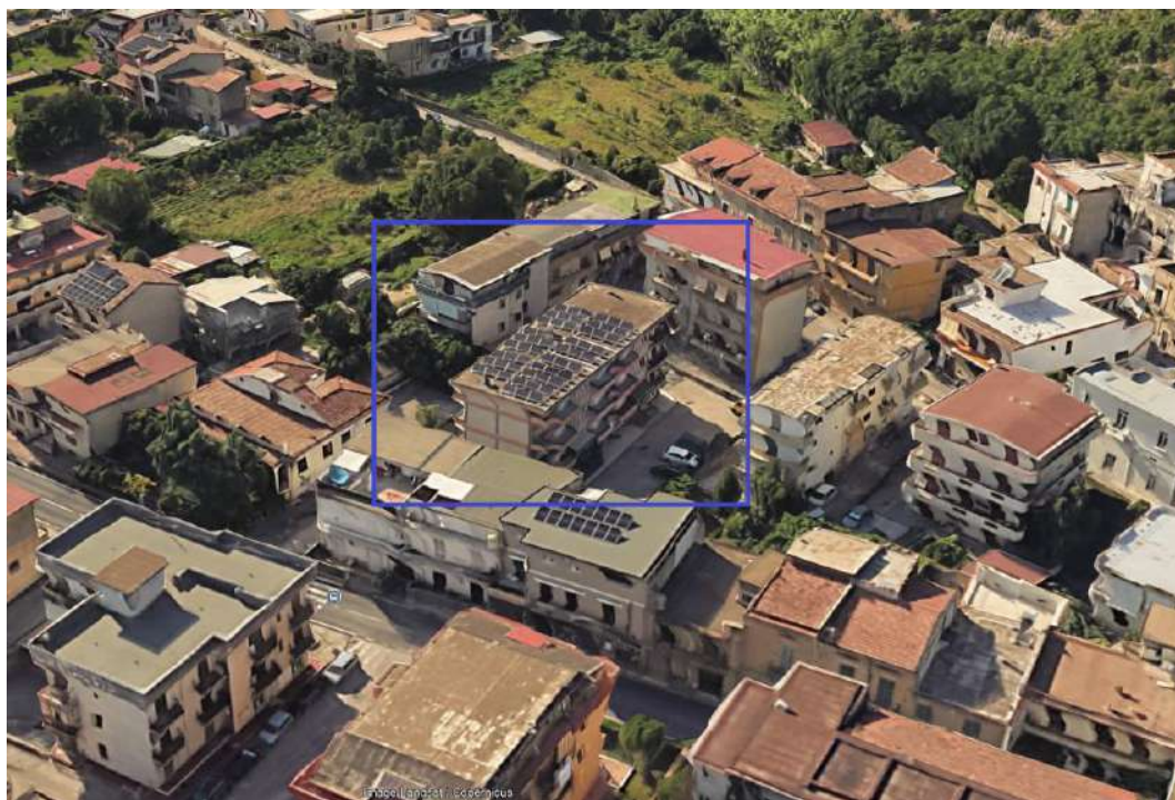
Figura 6 - Vista esterna DALL'ALTO dell'edificio in cui è sito l'immobile
