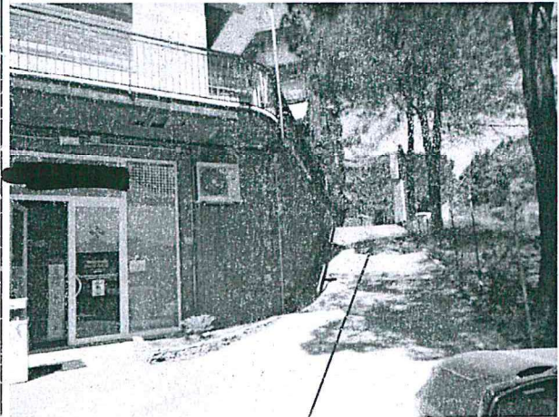
FOTO N.28 -- RAMPA DI ACCESSO DALLA VIA VERDI LOTTO N.5
