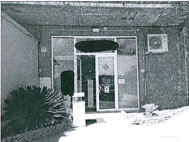
FOTO N.29 -- VANO DI ACCESSO ALL'IMMOBILE LOTTO N.5
