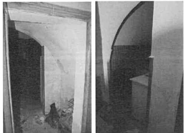
Varco di collegamento col civico 49
