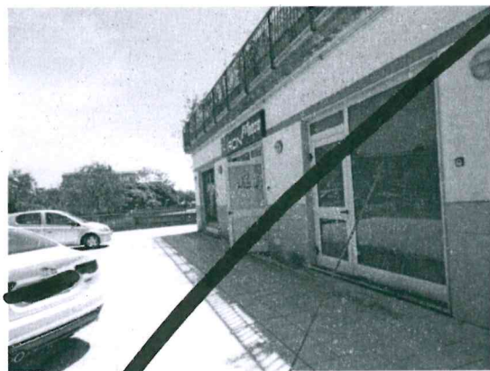
FOTO N.40 – LOCALE COMMERCIALE IN VIA PIRANDELLO N. RETRO PROSPETTO - LOTTO N.7
