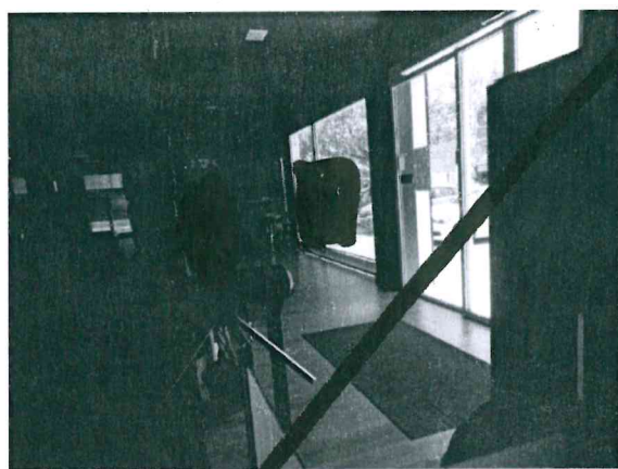
FOTO N.39 – ZONA INGRESSO DA VIA PIRANDELLO LOTTO N.7
