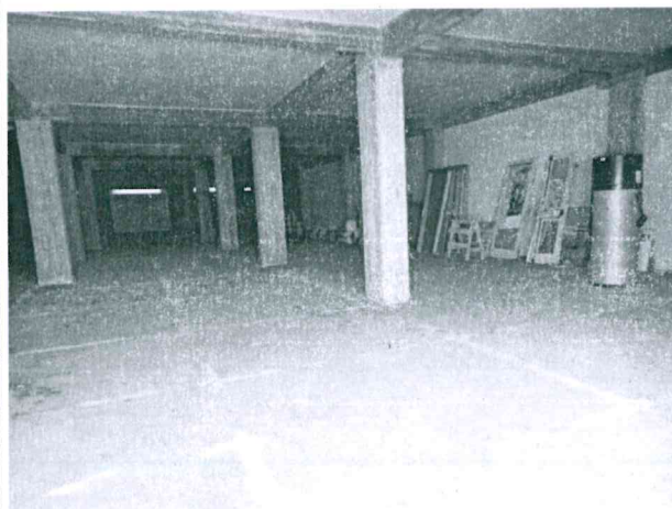
FOTO N.37 – INTERNO MAGAZZINO LOTTO N.6
