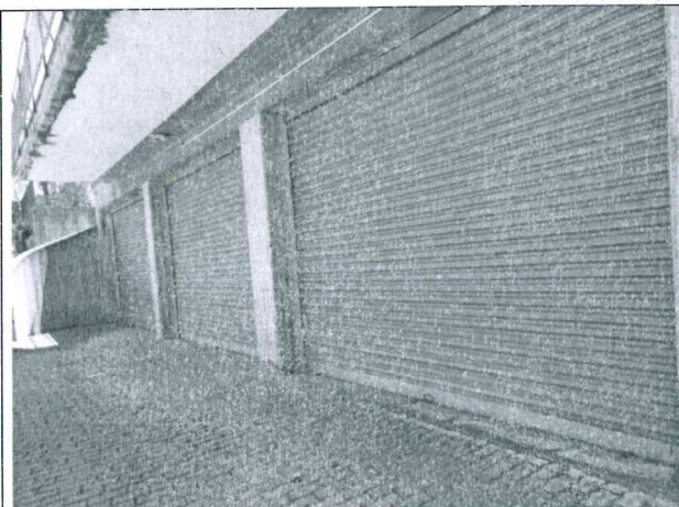
FOTO N.35 – VANI DI ACCESSO AL MAGAZZINO DI CUI AL LOTTO N.6
