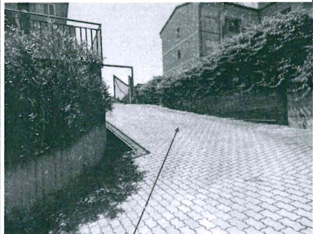
FOTO N.34 - RAMPA DI ACCESSO DALLA VIA PIRANDELLO AL PIANO INTERRATO IN CUI È UBIKATO IL MAGAZZINO DI CUI AL LOTTO N.6
