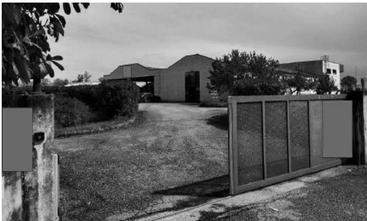
Lotto 1 – Comune di San Giorgio della Richinvelda, (PN) – Via Pietro Zorutti, 10 – foglio 21 particella 291 – Veduta esterna, da posizione sud-ovest, dell'accesso al compendio immobiliare che si trova sulla particella 291, costituito dal capannone agricolo e da una serie di locali adibiti all'attività produttiva vivaistica viticola.
