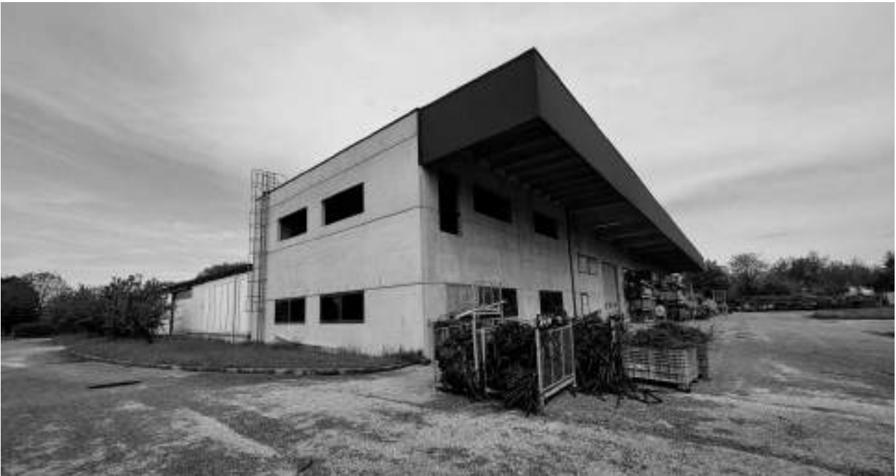
Lotto 1 – Comune di San Giorgio della Richinvelda (PN) – foglio 21 particella 372, subalterni 1, 2 e 3 – Veduta esterna di porzione sud-est del fabbricato che insiste sul mappale 372, costituito da un capannone agricolo vivaistico al piano terra, identificato dal subalterno 1 e da una unità in corso di costruzione al primo piano, identificata dal sub 2; l'area comune di pertinenza, asfaltata, è identificata al sub 3.
