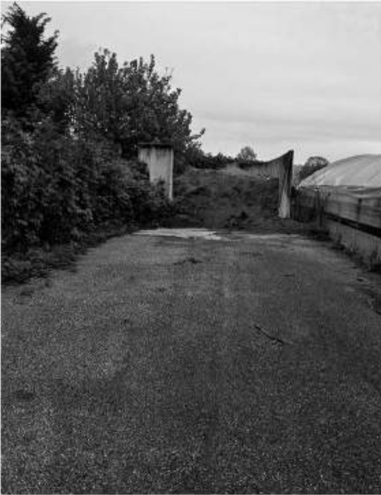
Lotto 1 – Comune di San Giorgio della Richinvelda (PN) – Via Pietro Zorutti, 10 – foglio 21 particella 291 – Veduta esterna, da posizione sud, del silo utilizzato per deposito di segature e scarti di lavorazione.
