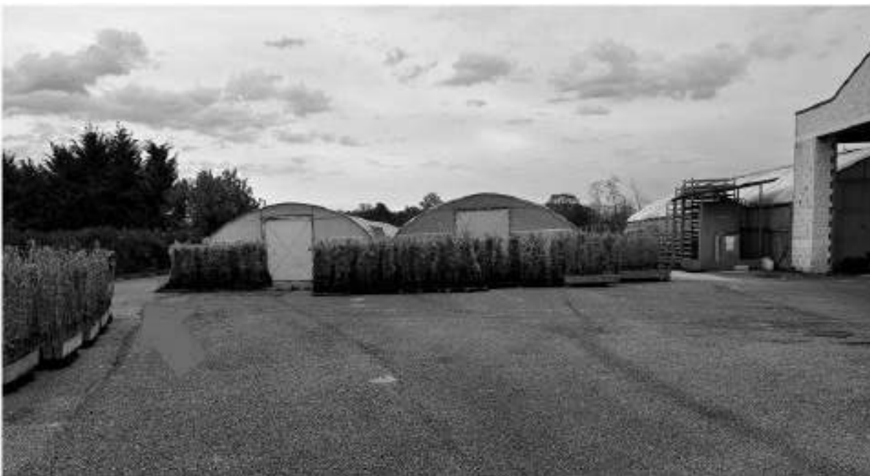
Lotto 1 – Comune di San Giorgio della Richinvelda (PN) – Via Pietro Zorutti, 10 – foglio 21 particella 291 – Veduta, da posizione sud, dei due tunnel freddi, adiacenti alle strutture di cui sopra; a sinistra (indicata da freccia rossa) la via d'accesso al silo.
