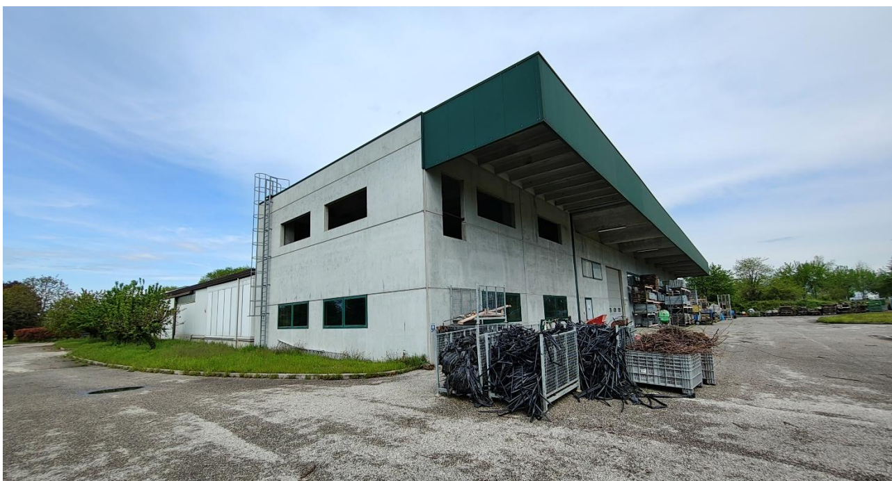
Foto n°8 – Lotto 1 – Comune di San Giorgio della Richinvelda (PN) – foglio 21 particella 372, subalterni 1, 2 e 3 – Veduta esterna di porzione sud-est del fabbricato che insiste sul mappale 372, costituito da un capannone agricolo vivaistico al piano terra, identificato dal subalterno 1 e da una unità in corso di costruzione al primo piano, identificata dal sub 2; l'area comune di pertinenza, asfaltata, è identificata al sub 3.
