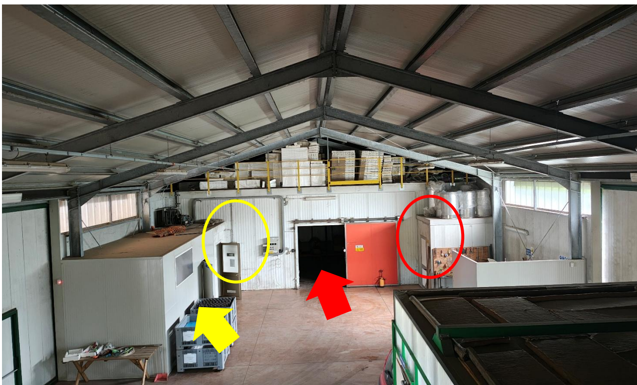
Foto n°42 – Lotto 1 – Comune di San Giorgio della Richinvelda (PN) – Via Pietro Zorutti, 10 – foglio 21 particella 291 – Piano primo – Veduta, dal ripostiglio di cui alla foto precedente, del deposito attrezzi posto al piano terra, con particolare del vano adibito a spogliatoio (indicato da freccia gialla), non rappresentato in planimetria catastale, dei servizi igienici (indicati dal cerchio giallo), dell'ingresso alla cella frigo (indicato dalla freccia rossa), del ripostiglio (indicato dal cerchio rosso).
