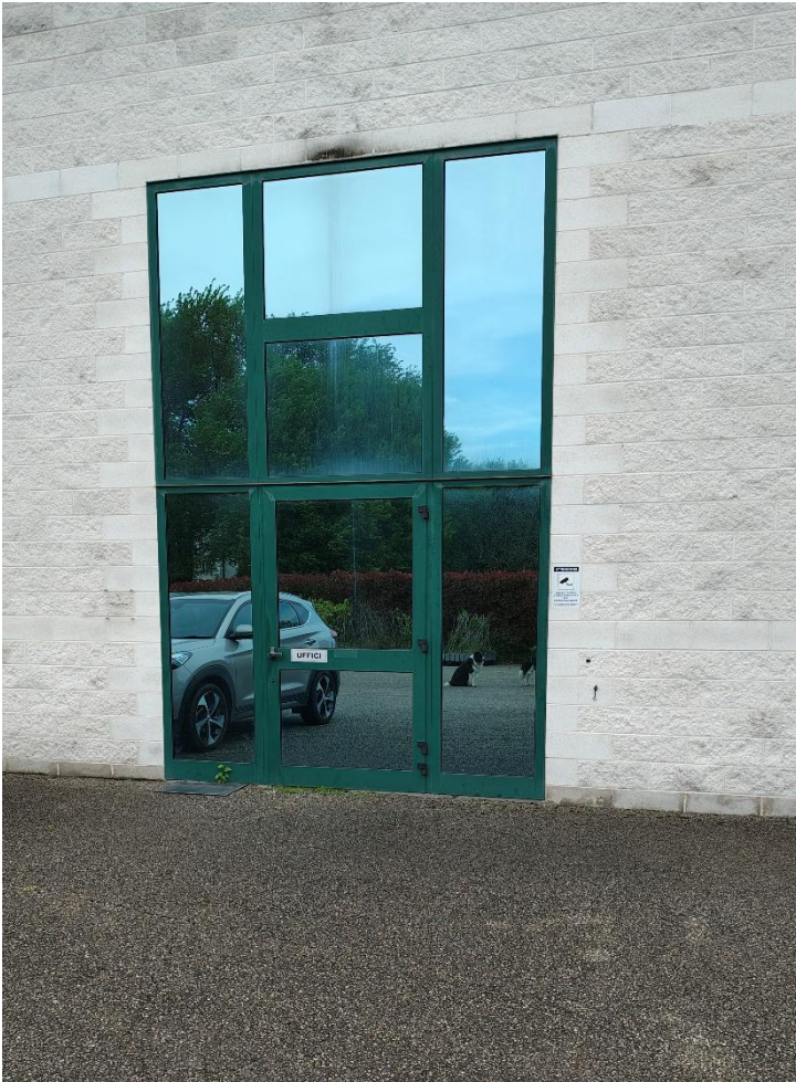
Foto n°15 – Lotto 1 – Comune di San Giorgio della Richinvelda (PN) – Via Pietro Zorutti, 10 – foglio 21 particella 291 – Particolare, da posizione ovest, del portoncino di ingresso al capannone agricolo vivaistico, dove sono presenti gli uffici, la mensa, gli spogliatoi con i servizi, il deposito attrezzi e la cella frigo al piano terra, gli archivi e i depositi al primo piano.
