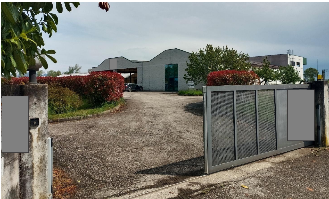
Foto n°1 – Lotto 1 – Comune di San Giorgio della Richinvelda, (PN) – Via Pietro Zorutti, 10 – foglio 21 particella 291 – Veduta esterna, da posizione sud-ovest, dell’accesso al compendio immobiliare che si trova sulla particella 291, costituito dal capannone agricolo e da una serie di locali adibiti all’attività produttiva vivaistica viticola.
