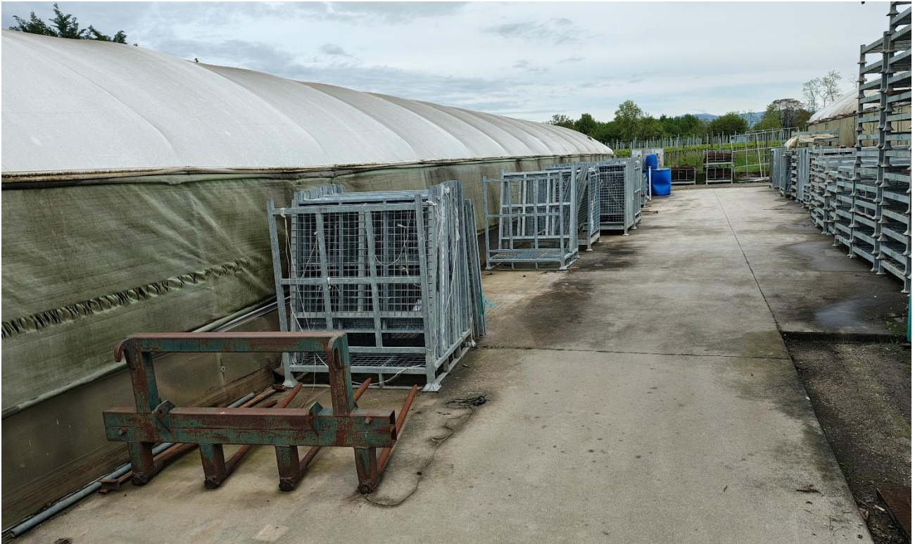
Foto n°59 – Lotto 1 – Comune di San Giorgio della Richinvelda (PN) – Via Pietro Zorutti, 10 – foglio 21 particella 291 – Veduta esterna, da posizione sud, dell'area cementata compresa fra il tunnel freddo della foto precedente e la serra prefabbricata.
