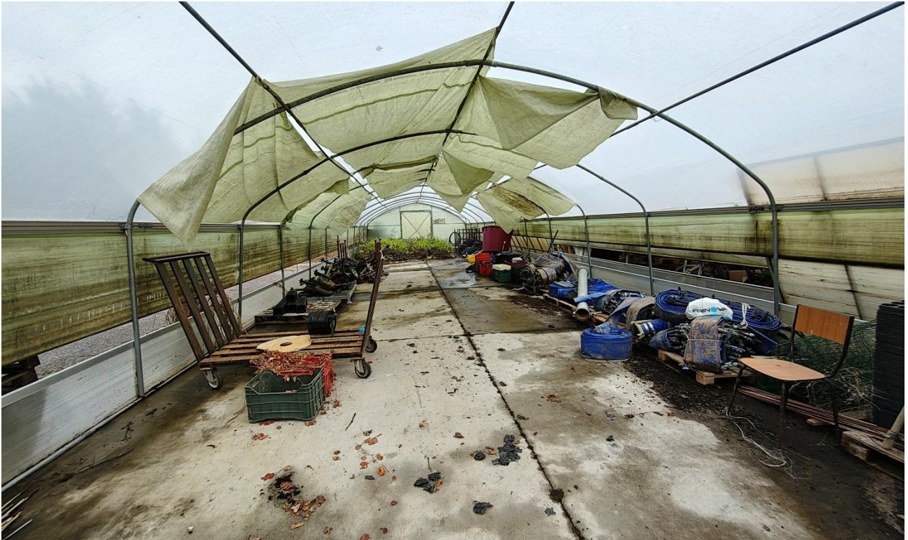
Foto n°57 – Lotto 1 – Comune di San Giorgio della Richinvelda (PN) – Via Pietro Zorutti, 10 – foglio 21 particella 291 – Veduta interna, da posizione sud, del tunnel freddo posto più a ovest.
