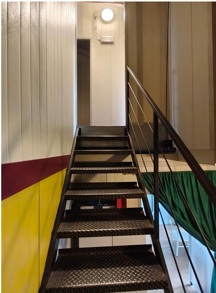
Foto n°30 – Lotto 1 – Comune di San Giorgio della Richinvelda (PN) – Via Pietro Zorutti, 10 – foglio 21 particella 291 – Piano terra – Ritornati al vano scale, veduta della rampa di scale di collegamento al corridoio del piano primo.
