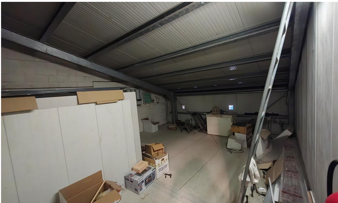
Foto n°37 – Lotto 1 – Comune di San Giorgio della Richinvelda (PN) – Via Pietro Zorutti, 10 – foglio 21 particella 291 – Piano primo – Veduta interna di porzione nord-ovest del deposito posto a nord.
