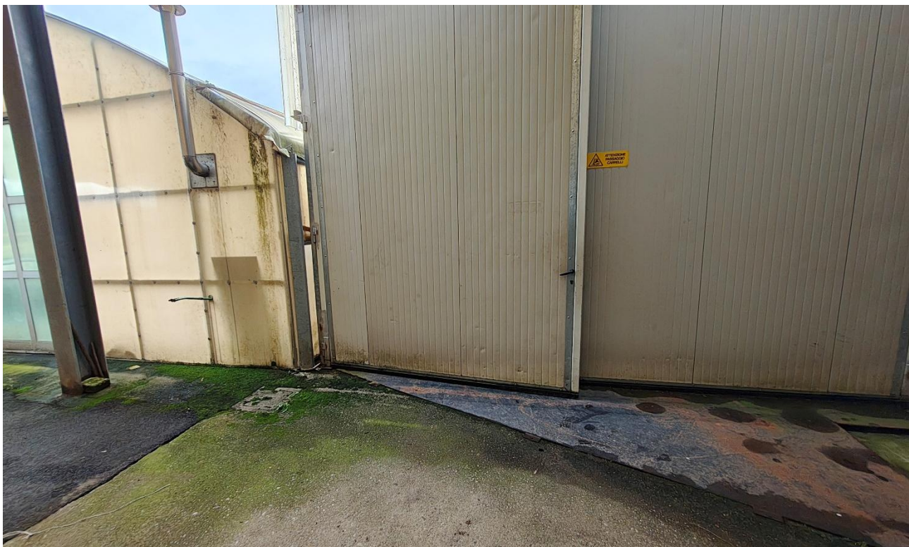
Foto n°65 – Lotto 1 – Comune di San Giorgio della Richinvelda (PN) – Via Pietro Zorutti, 10 – foglio 21 particella 291 – Veduta esterna, da posizione sud, del portone di ingresso al magazzino adiacente alla serra prefabbricata di cui alla precedente foto.
