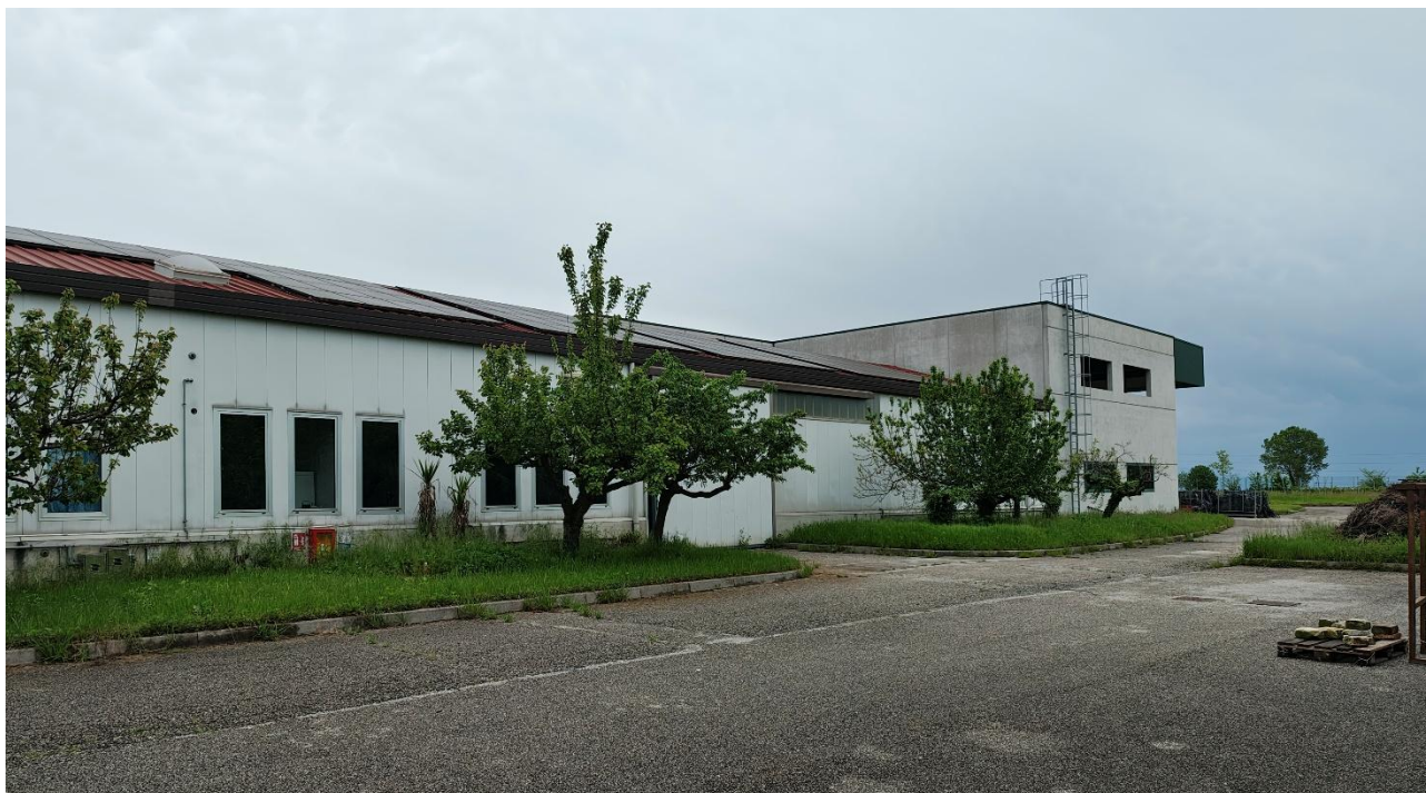
Foto n°7 – Lotto 1 – Comune di San Giorgio della Richinvelda (PN) – foglio 21 particelle 291 e 372, subalterni 1, 2 e 3 – Ritornati al piazzale principale, si prosegue in direzione est, lungo il vialetto di collegamento con l'ingresso in via Cjampagnatis. In primo piano il capannone agricolo vivaistico che insiste sulla particella 291, posto a ovest; sullo sfondo, in posizione est, si vede il capannone (sub 1) e l'unità immobiliare in fase di costruzione (sub 2), siti sulla particella 372.
