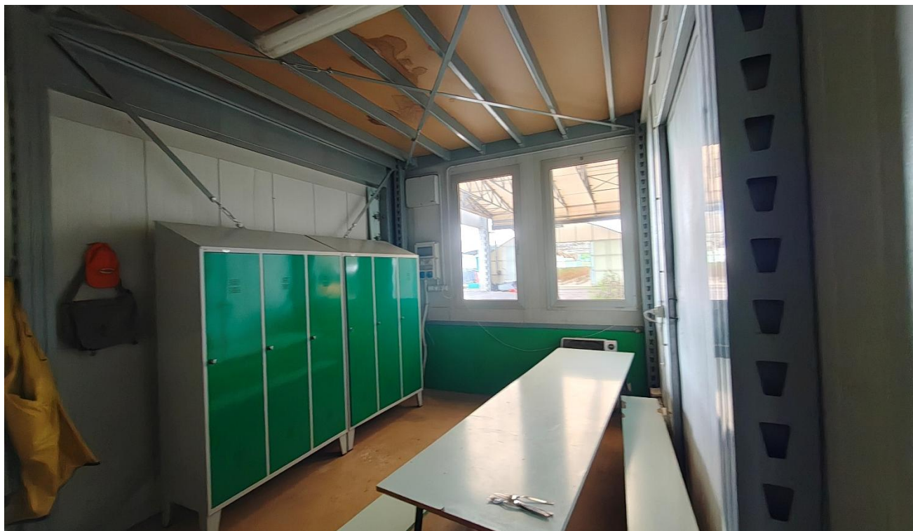
Foto n°44 – Lotto 1 – Comune di San Giorgio della Richinvelda (PN) – Via Pietro Zorutti, 10 – foglio 21 particella 291 – Piano terra – Veduta interna di porzione nord-ovest degli spogliatoi, con particolare delle finestre ad esposizione nord.
