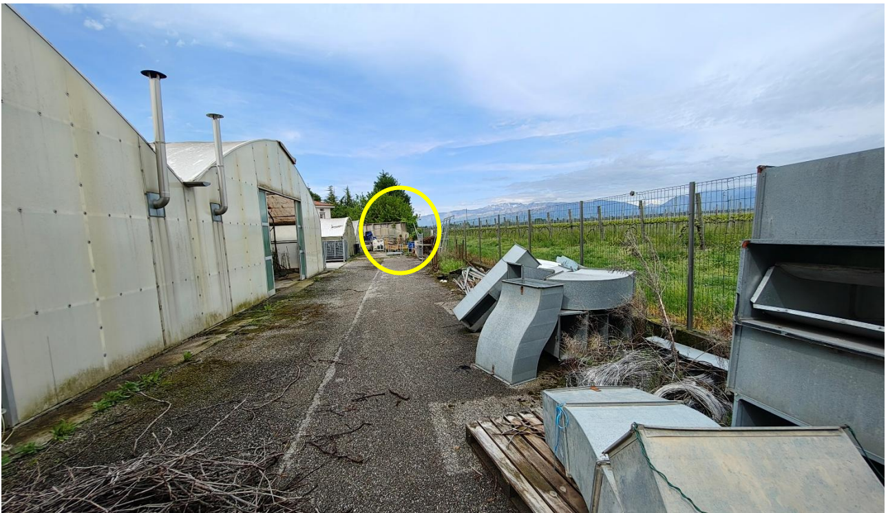
Foto n°14 – Lotto 1 – Comune di San Giorgio della Richinvelda (PN) – Via Pietro Zorutti, 10 – foglio 21 particella 291 – Veduta esterna di porzione nord delle serre prefabbricate, dei tunnel freddi e del silo (indicato nel cerchio giallo). Si osserva che il confine nord è recintato con rete metallica su pali in ferro zincato.
