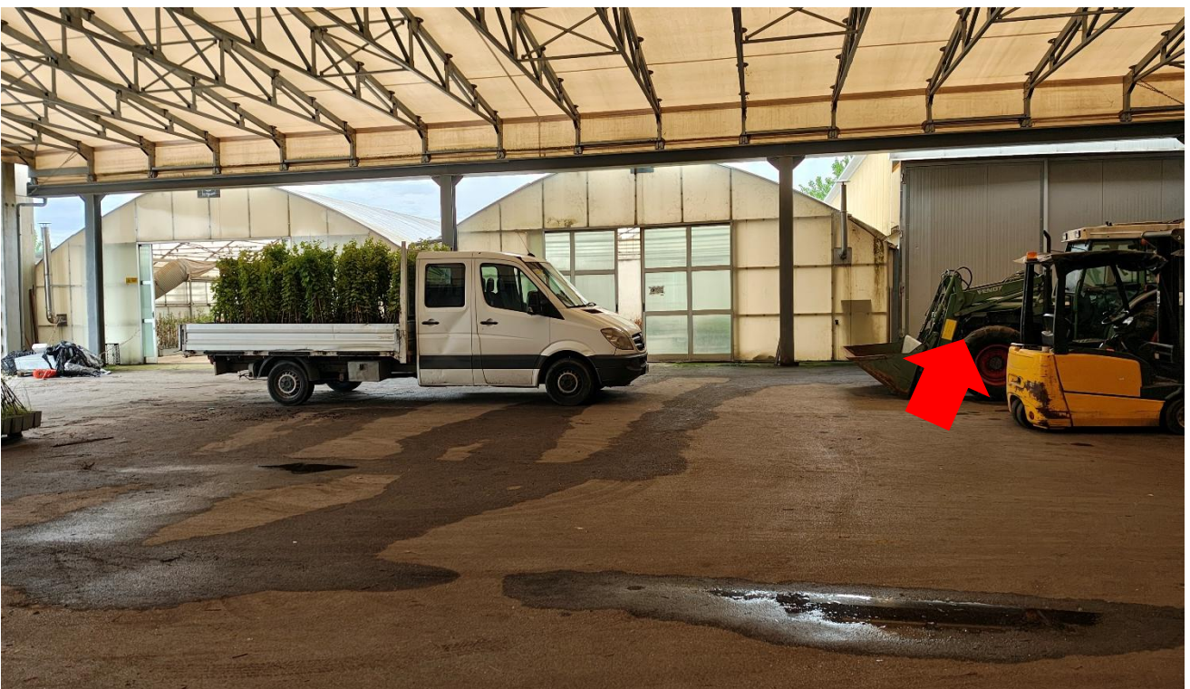
Foto n°56 – Lotto 1 – Comune di San Giorgio della Richinvelda (PN) – Via Pietro Zorutti, 10 – foglio 21 particella 291 – Veduta esterna di porzione nord della stessa tettoia, con vista delle due serre prefabbricate e del magazzino (indicato dalla freccia rossa).
