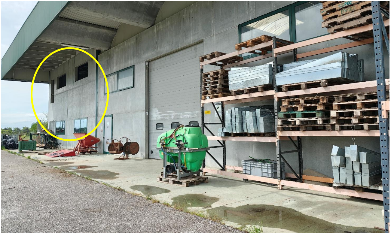
Foto n°75 – Lotto 1 – Comune di San Giorgio della Richinvelda (PN) – foglio 21 particella 372 sub 1, 2 e 3 – Usciti dal portone automatico sulla parete est, veduta esterna del complesso, con particolare dell'unità in corso di costruzione al primo piano (individuata dal cerchio giallo); si nota l'assenza del vano scale di collegamento al primo piano, rappresentato nelle planimetrie di progetto e catastali.
