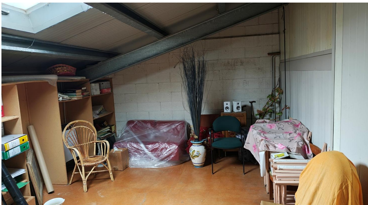
Foto n°34 – Lotto 1 – Comune di San Giorgio della Richinvelda (PN) – Via Pietro Zorutti, 10 – foglio 21 particella 291 – Piano primo – Veduta interna di porzione ovest del deposito posto a sud, con particolare del lucernaio, travi in acciaio e pannelli in monopanel di copertura.
