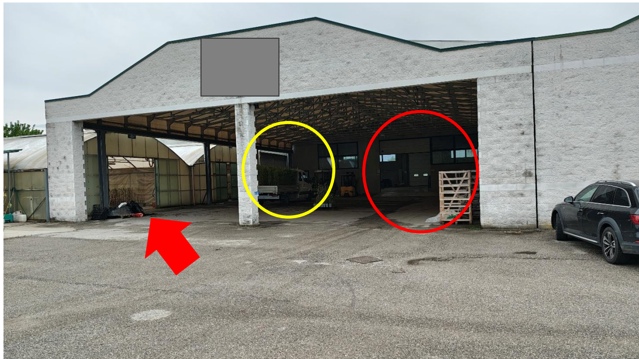
Foto n°4 – Lotto 1 – Comune di San Giorgio della Richinvelda (PN) – Via Pietro Zorutti, 10 – foglio 21 particella 291 – Veduta esterna, da posizione ovest, della tettoia adiacente al capannone agricolo vivaistico di cui sopra, con veduta delle serre prefabbricate (indicata da freccia rossa), del magazzino per barbatelle (identificato dal cerchio giallo) e dall’accesso al deposito del capannone agricolo identificato dal subalterno 1 della particella 372 (indicato dal cerchio rosso).
