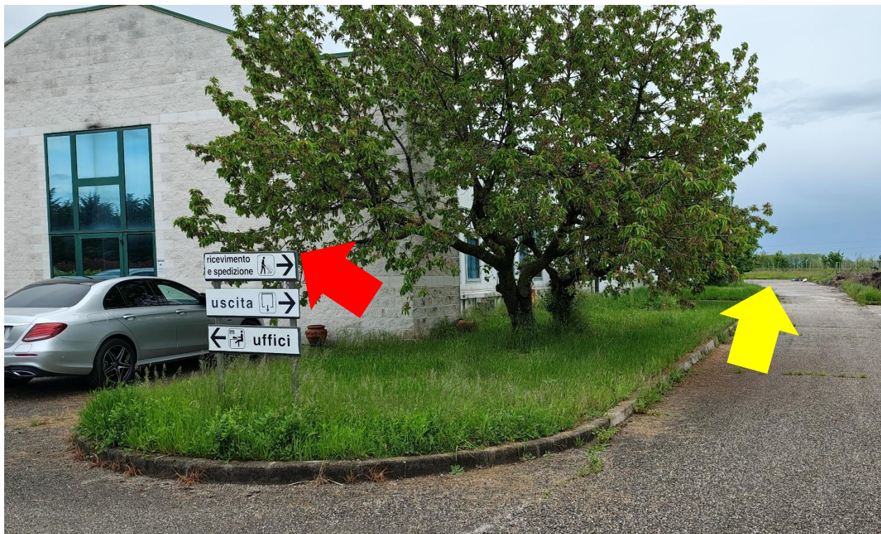
Foto n°3 – Lotto 1 – Comune di San Giorgio della Richinvelda (PN) – Via Pietro Zorutti, 10 – foglio 21 particella 291 – Veduta esterna, da posizione sud-ovest, di parte del capannone agricolo vivaistico con zona uffici (indicato da freccia rossa) e vialetto asfaltato (indicato da freccia gialla) di collegamento all’edificio che insiste sulla particella 372, in cui è presente anche l’accesso sulla strada comunale via Cjampagnatis.
