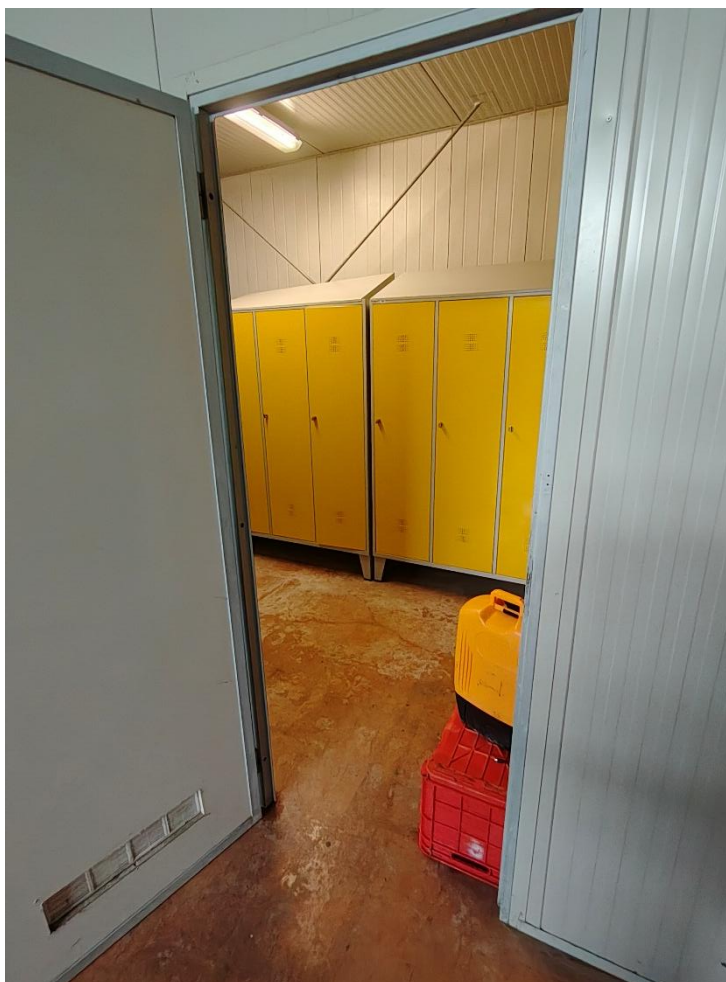
Foto n°53 – Lotto 1 – Comune di San Giorgio della Richinvelda (PN) – foglio 21 particella 291 – Piano terra – Veduta interna, da posizione sud, del vano adibito a spogliatoi, non rappresentato in planimetria catastale, con particolare della parete e del soffitto con pannelli in monopanel.
