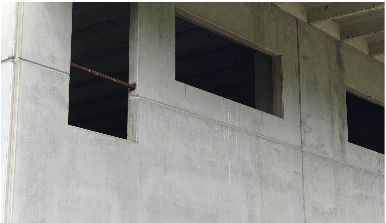
Foto n°76 – Lotto 1 – Comune di San Giorgio della Richinvelda (PN) – foglio 21 particella 372 sub 2 – Veduta esterna, da posizione sud-est, dell'unità in corso di costruzione.
