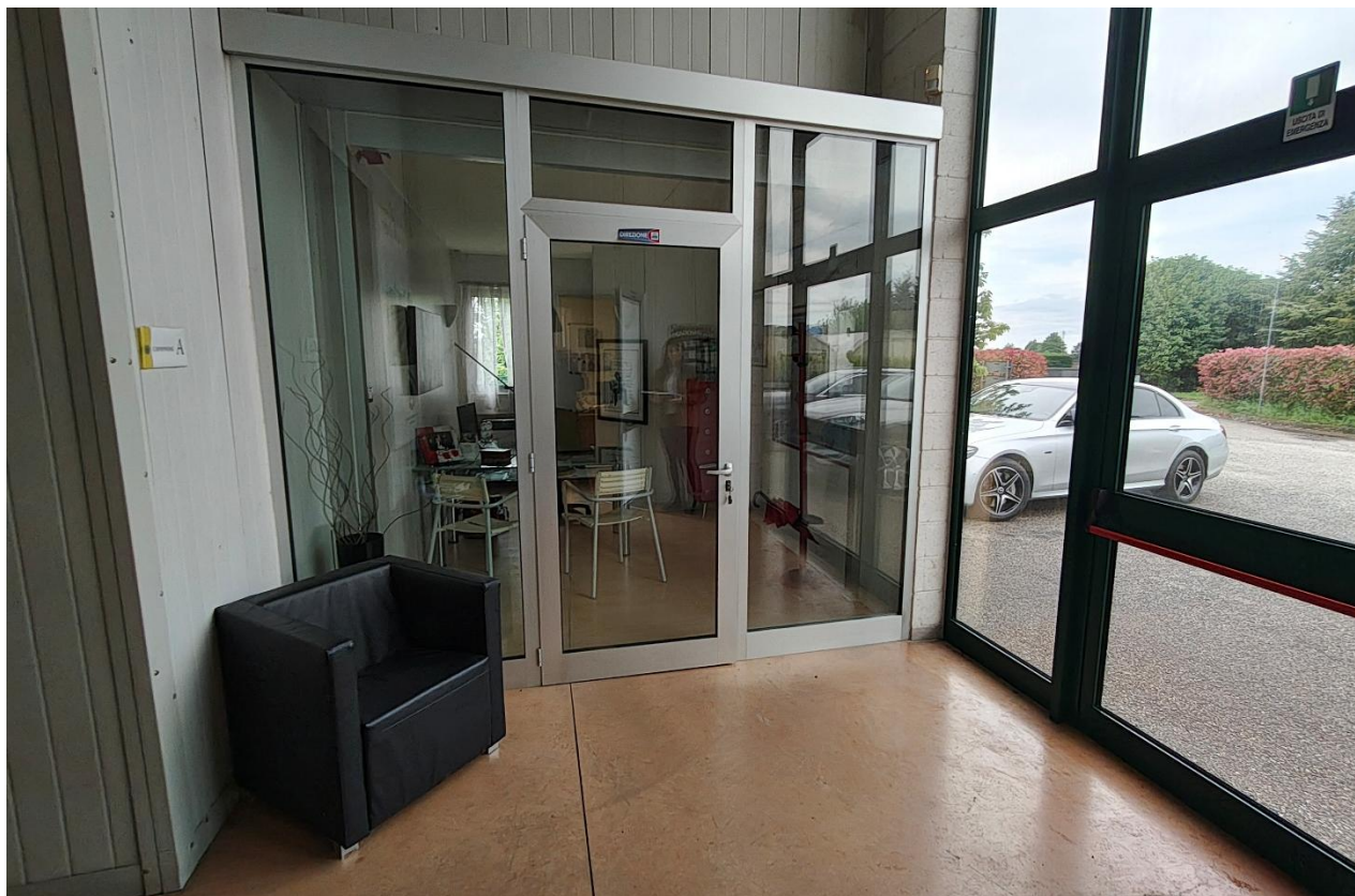
Foto n°19 – Lotto 1 – Comune di San Giorgio della Richinvelda (PN) – Via Pietro Zorutti, 10 – foglio 21 particella 291 – Piano terra – Ritornati nell’atrio, veduta esterna dell’ufficio posto a sud, con porta d’ingresso e parete con telaio in alluminio e tamponamento in vetro.
