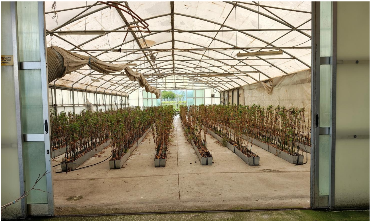
Foto n°61 – Lotto 1 – Comune di San Giorgio della Richinvelda (PN) – Via Pietro Zorutti, 10 – foglio 21 particella 291 – Veduta interna, da posizione sud, della serra di cui alla foto precedente; sullo sfondo si nota la seconda apertura, posta a nord.
