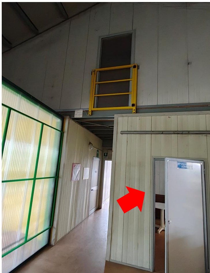
Foto n°43 – Lotto 1 – Comune di San Giorgio della Richinvelda (PN) – Via Pietro Zorutti, 10 – foglio 21 particella 291 – Piano terra – Ritornati al piano terra, veduta, da posizione nord-est, della parete della sala da pranzo (a sinistra), dell'apertura al primo piano di cui alla foto precedente (in alto al centro) e dell'accesso agli spogliatoi (indicato dalla freccia rossa).
