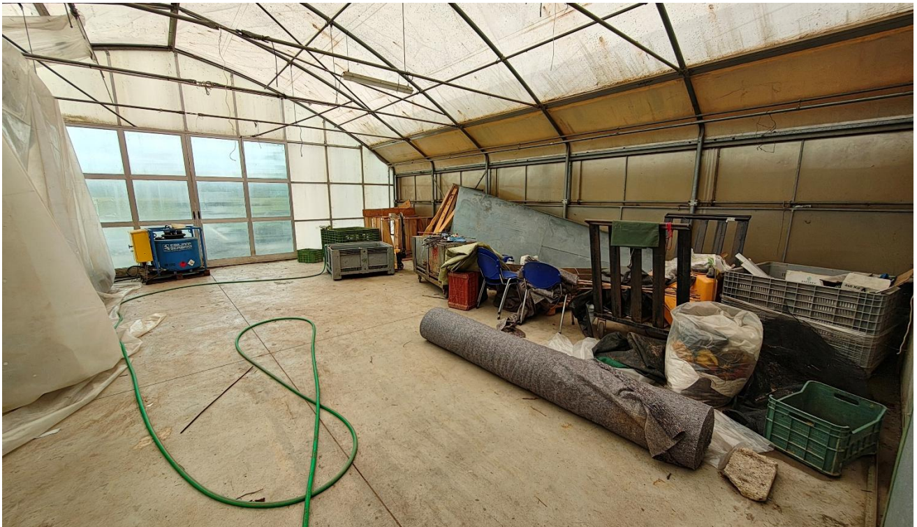
Foto n°64 – Lotto 1 – Comune di San Giorgio della Richinvelda (PN) – Via Pietro Zorutti, 10 – foglio 21 particella 291 – Oltrepasata la porta, veduta interna di porzione nord-est della serra, con seconda apertura a nord.
