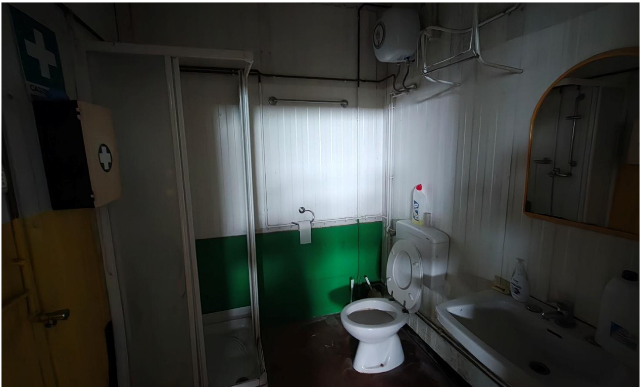
Foto n°52 – Lotto 1 – Comune di San Giorgio della Richinvelda (PN) – foglio 21 particella 291 – Piano terra – Veduta interna, da posizione sud, dei servizi igienici di cui alla foto precedente, dotati di sanitari, doccia e scaldacqua elettrico.
