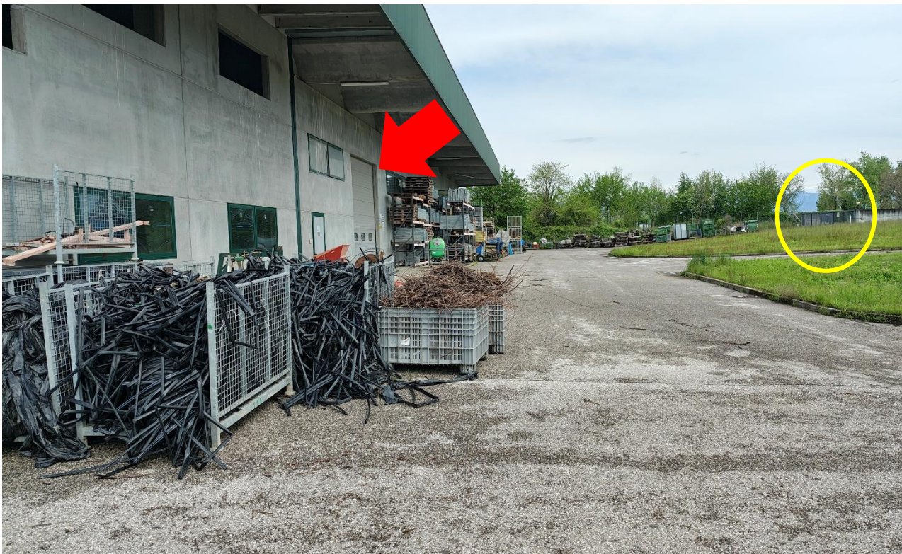
Foto n°9 – Lotto 1 – Comune di San Giorgio della Richinvelda (PN) – foglio 21 particella 372, subalterni 1, 2 e 3 – Veduta esterna, da posizione sud, del fabbricato di cui sopra, con particolare del portone di accesso per automezzi (indicato da freccia rossa); sullo sfondo si intravede il cancello automatico scorrevole (indicato dal cerchio giallo) che immette su via Cjampagnatis.
