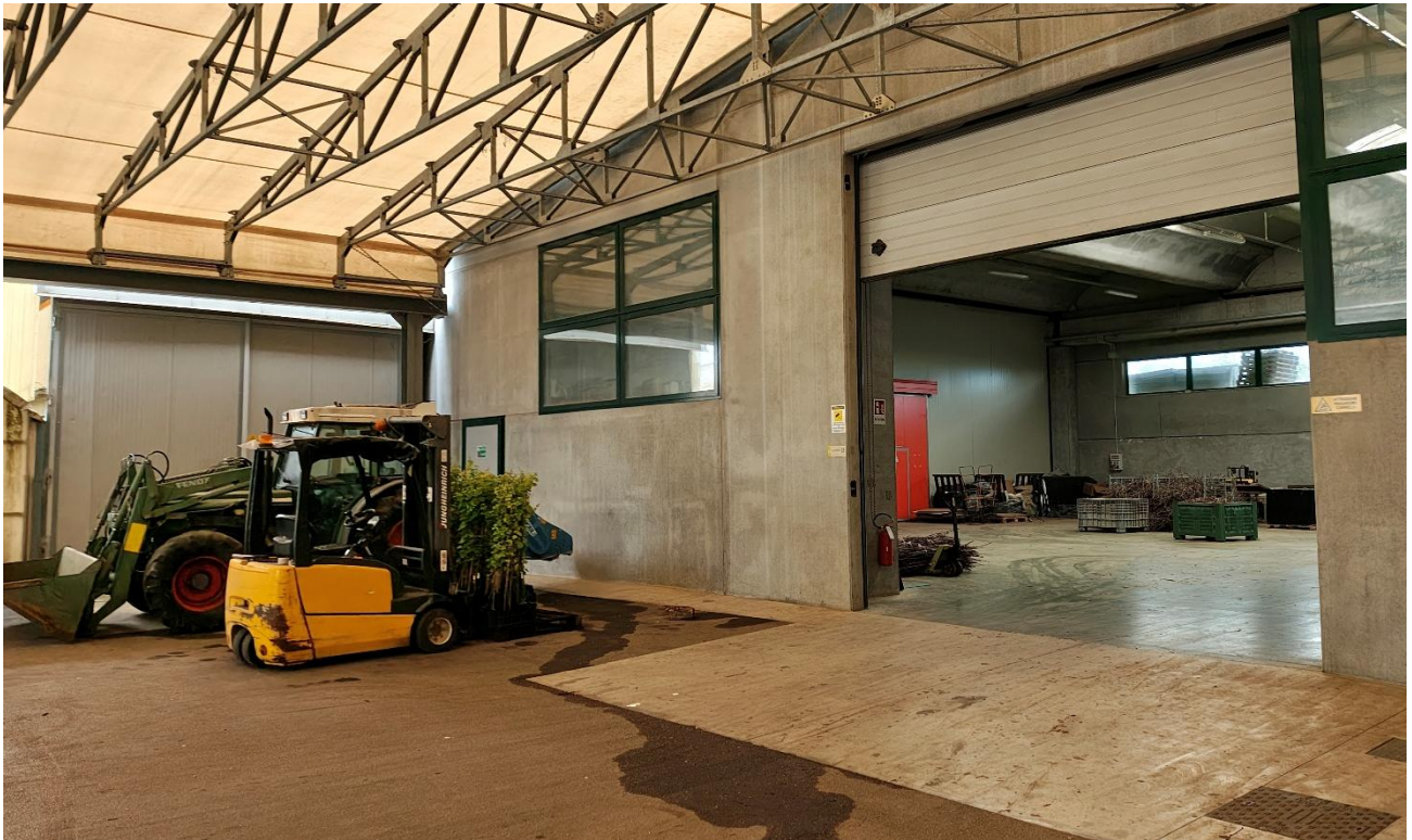
Foto n°67 – Lotto 1 – Comune di San Giorgio della Richinvelda (PN) – foglio 21 particelle 291 e 372 – Veduta, dalla tettoia che insiste sul mappale 291, del portone automatico di ingresso al capannone agricolo vivaistico identificato dal subalterno 1 della particella 372.
