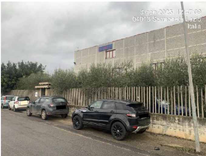
Facciata sud-ovest zona uffici
