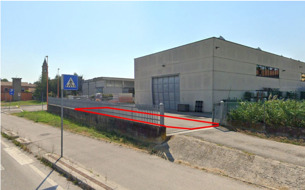
Foto 3- Vista dell'immobile esecutato da Via Olof Palme.
