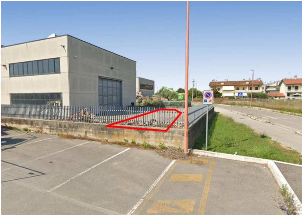
Foto 2- Vista dell'immobile esecutato dal parcheggio di Via Olof Palme.
