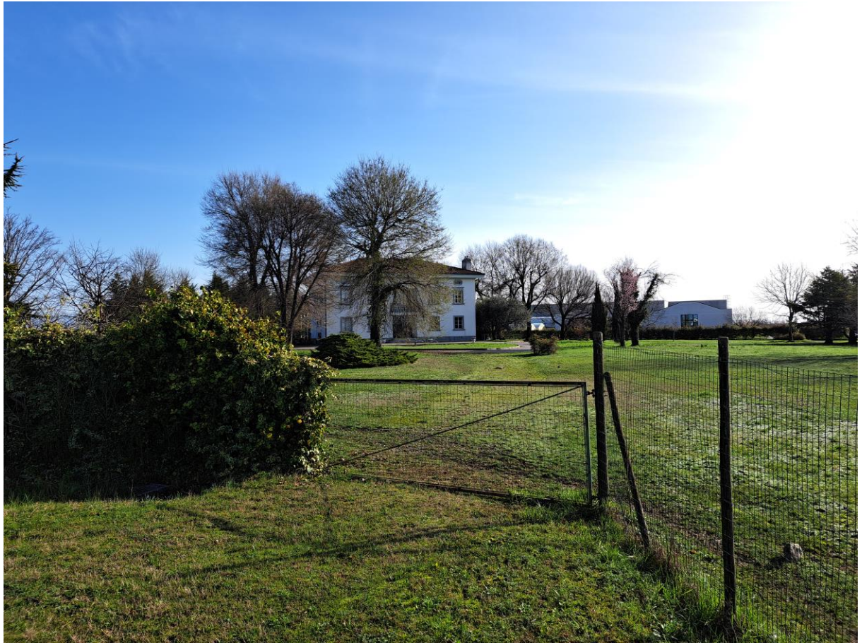
Foto n° 1 - Lotto 1 - Comune di S. Giorgio della Richinvelda (PN) - Frazione Rauscedo - Foglio 21 mappali 375 sub 1 - sub 2, 380, foglio 20 mappale 276 - Veduta generale, da Via P. Zorutti, del compendio pignorato; il cancello nella foto è un accesso secondario alla proprietà.
