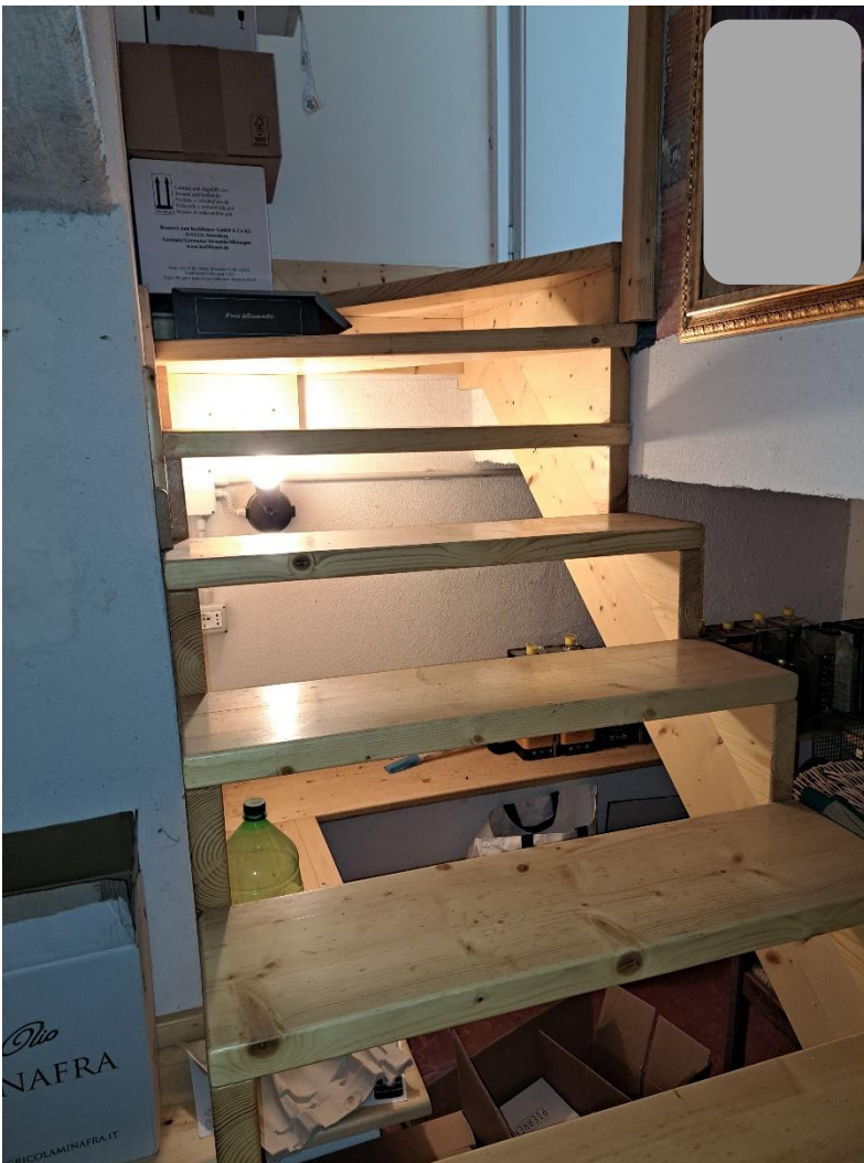
Foto n° 47 - Lotto 1 - Comune di S. Giorgio della Richinvelda (PN) - Frazione Rauscedo - Foglio 21 m.le 375 sub 2 - Veduta, dal piano interrato, della scala di accesso alla cantina; l'accesso avviene dalla sala riunioni.
