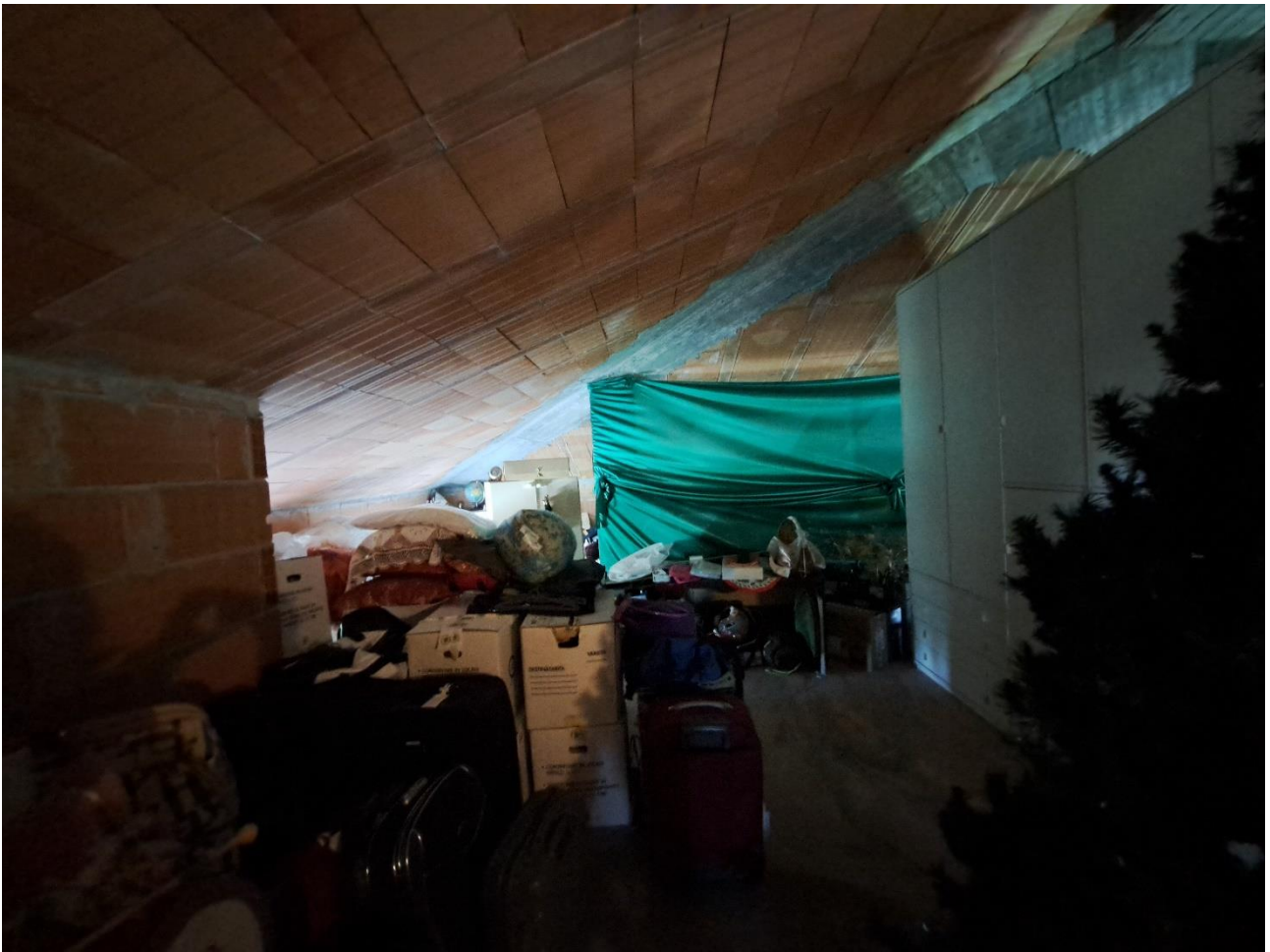
Foto n° 85 – Lotto 1 - Comune di S. Giorgio della Richinvelda (PN) – Frazione Rauscedo - Foglio 21 m.le 375 sub 1 – Piano secondo. Veduta di porzione nord-est della soffitta.
