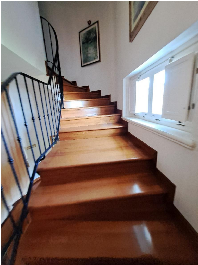
Foto n° 82 – Lotto 1 - Comune di S. Giorgio della Richinvelda (PN) – Frazione Rauscedo - Foglio 21 m.le 375 sub 1 – Piano primo. Particolare del vano scale che conduce al secondo piano.
