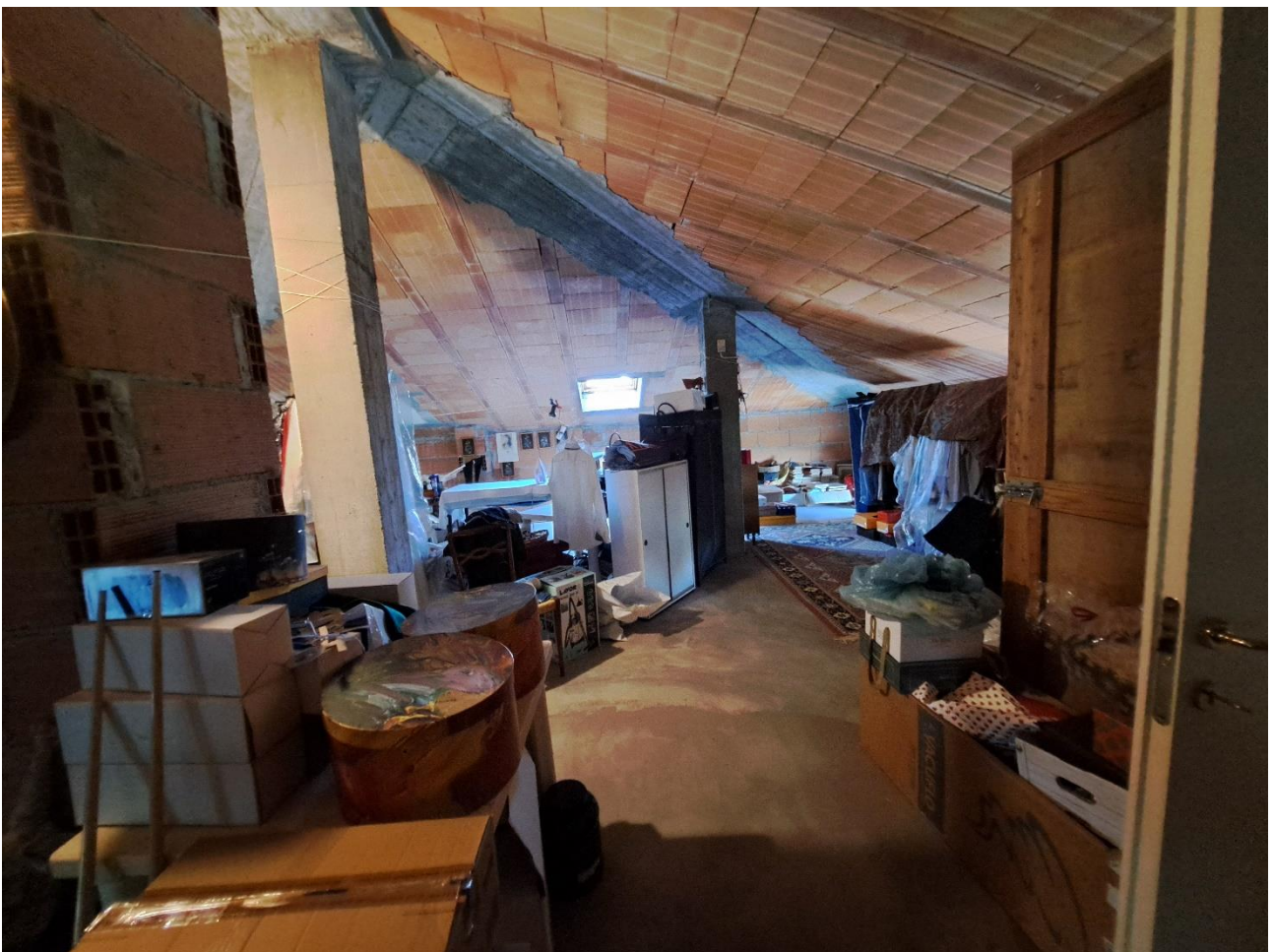
Foto n° 84 – Lotto 1 - Comune di S. Giorgio della Richinvelda (PN) – Frazione Rauscedo - Foglio 21 m.le 375 sub 1 – Piano secondo. Veduta della soffitta da posizione vicina alla porta d'accesso.
