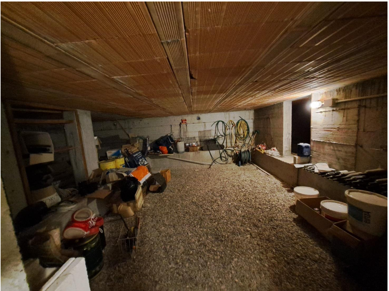
Foto n° 51 – Lotto 1 - Comune di S. Giorgio della Richinvelda (PN) – Frazione Rauscedo - Foglio 21 m.le 375 sub 2 – Particolare di un altro vano tombato, utilizzato come deposito di materiali vari.
