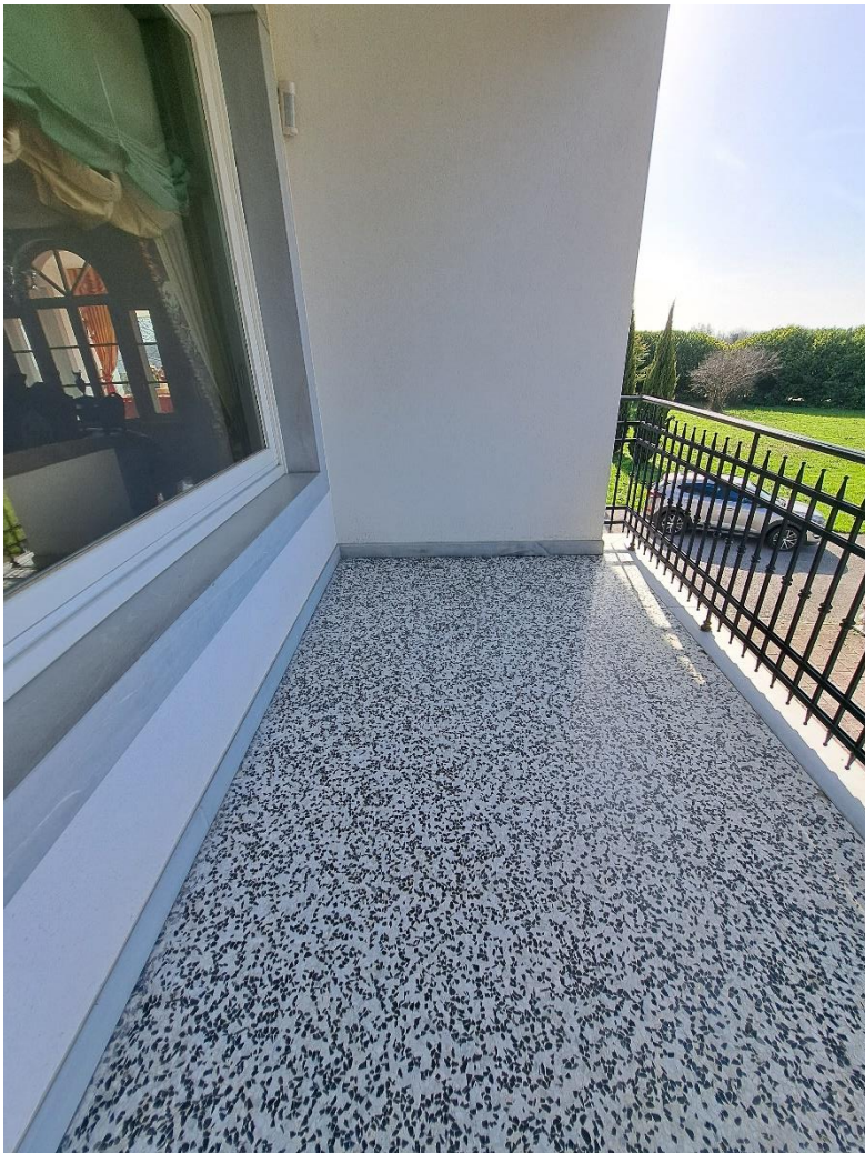
Foto n° 66 – Lotto 1 - Comune di S. Giorgio della Richinvelda (PN) – Frazione Rauscedo - Foglio 21 m.le 375 sub 1 – Piano primo. Particolare della terrazza di cui alla foto precedente.
