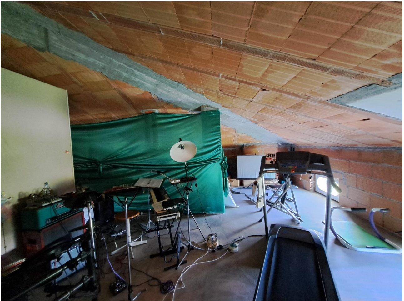
Foto n° 86 – Lotto 1 - Comune di S. Giorgio della Richinvelda (PN) – Frazione Rauscedo - Foglio 21 m.le 375 sub 1 – Piano secondo. Veduta di porzione sud-ovest della stessa soffitta.
