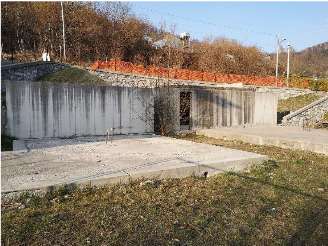
Foto 4 – Manufatti in cemento armato
