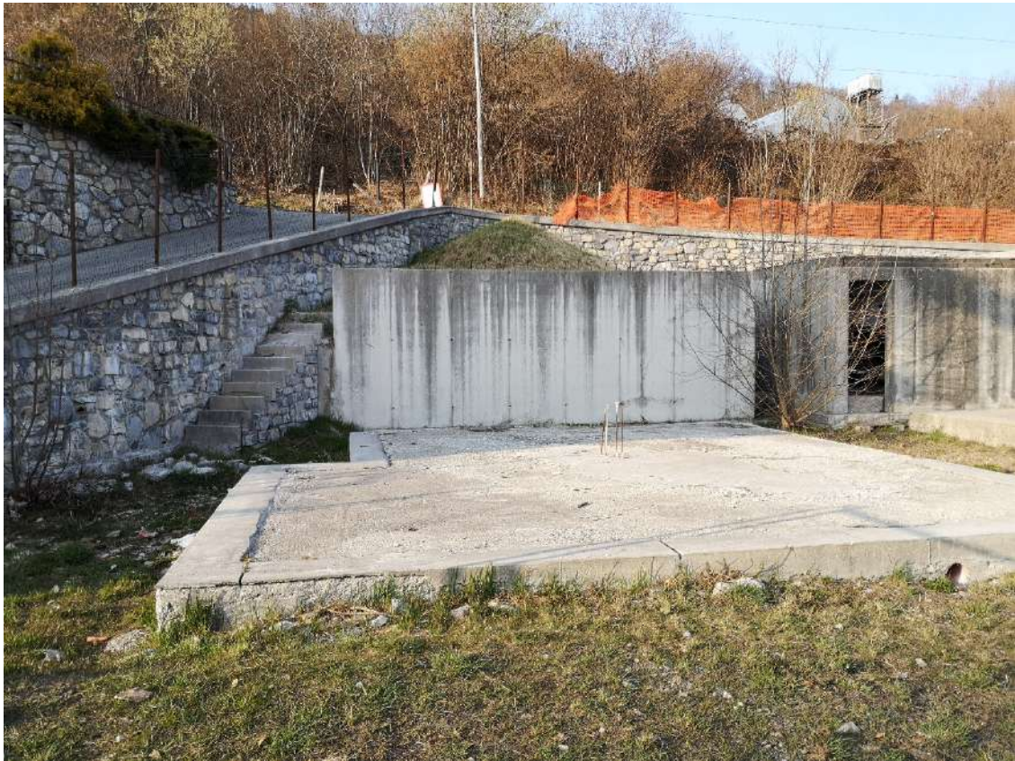
Foto 3 – Manufatti in cemento armato
