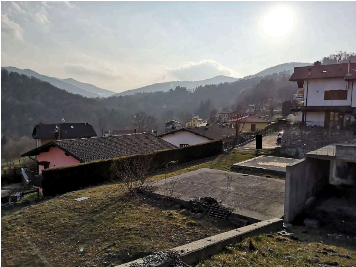
Foto 7 – Manufatti in cemento armato
