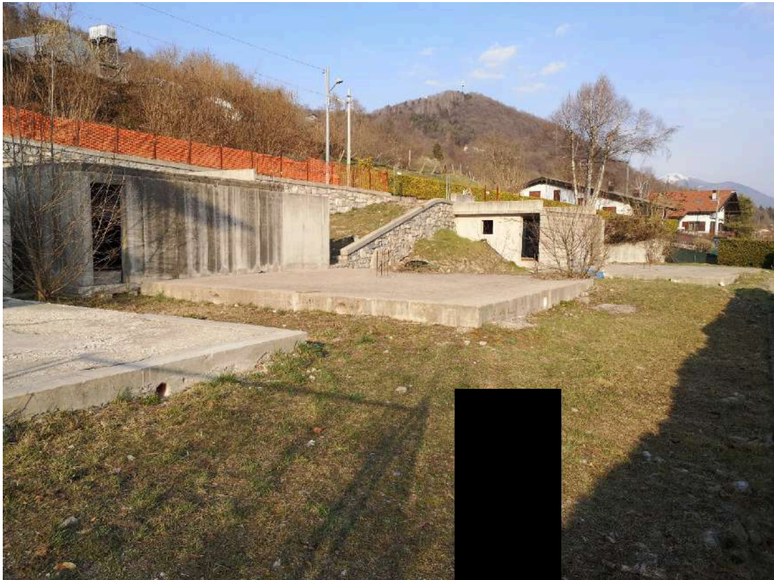
Foto 5 – Manufatti in cemento armato
