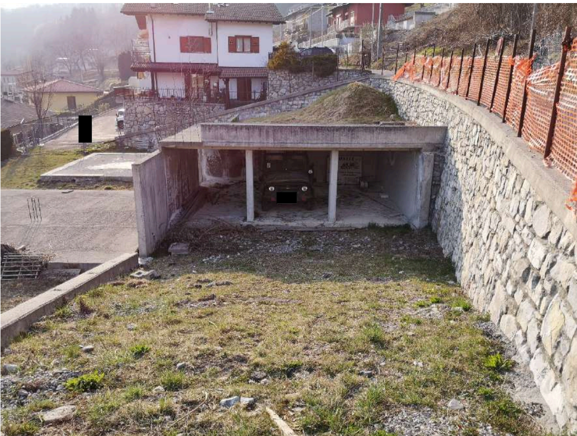
Foto 8 – Manufatti in cemento armato
