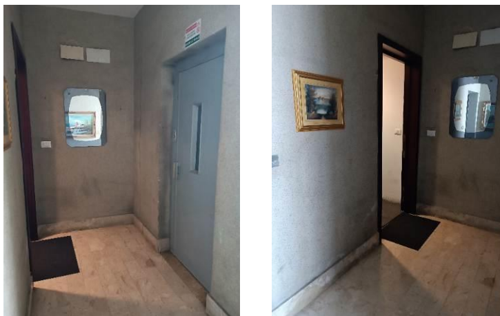
Figg. 59, 60 Pianerottolo d'ingresso.
