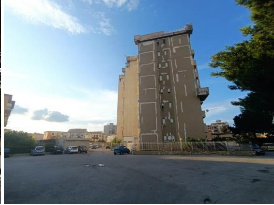
Fig. 8 Prospetto ovest e area condominiale.
