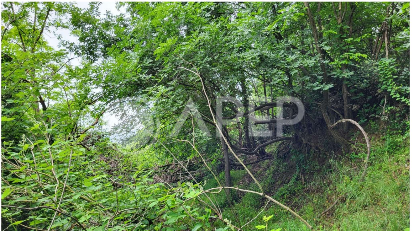
FOTO N .4 - INTERRUZIONE PER SMOTTAMENTI DEL PERCORSO
