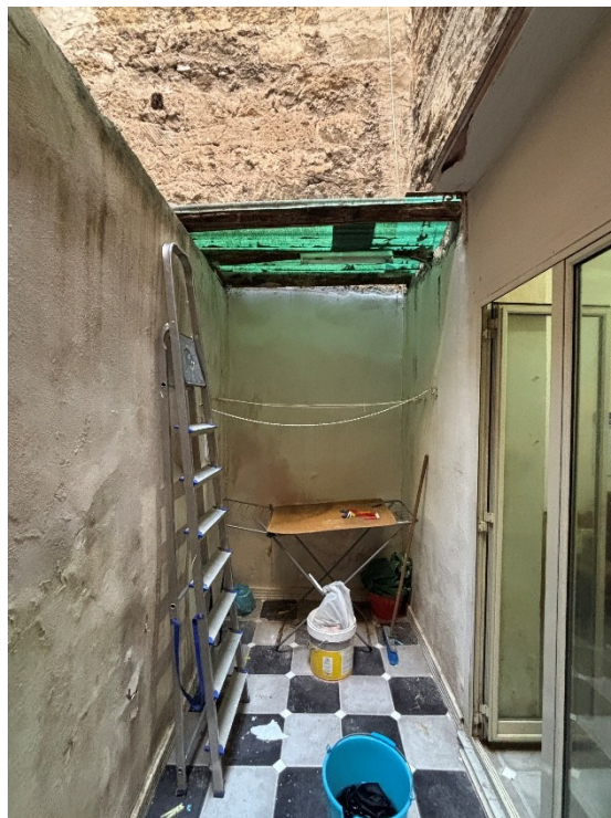
Foto n. 14 – Pozzo luce su retrospetto
