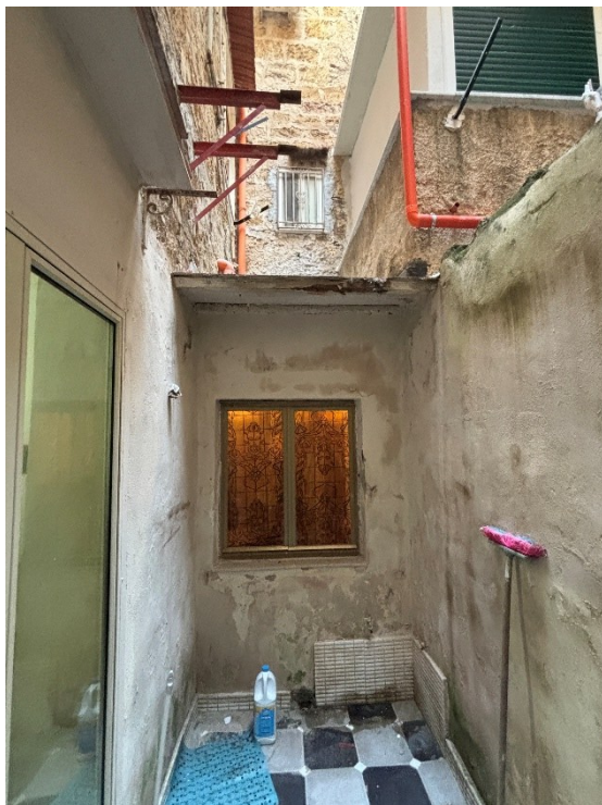
Foto n. 13 – Pozzo luce su retrospetto
