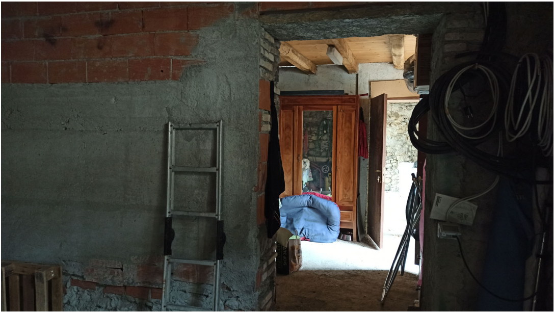
Stato dei locali - piano terra
