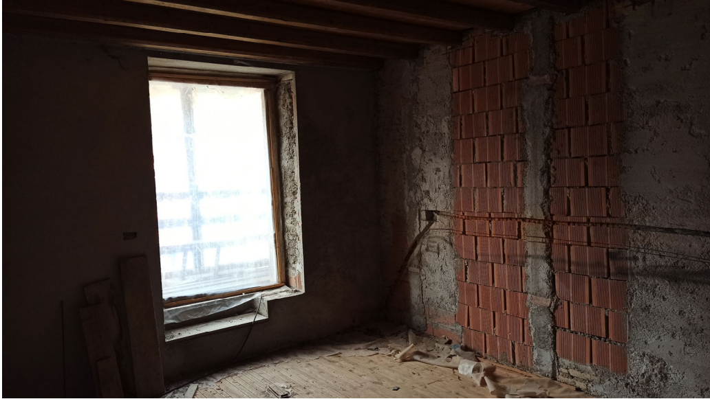
Stato dei locali – piano primo
