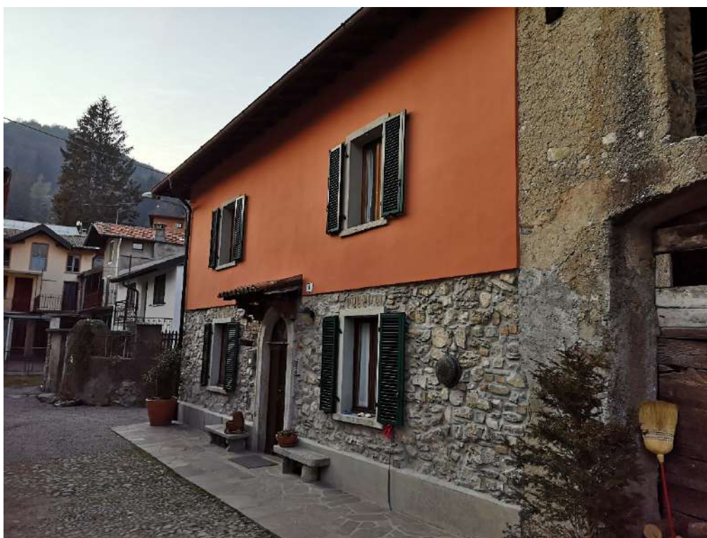
Foto 2 – Prospetto su corte
