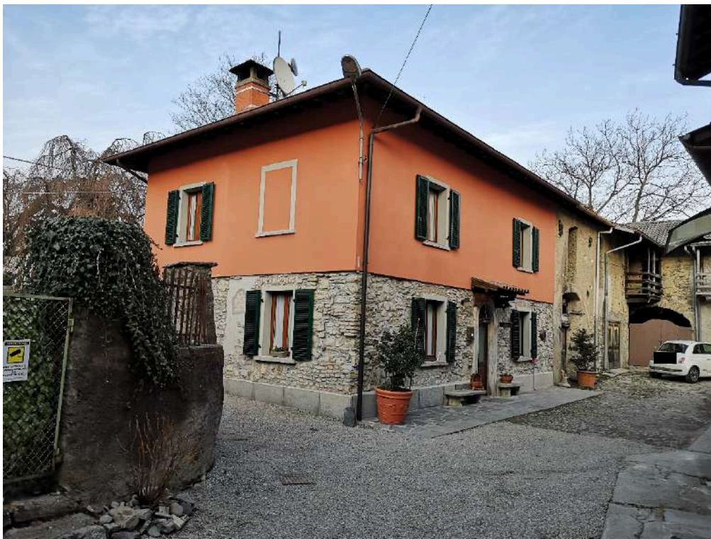
Foto 1 – Prospetto su corte
