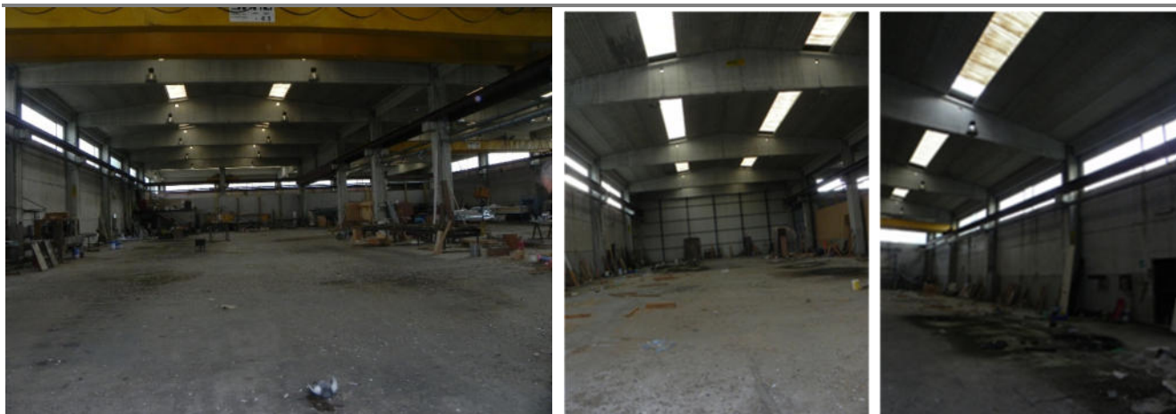
Il capannone posto al piano terra (corpo B) (part.630 sub 1, part.630 sub 2 e part.630 sub 3)
