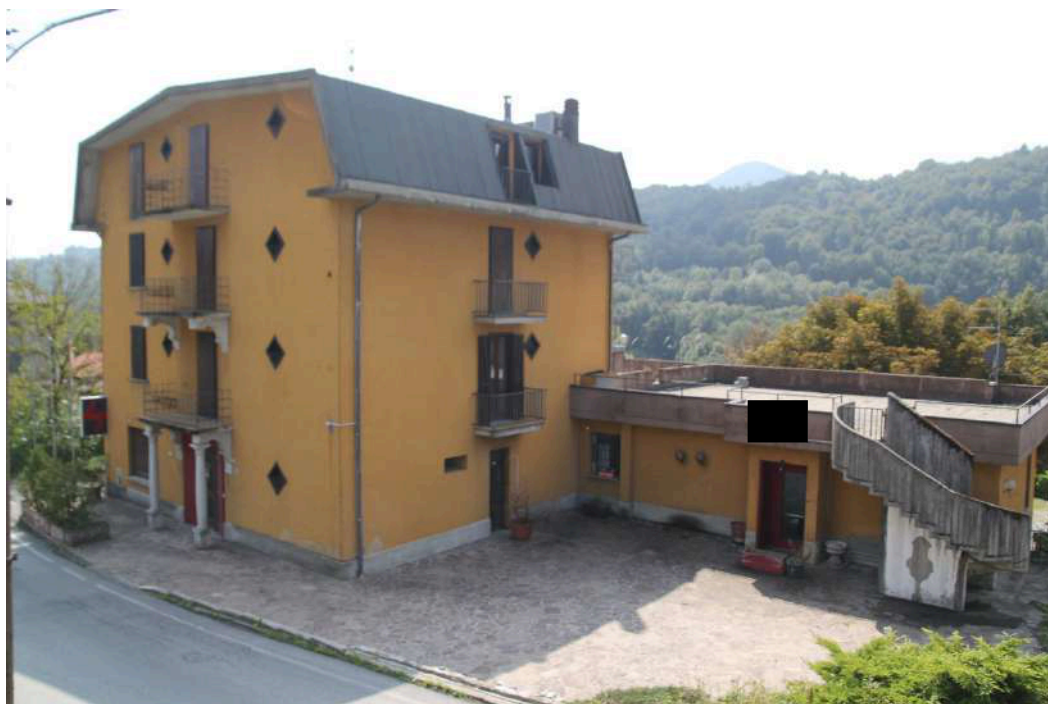
Foto 2 – Vista esterna complessiva da via Provinciale
