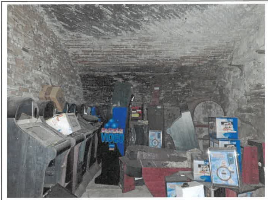
Foto n. 2 – Vista interna - Locale 1
