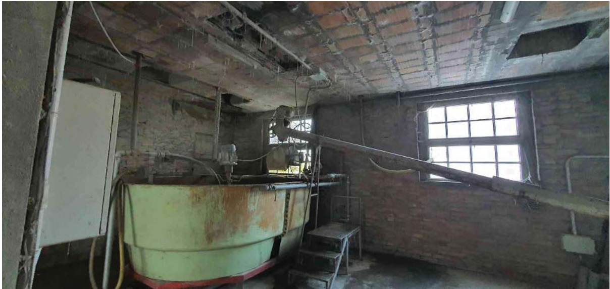
dettaglio solaio interpiano
