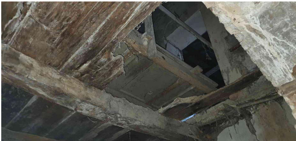
dettaglio solaio interpiano
