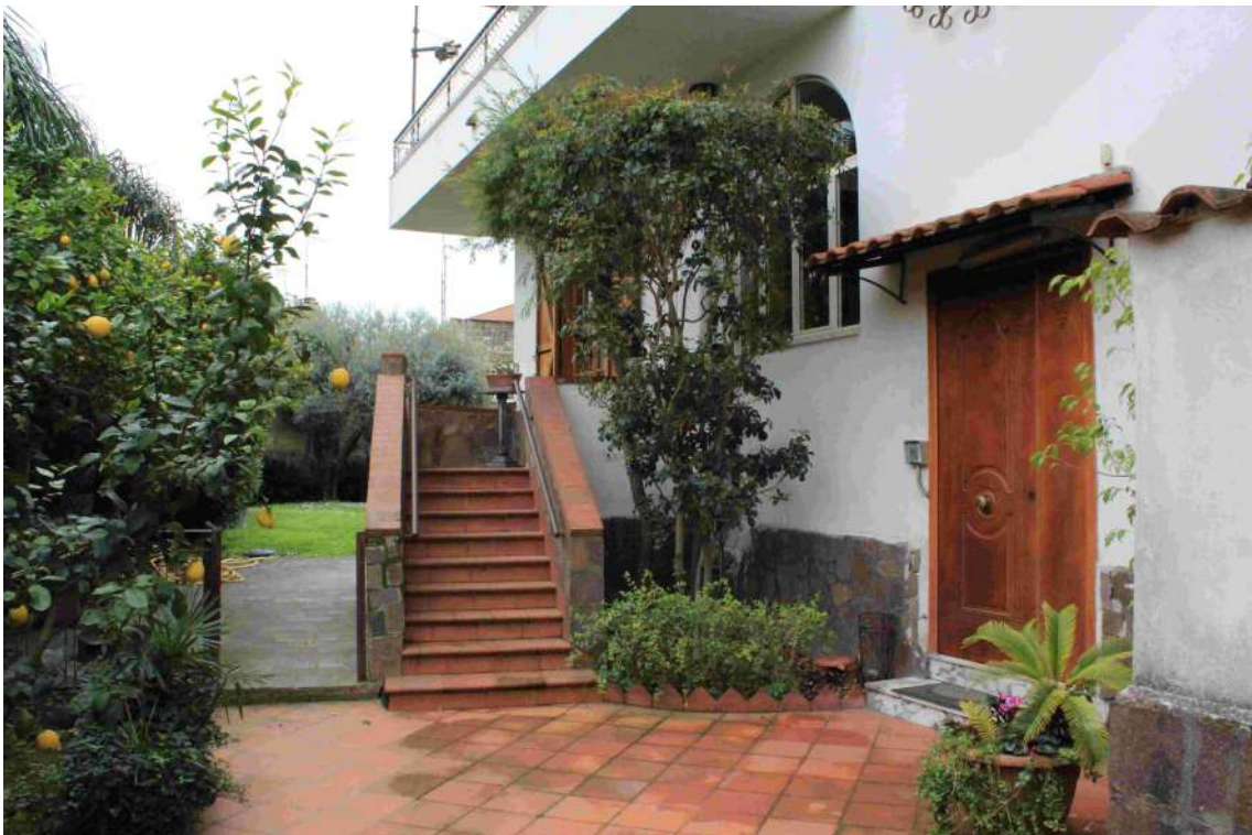
Foto 14: sulla dx portone di accesso al vano scala, posto sul lato nord del villino.
