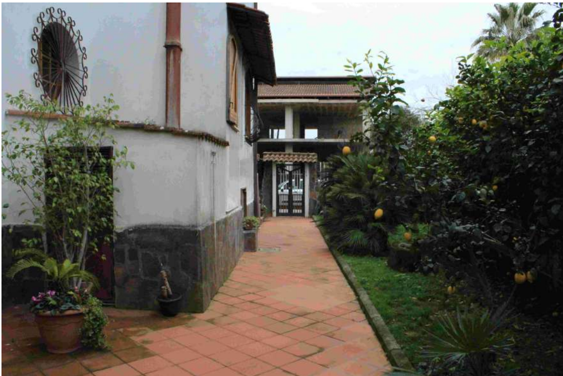
Foto 12: viale pedonale e pavimentato di accesso al villino, con giardino.
