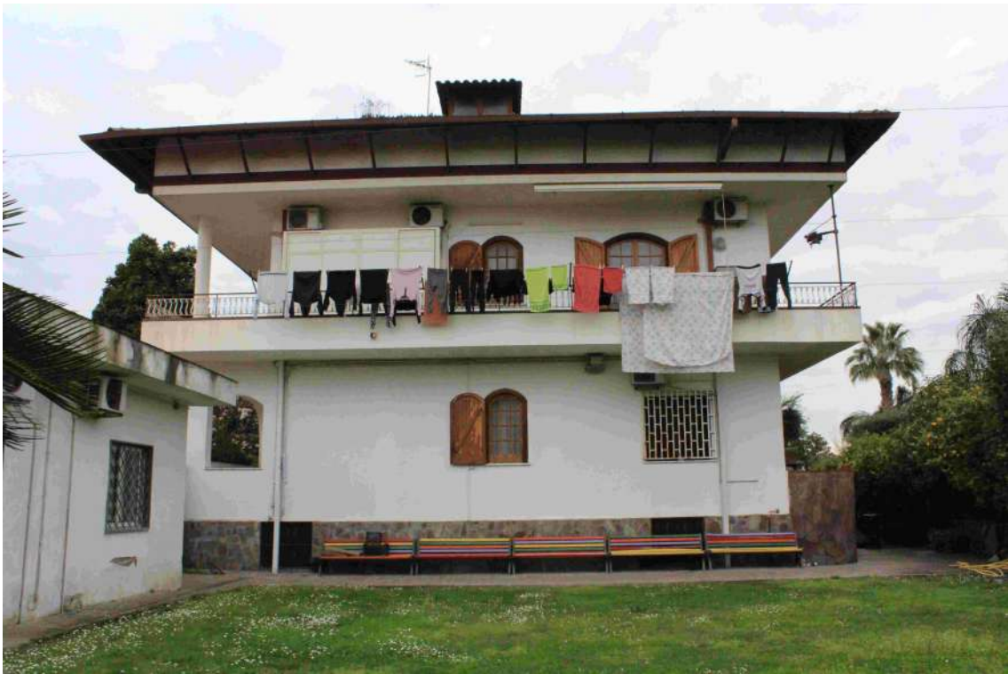
Foto 11: prospetto est del villino, di due piani f.t. più sottotetto destinato a deposito.
