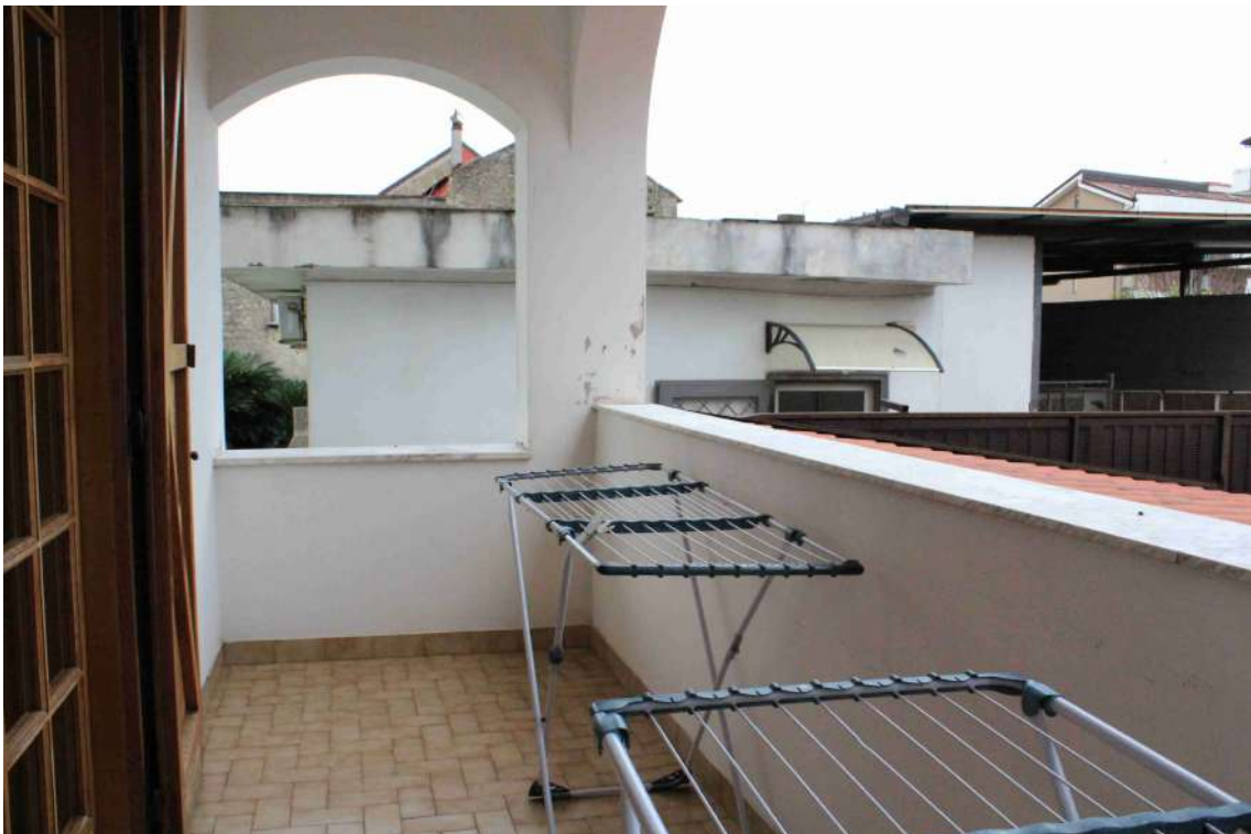
Foto 26: balcone della camera da letto, posto sul prospetto esposto a sud.
