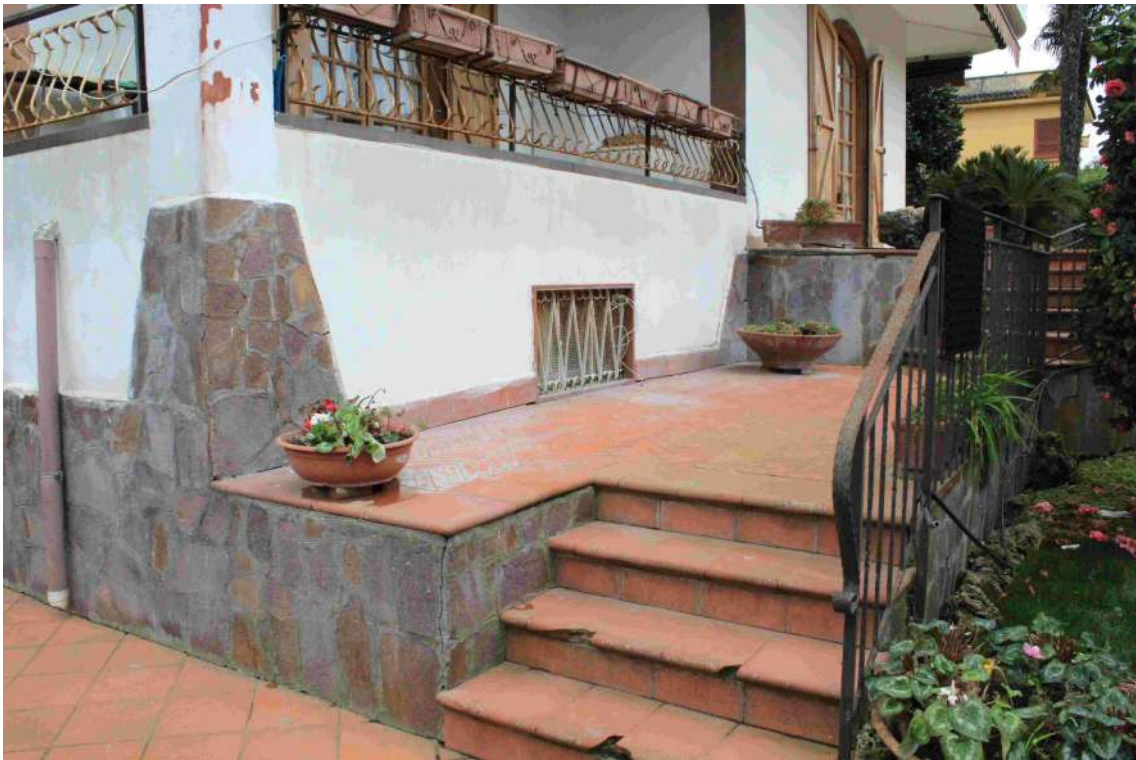
Foto 13: accesso all'abitazione del piano rialzato, posto sul prospetto esposto ad ovest.
