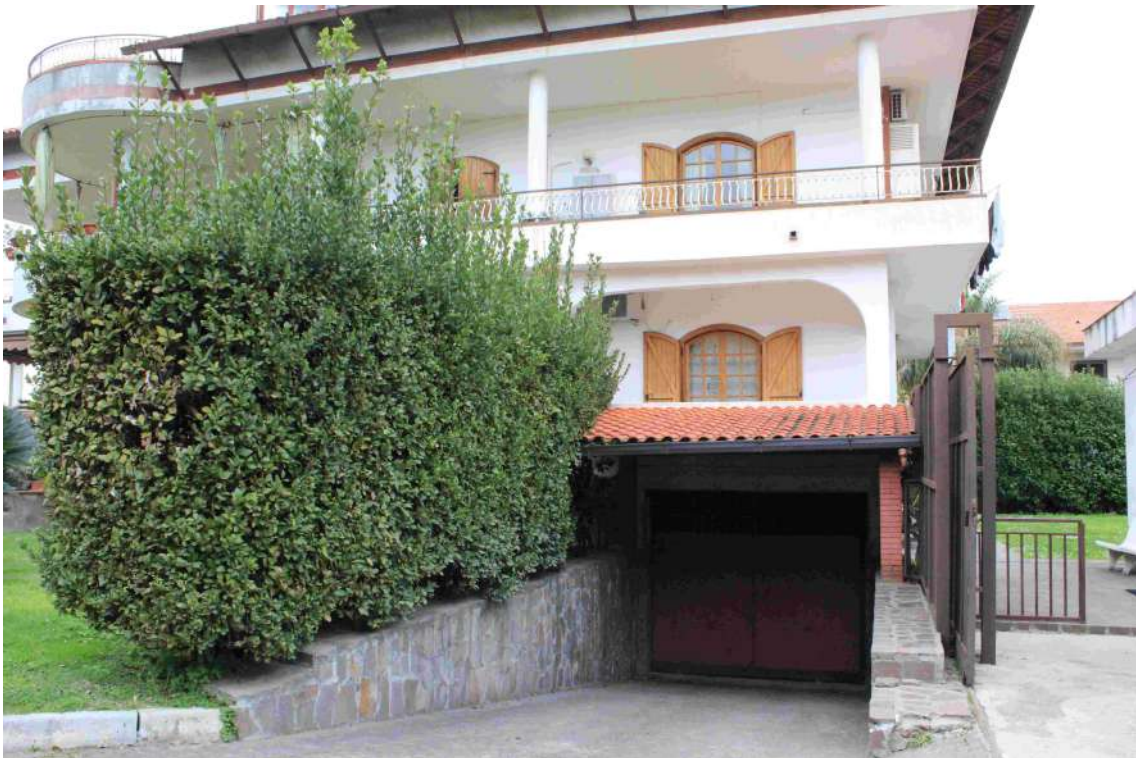
Foto 8: rampa carrabile che conduce all'autorimessa al piano seminterrato.
