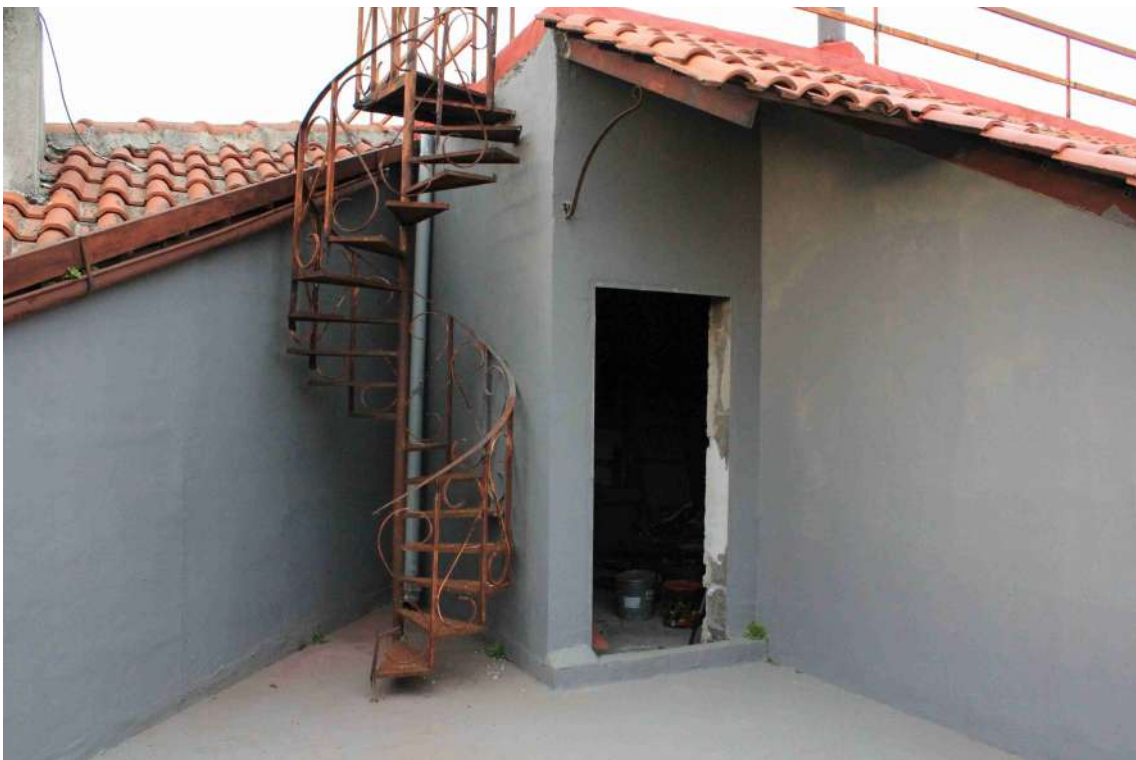
Foto 54: terrazza al secondo piano esposta a sud, con scala in ferro verso la copertura.
