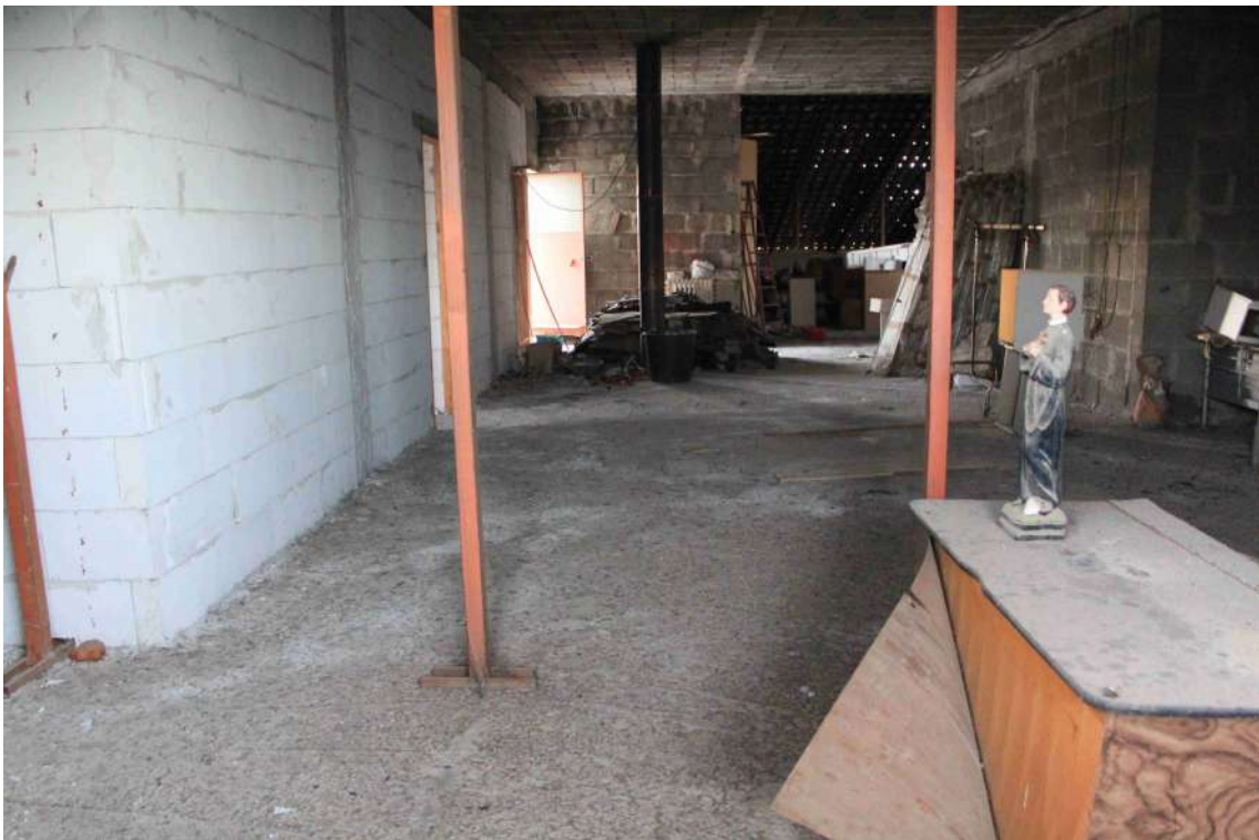
Foto 52: ambiente con copertura piana di altezza interna di 3,50 m.
