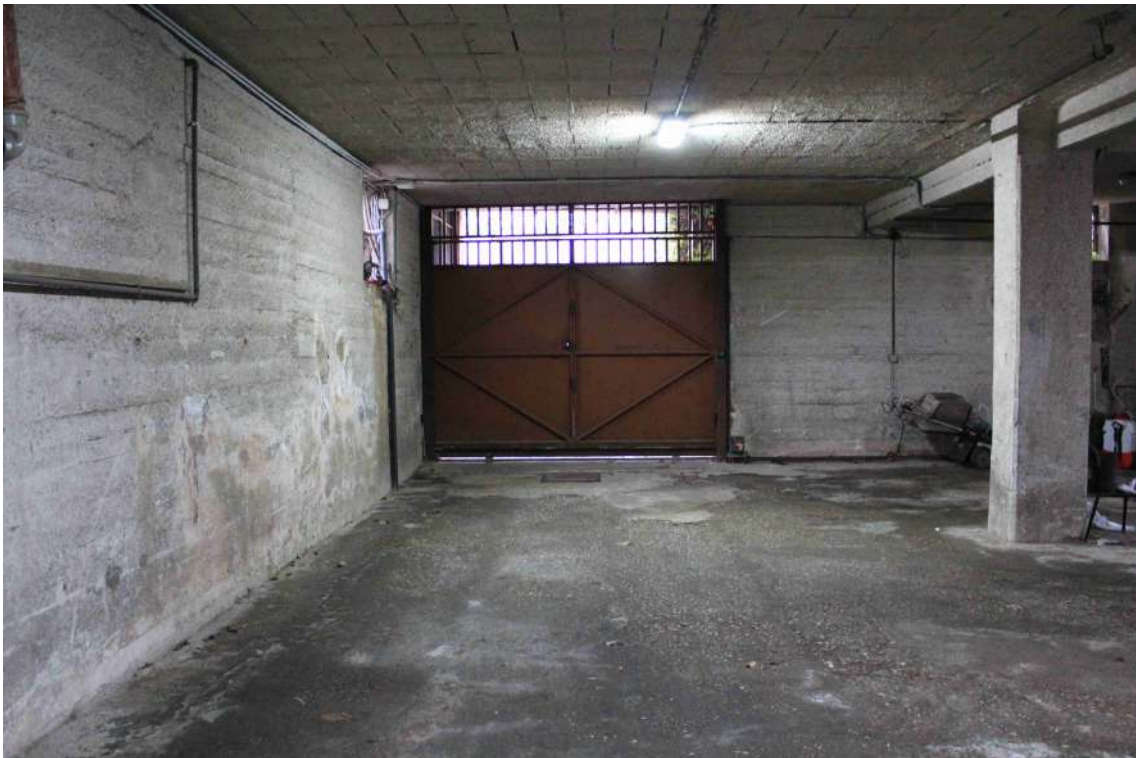
Foto 55: cancello in ferro di accesso all'autorimessa al piano seminterrato (sub. 4).
