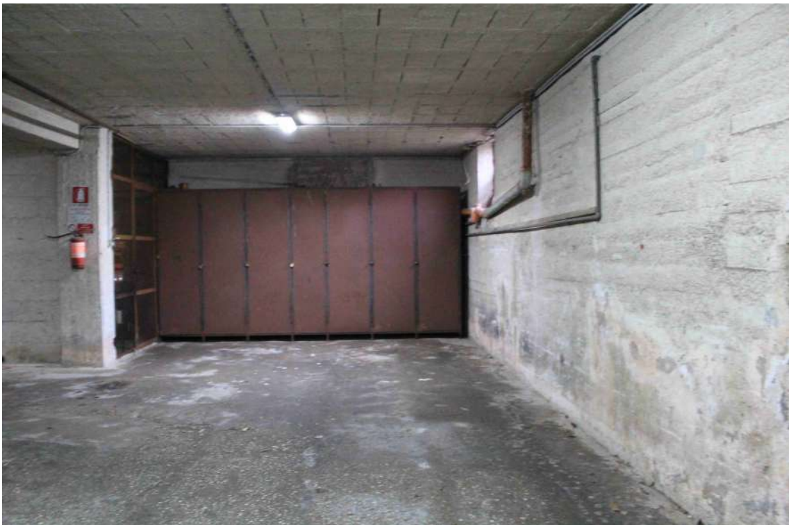
Foto 56: ambiente unico dell'autorimessa, allo stato grezzo.
