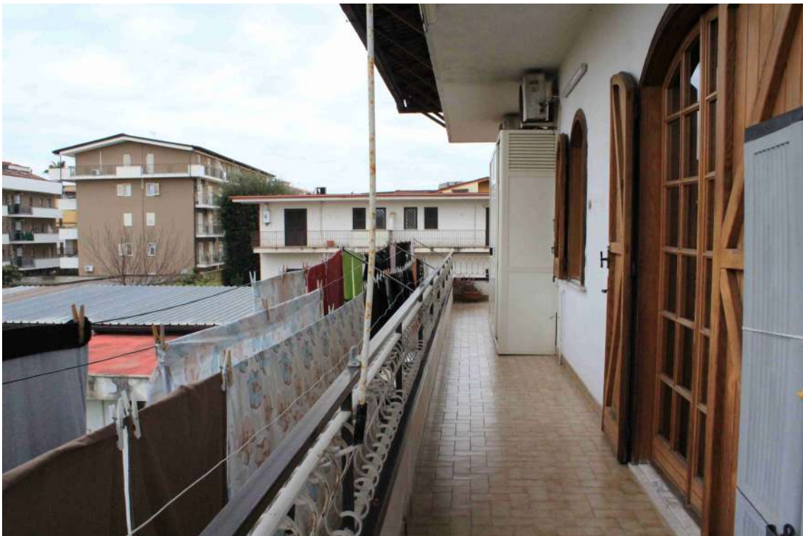
Foto 48: lato del balcone esposto verso l'interno della proprietà, ad est.
