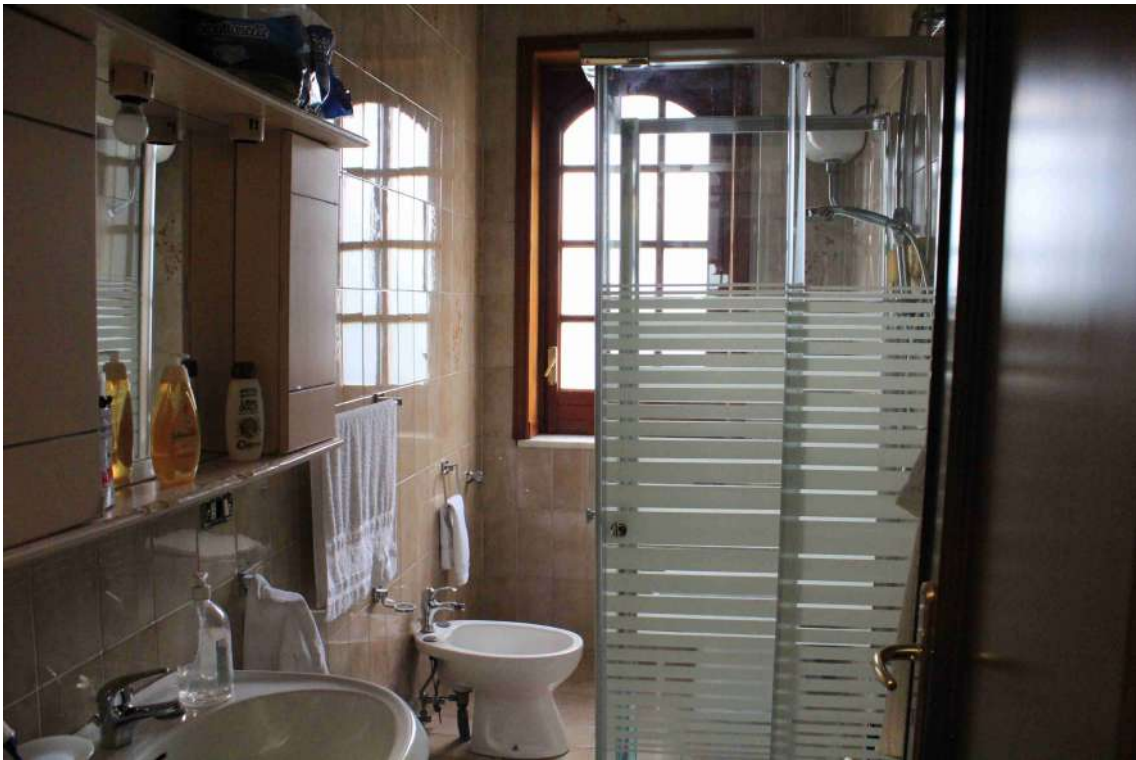
Foto 23: bagno di servizio, con accesso dal disimpegno collegato al tinello.
