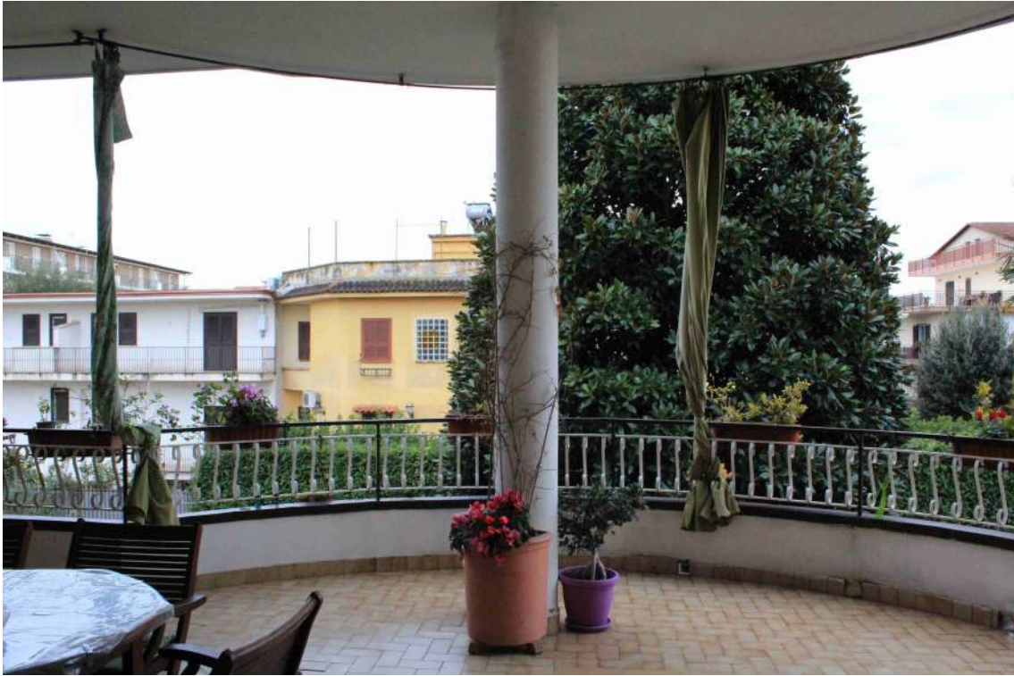
Foto 45: balcone semicircolare posto sul prospetto principale della villa.
