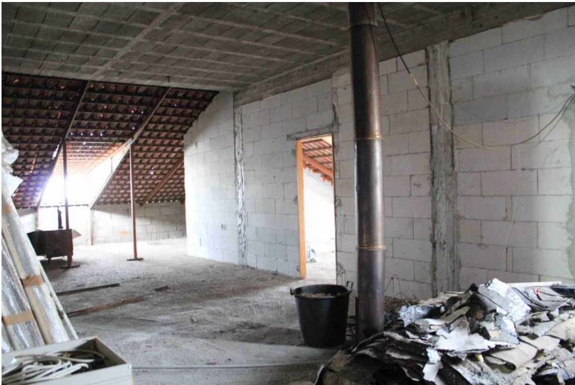
Foto 51: deposito al secondo piano della villa (sub. 3), allo stato grezzo.
