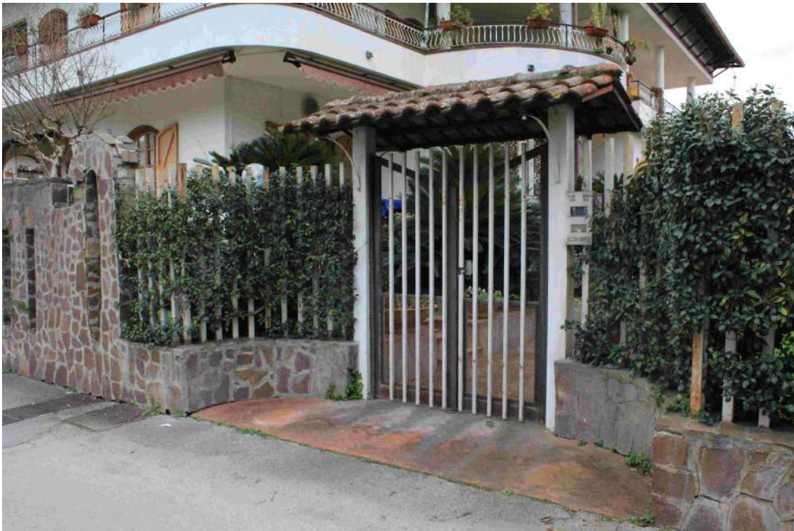
Foto 5: secondo cancello pedonale di accesso al villino, in vico Palazzo.
