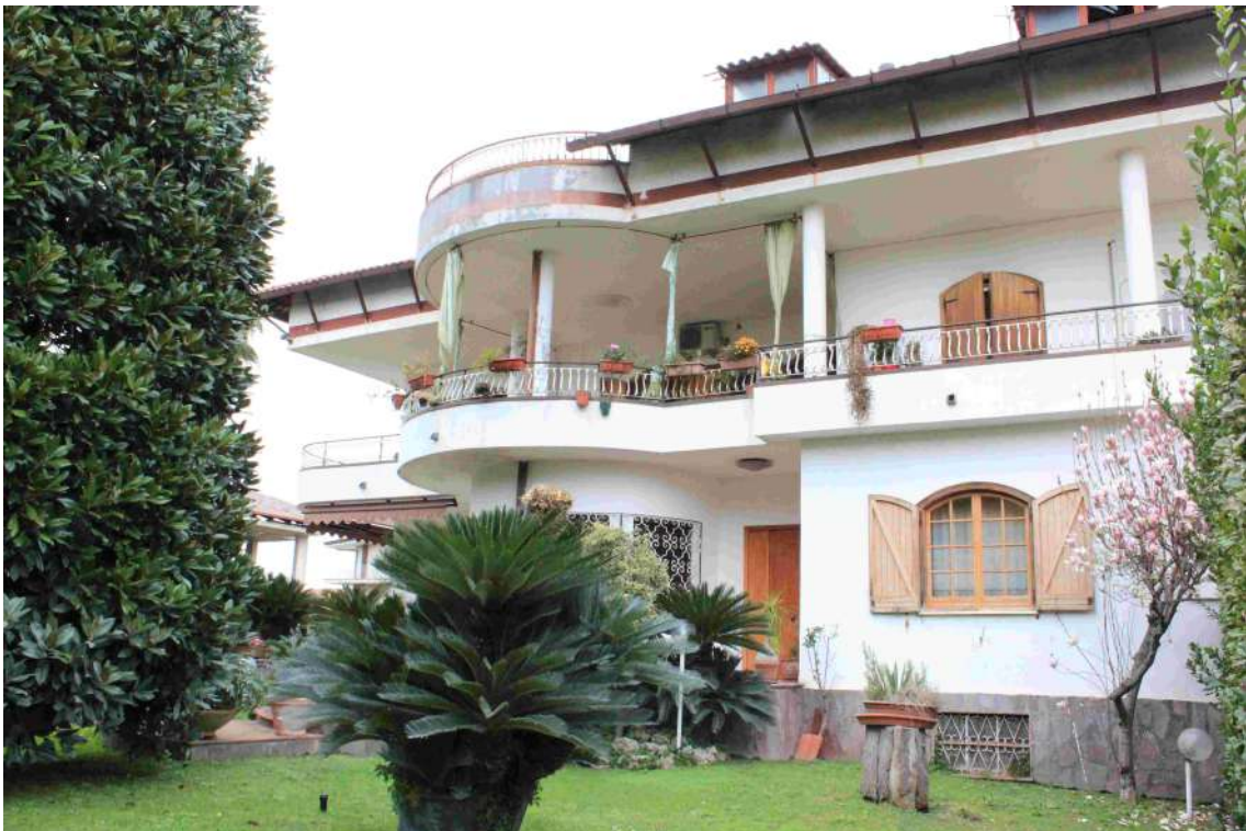
Foto 10: prospetto principale del villino, esposto a sud con giardino antistante.
