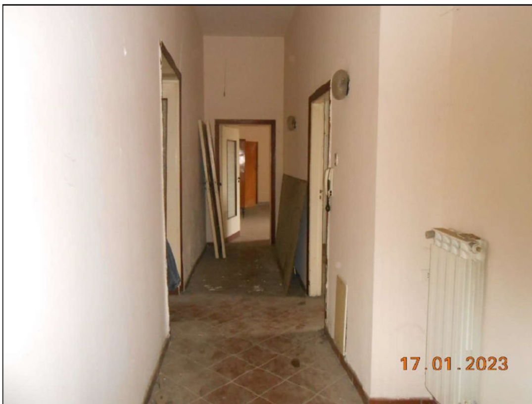
FOTO N. 44 Vista interna del piano primo.
