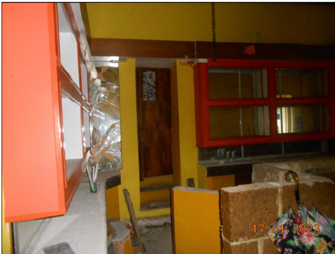
FOTO N. 21 Vista interna del piano terra, prima adibita a bar.
