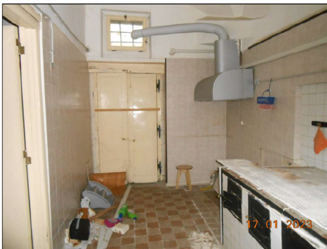
FOTO N. 28 Vista interna del piano terra.
