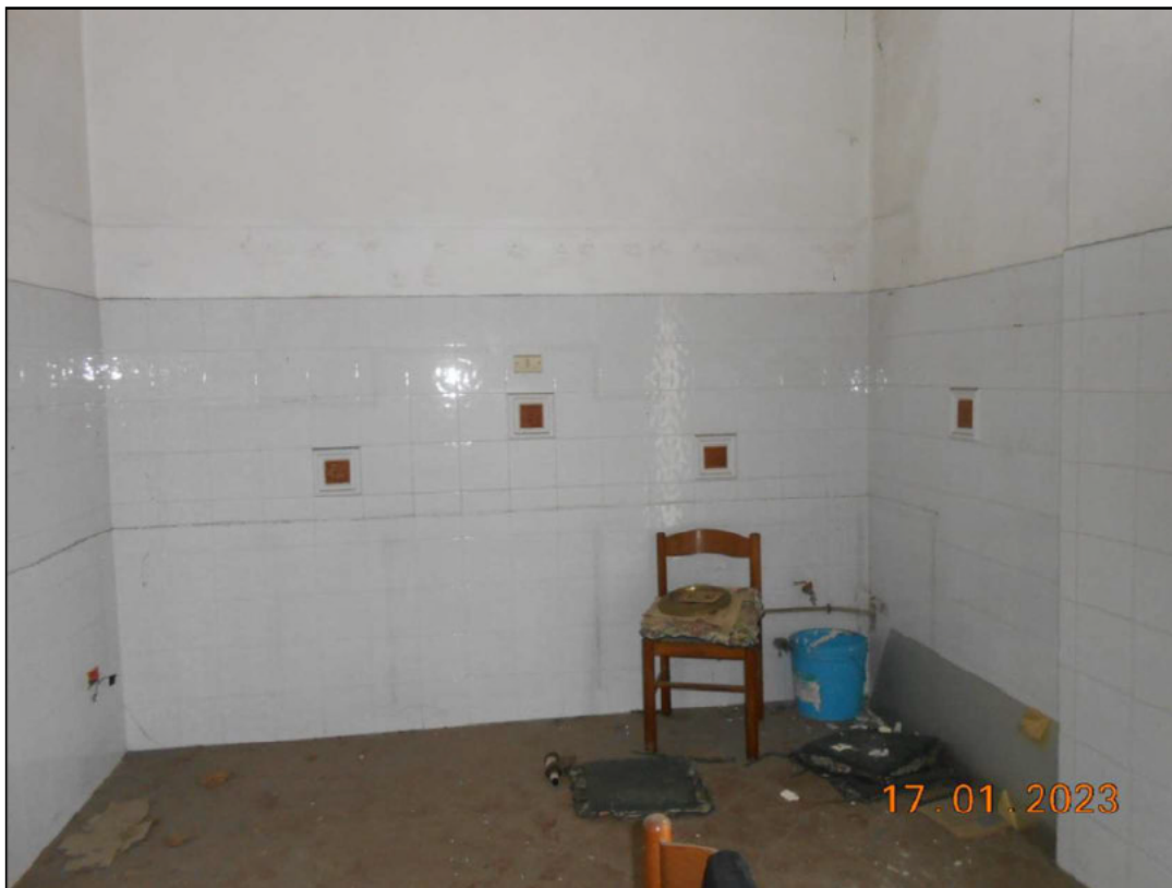
FOTO N. 47 Vista interna del piano primo.
