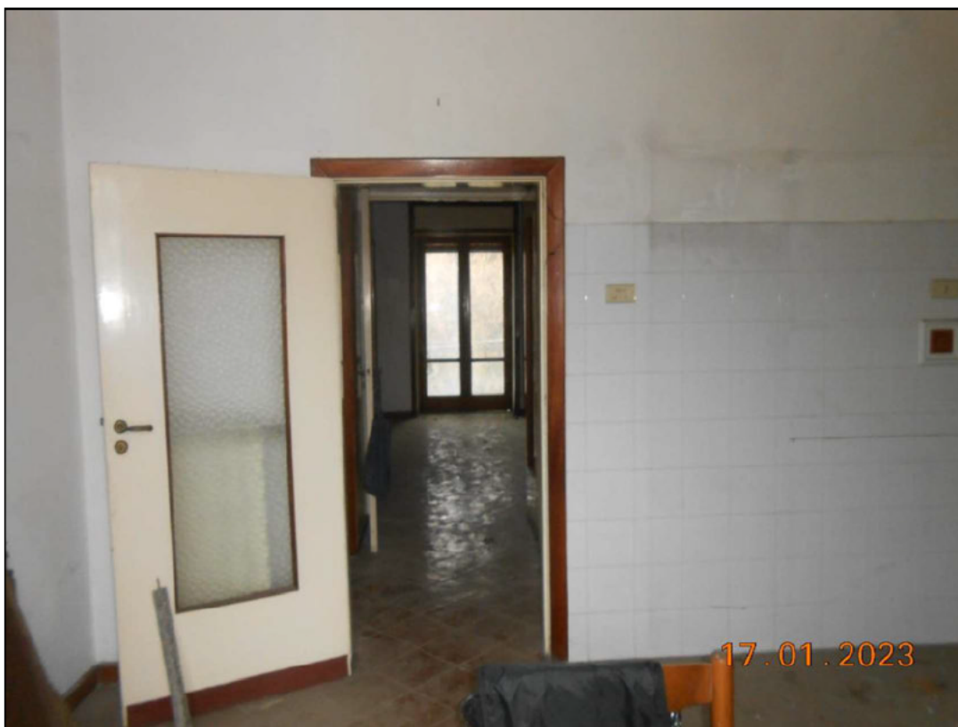
FOTO N. 48 Vista interna del piano primo.
