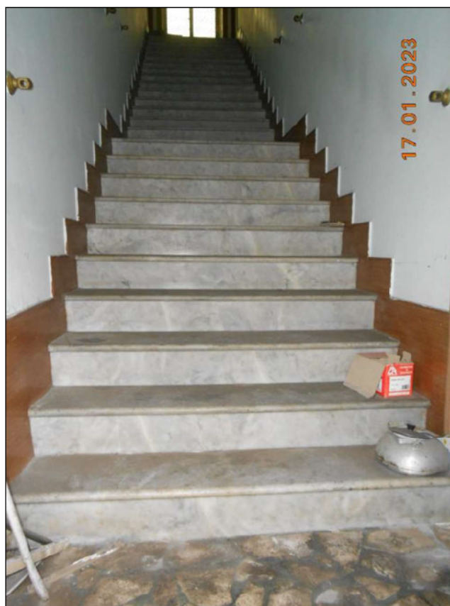
FOTO N. 38 Vista scala interna di accesso al piano primo.
