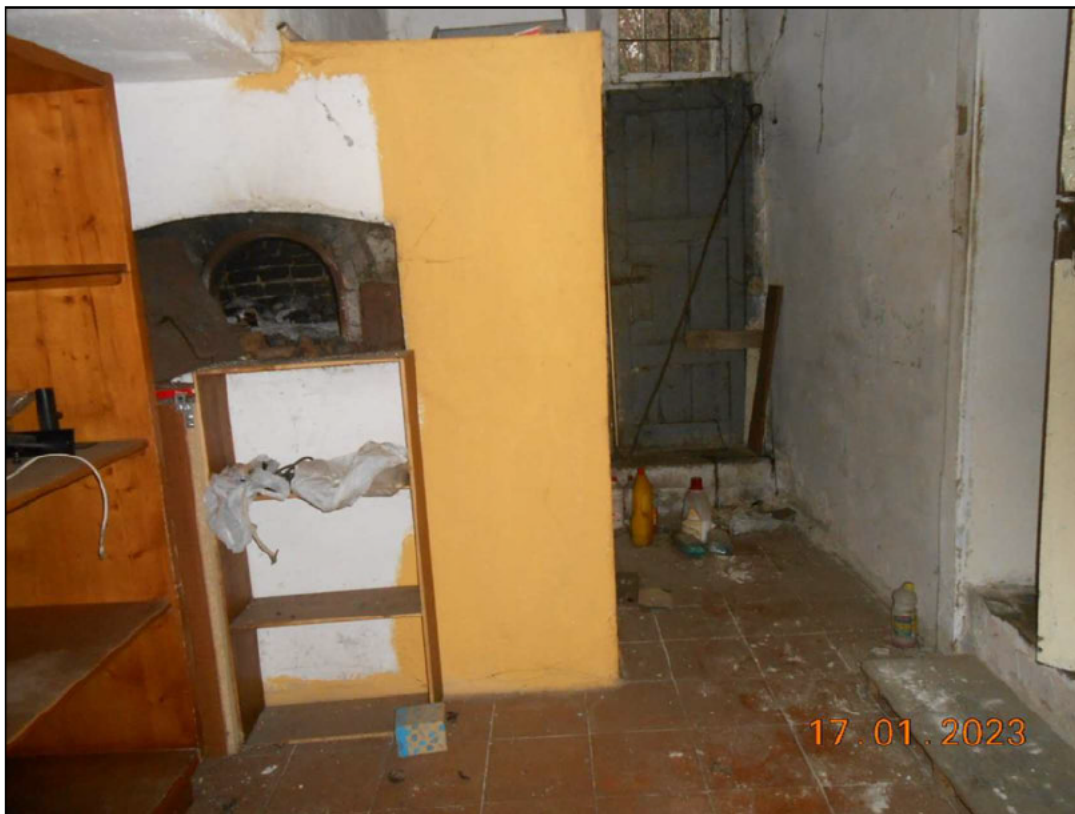
FOTO N. 31 Vista interna del piano terra.
