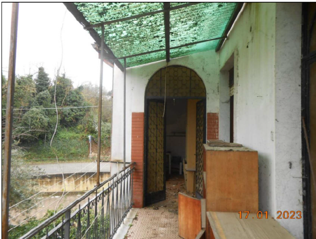
FOTO N. 55 Vista del balcone e lavanderia al piano primo.
