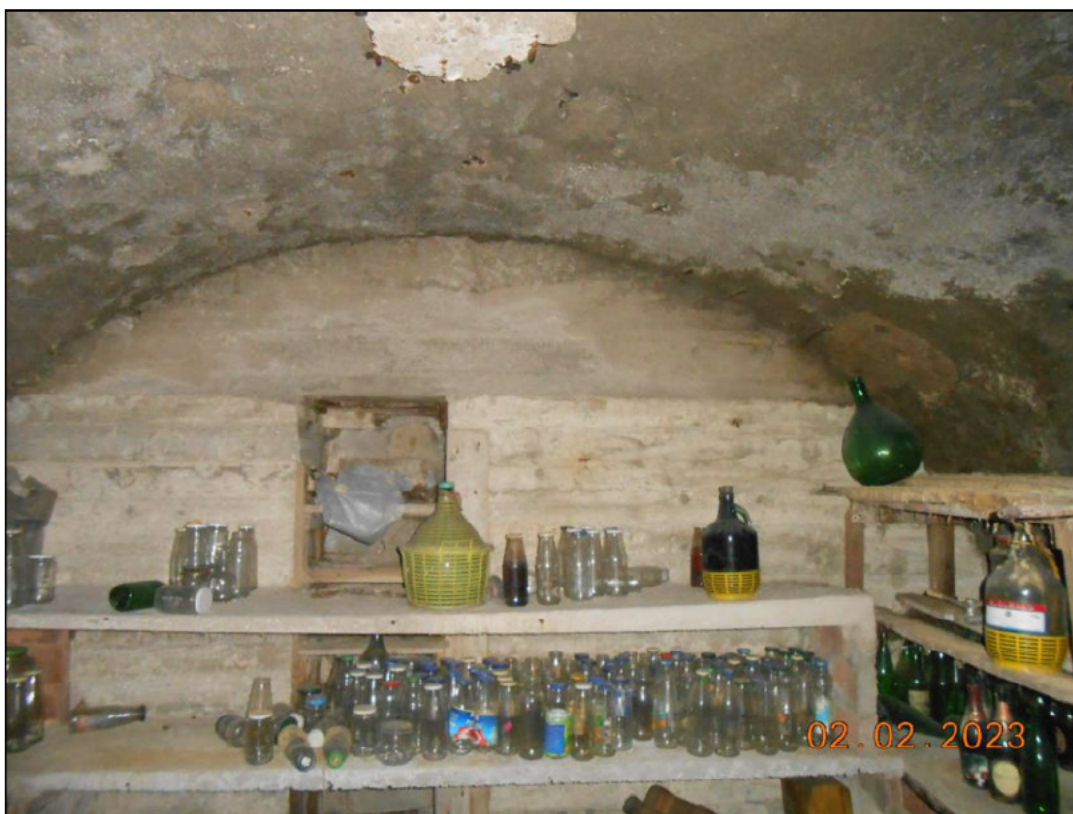
FOTO N. 11 Vista interna del piano interrato dell'immobile pignorato.
