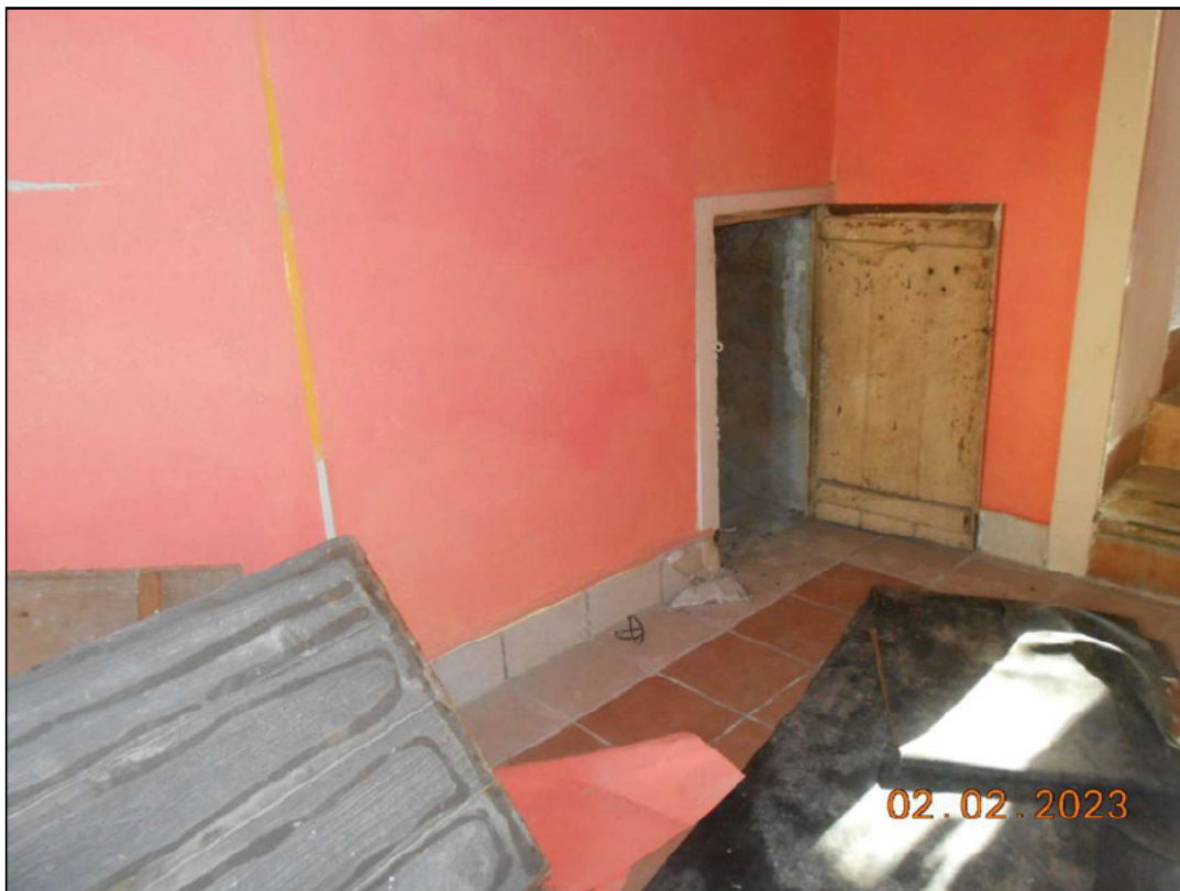
FOTO N. 15 Vista porta al piano terra, di accesso all'altro locale interrato.
