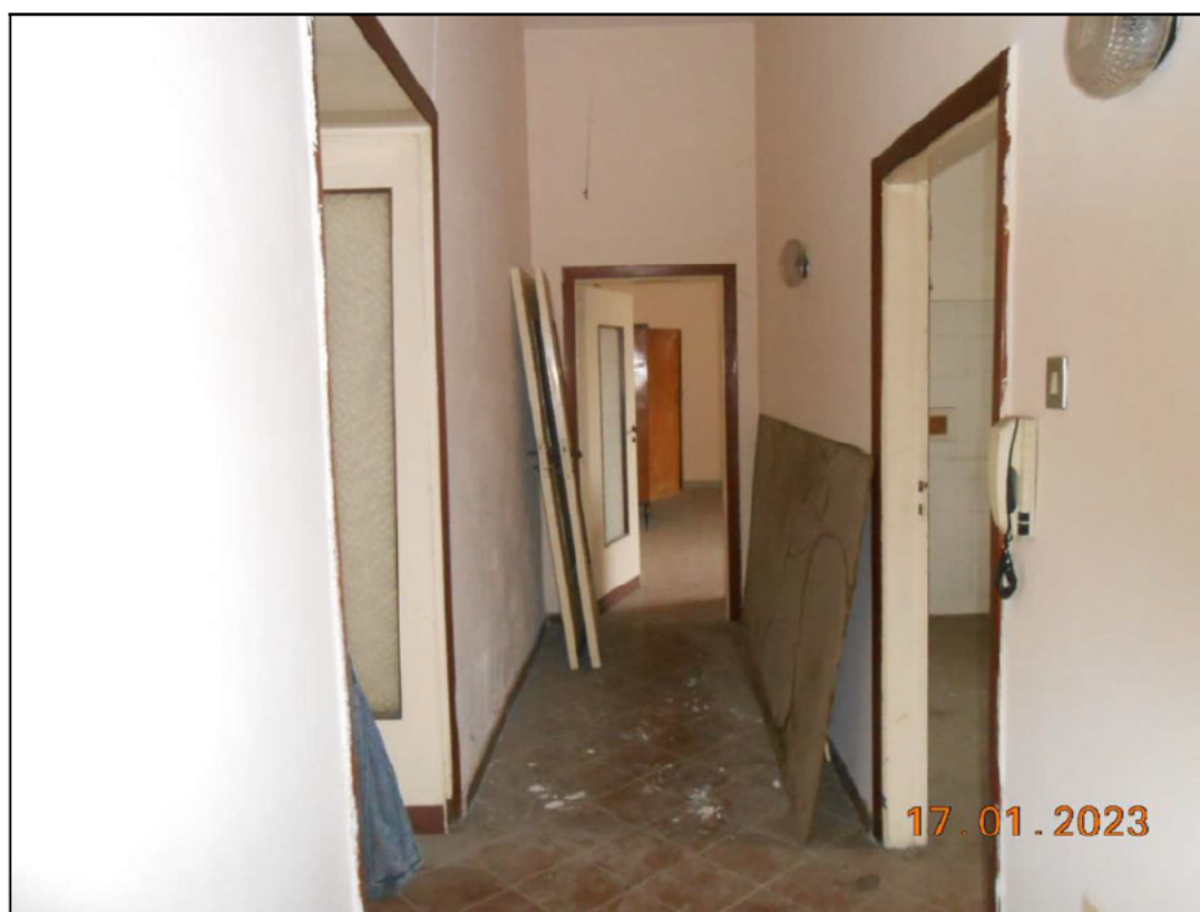
FOTO N. 46 Vista interna del piano primo.
