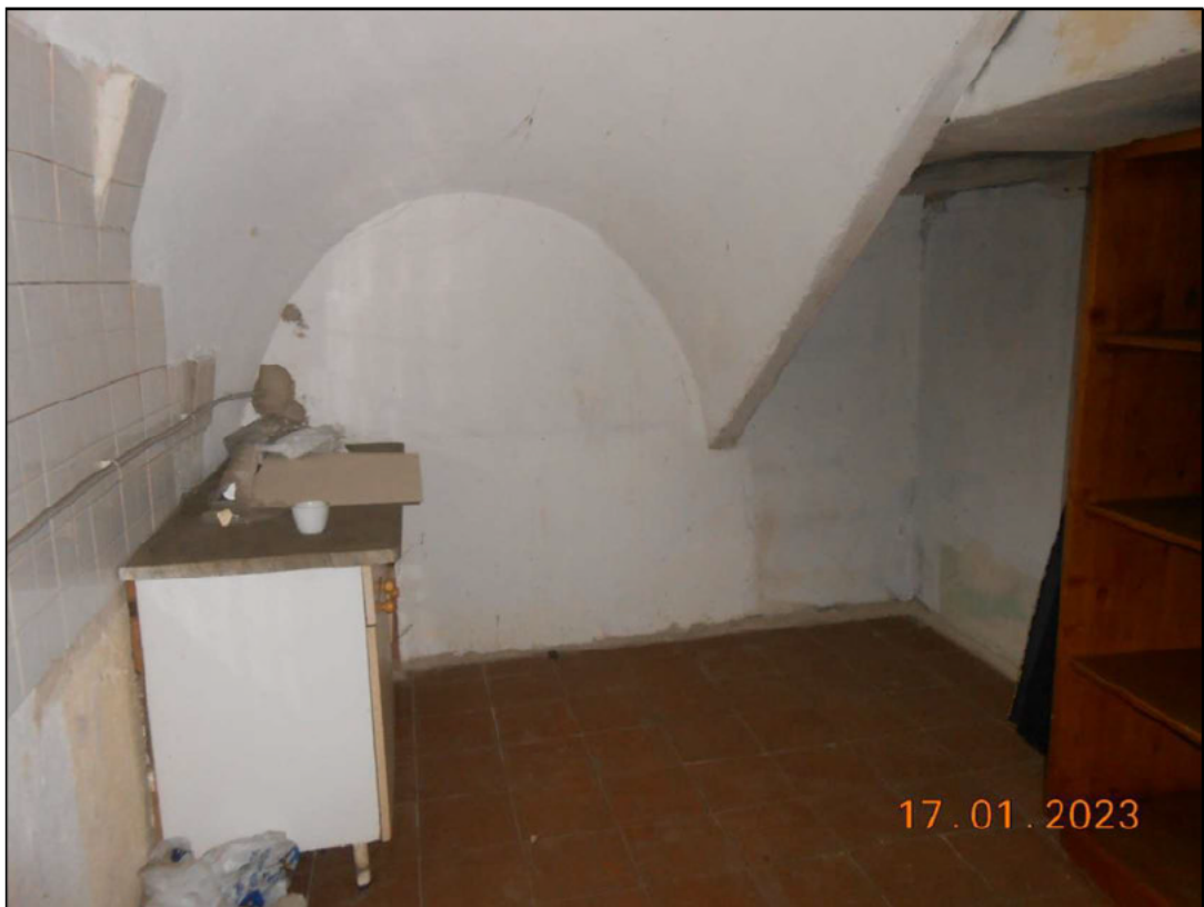
FOTO N. 30 Vista interna del piano terra.
