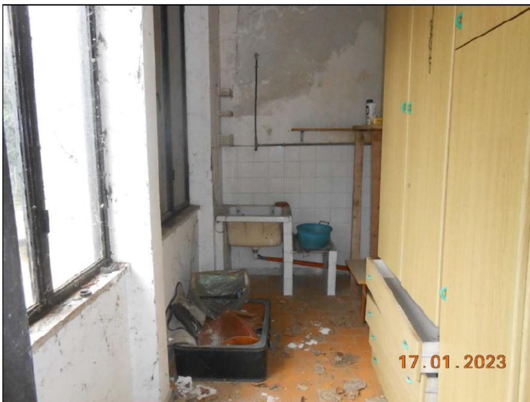
FOTO N. 56 Vista della lavanderia al piano primo.
