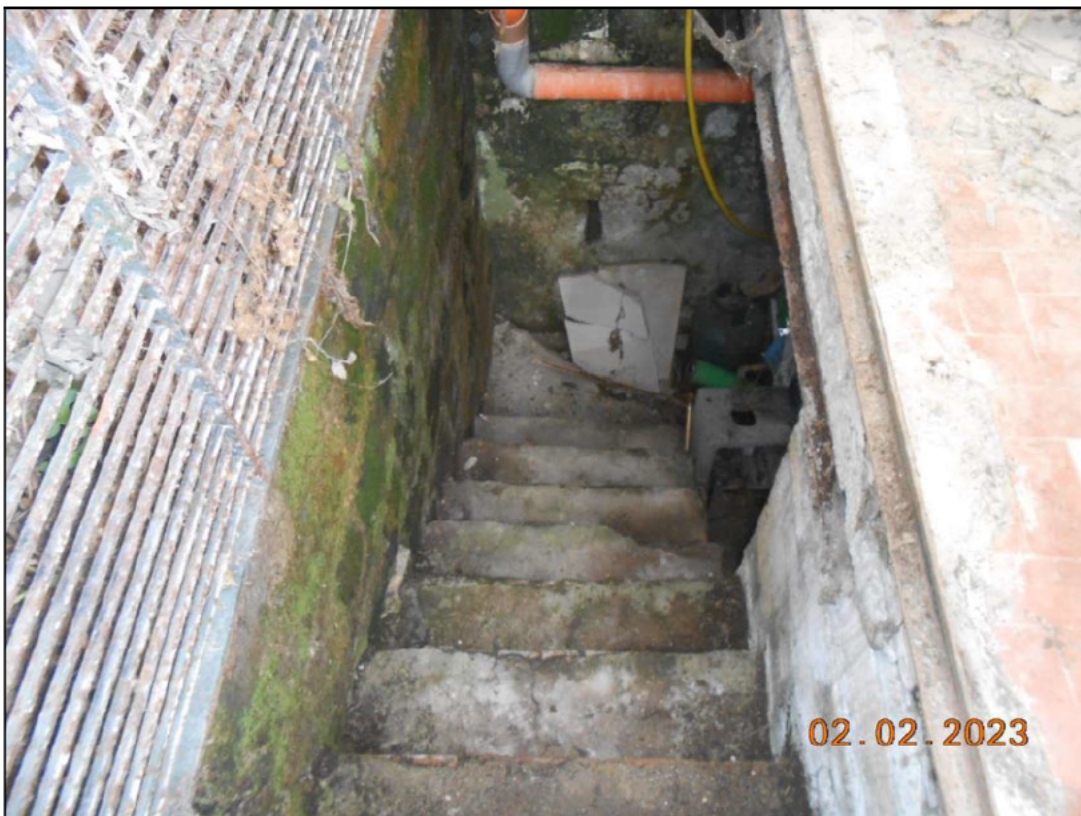
FOTO N. 08 Vista scala esterna di accesso al piano interrato.
