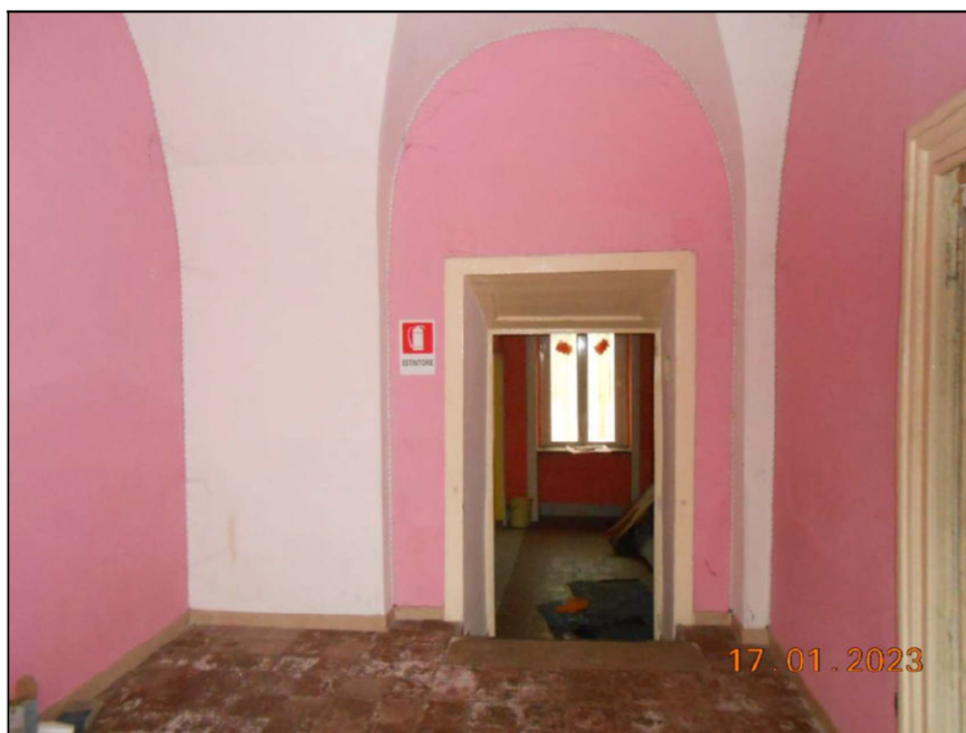
FOTO N. 26 Vista interna del piano terra.
